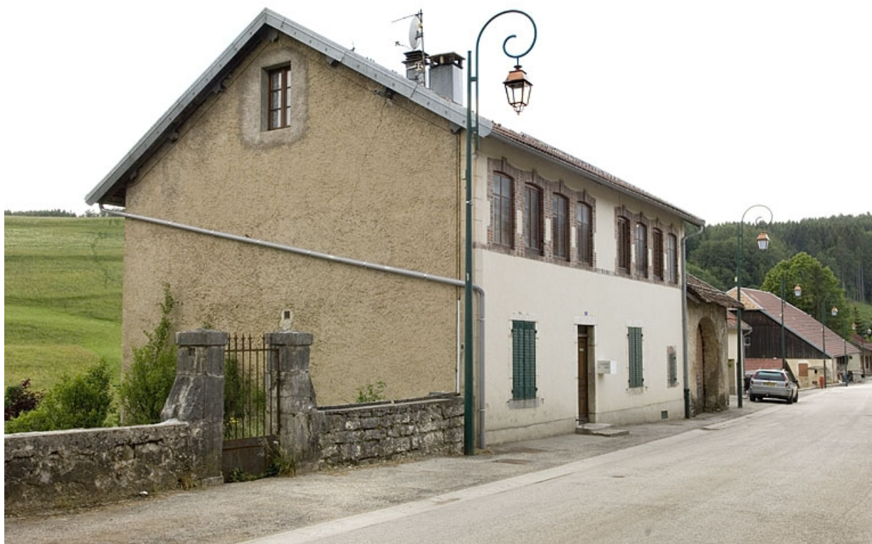
Façade antérieure et façade latérale gauche, côté rue du Faubourg. 25, Jougne, 7 rue du Faubourg
