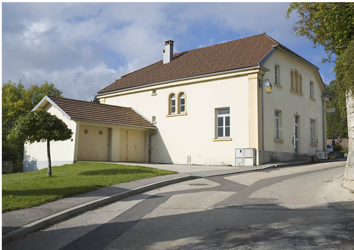
Façade postérieure et façade latérale sur rue. 25, Jougne place du Mont-d'Or
