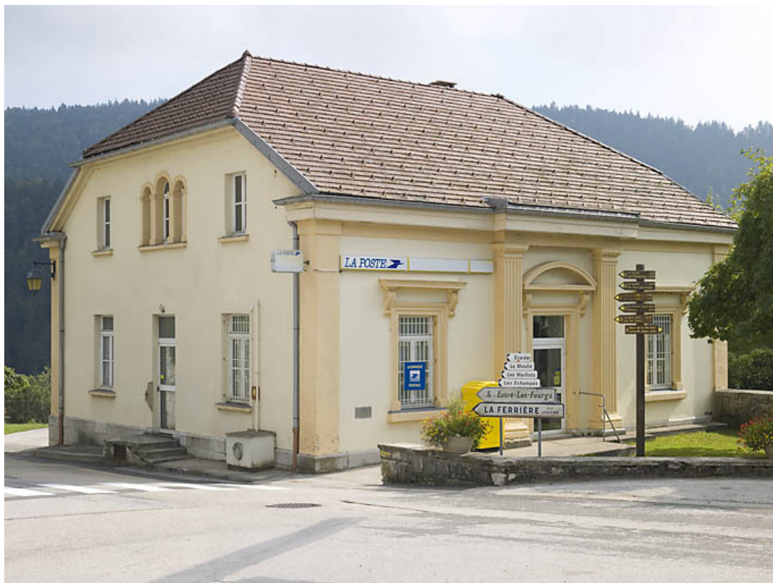
Façade antérieure et façade latérale gauche. 25, Jougne place du Mont-d'Or
