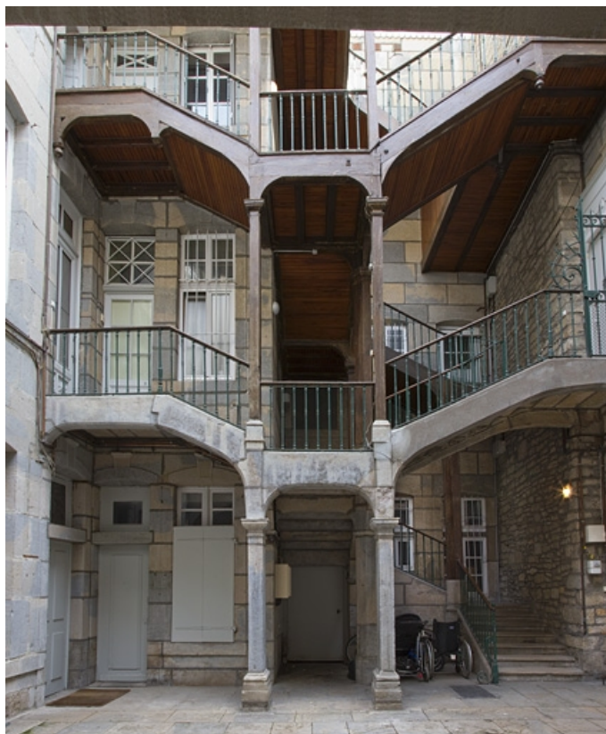
Escalier à cage ouverte sur la première cour : vue d'ensemble, de face.
