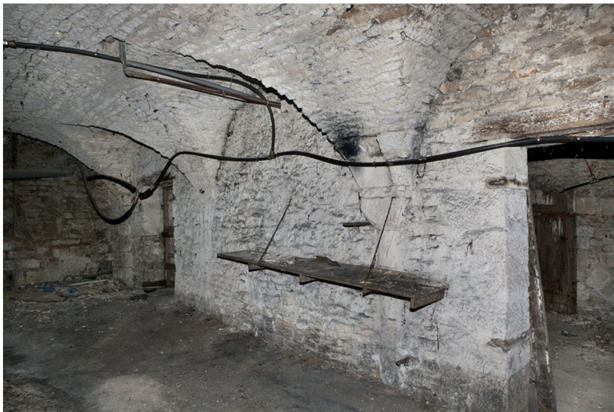
Logis principal, sous-sol : cave C, partie gauche, mur droit.
