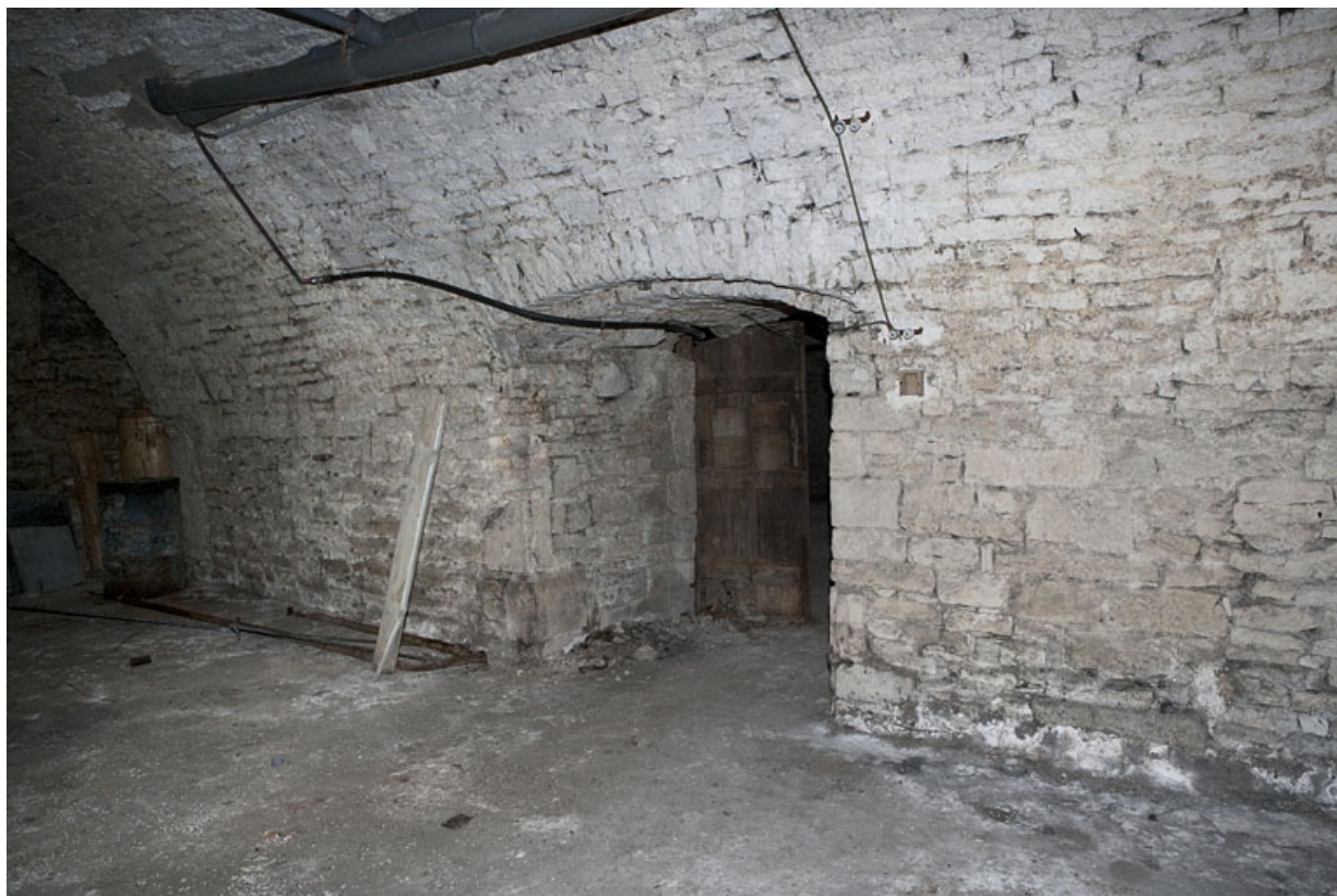
Logis principal, sous-sol : cave D, détail de la porte de communication avec la cave C. 25, Besançon Grande Rue 53, lieudit : îlot Bouteiller
