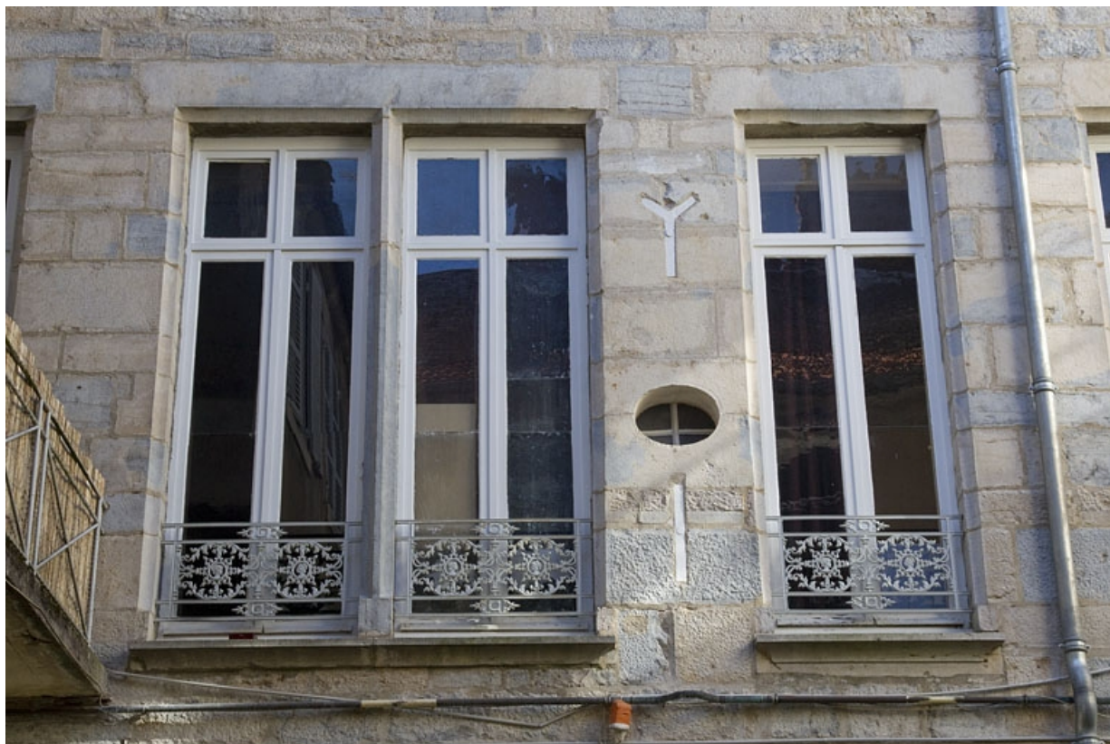
Premier logis secondaire : détail de la forme des fenêtres de la façade postérieure.
