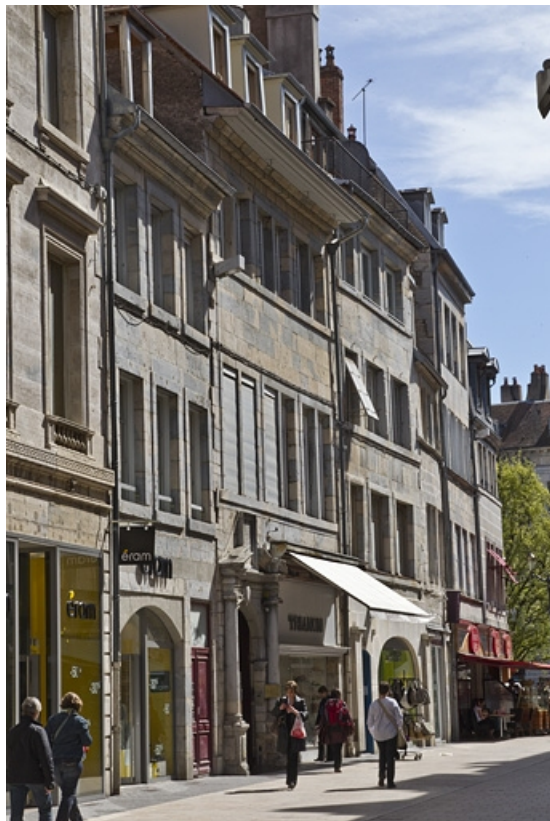
Façade antérieure du logis principal : de trois quarts gauche.
