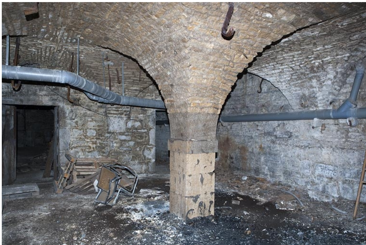
Logis principal, sous-sol : cave B, vue d'ensemble, depuis le fond.
