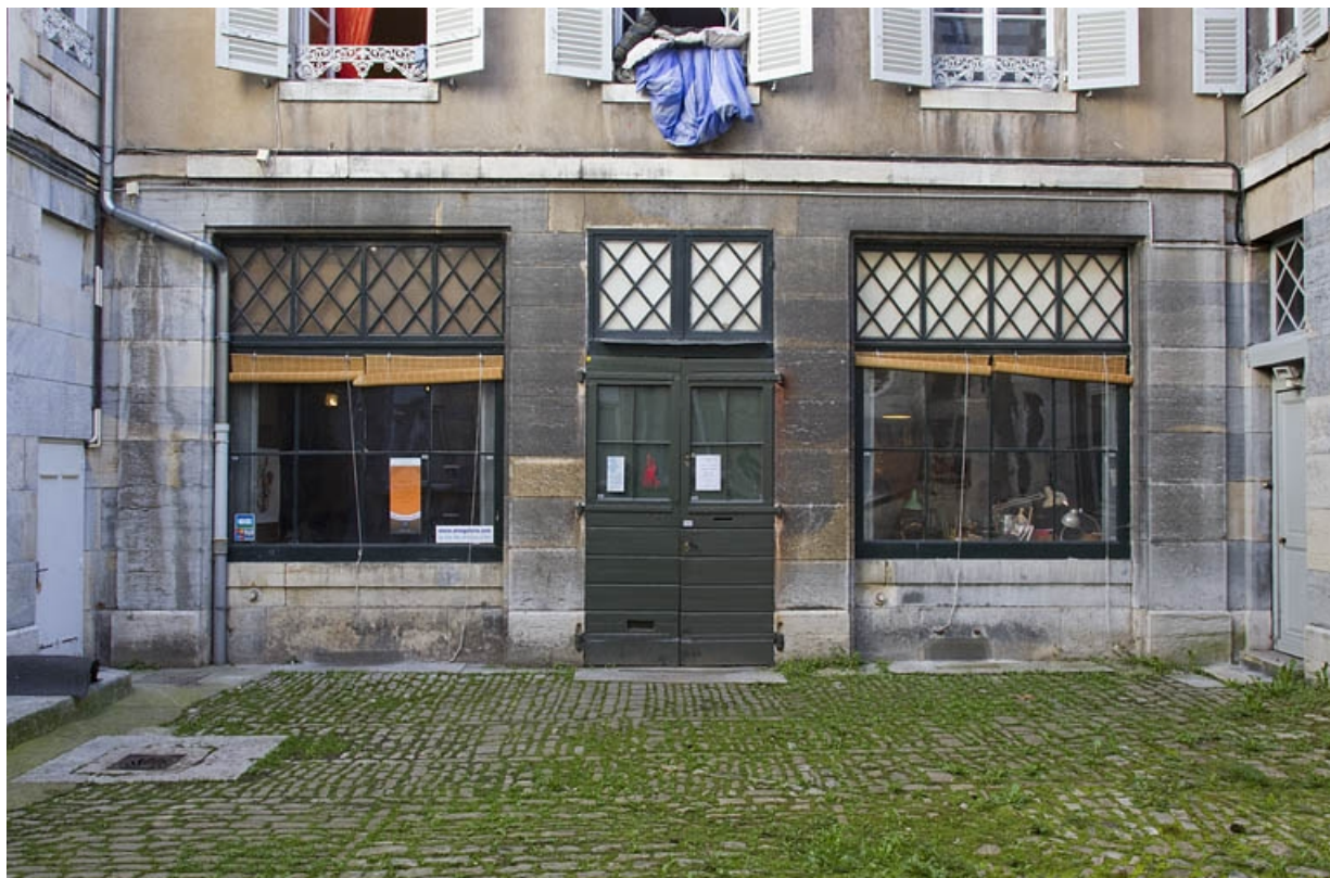
Façade antérieure du deuxième logis secondaire : détail du rez-de-chaussée.
