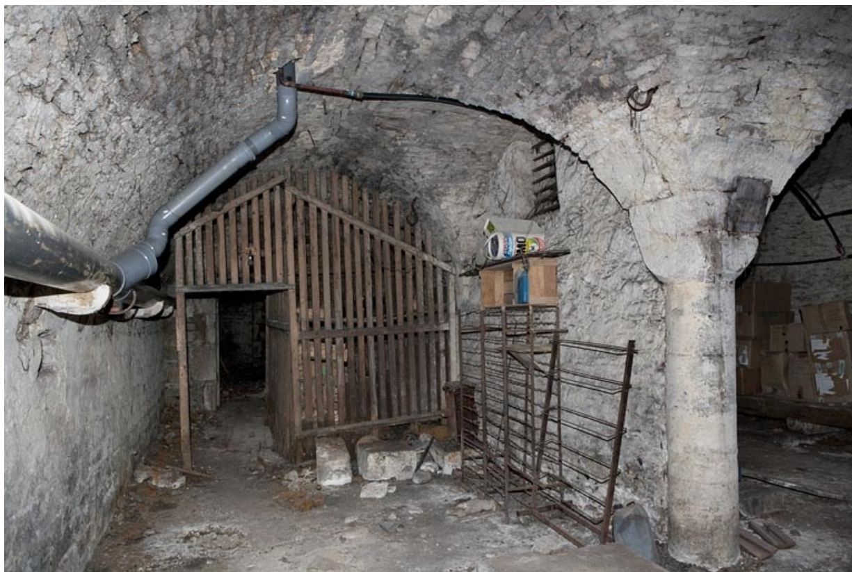
Logis principal, sous-sol : cave A, vue de la partie droite depuis le fond.
