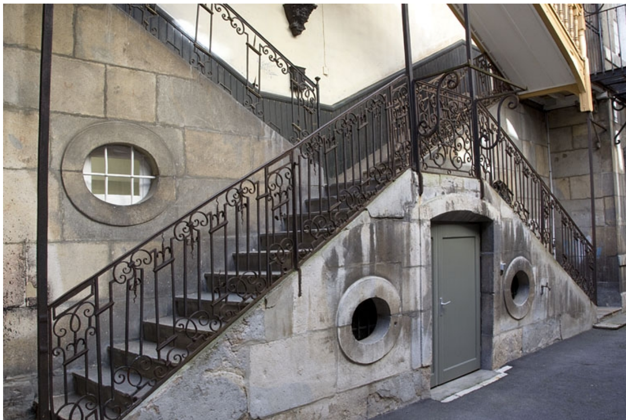
Première cour : détail du départ de l'escalier à cage ouverte.
