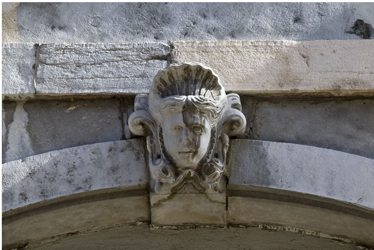
Logis principal, façade sur rue : détail d'un mascaron ornant la clé de l'arc de la boutique.
