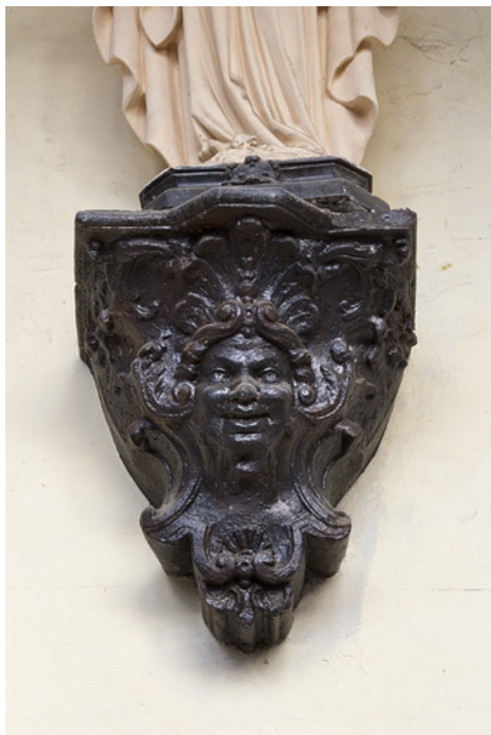
Première cour, escalier à cage ouverte : détail de la console supportant une statue dans la cage de l'escalier. 25, Besançon Grande Rue 33, lieudit : îlot Bouteiller
