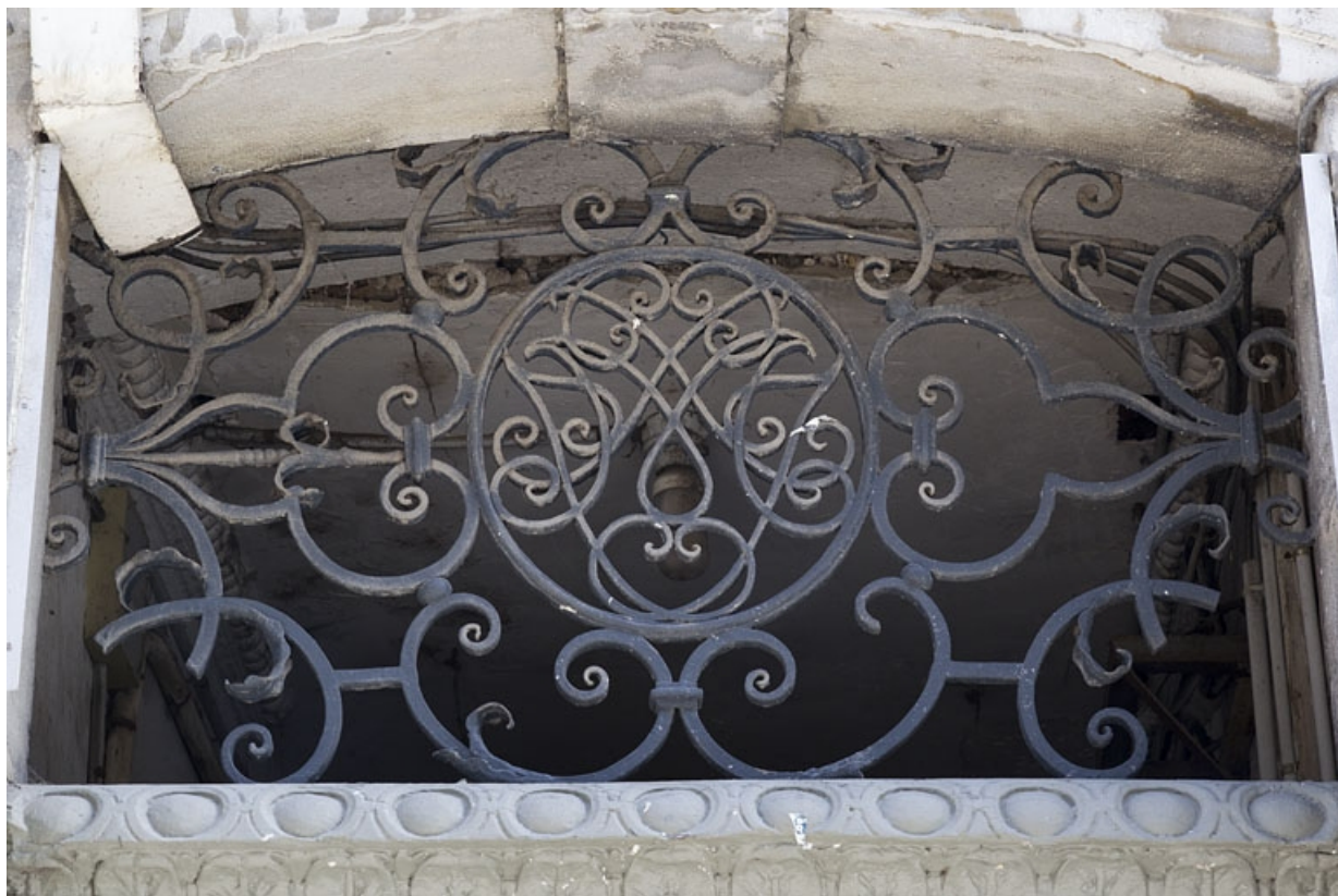
Logis principal, façade sur rue : détail du dessus de porte en ferronnerie de la porte du couloir. 25, Besançon Grande Rue 33, lieudit : îlot Bouteiller
