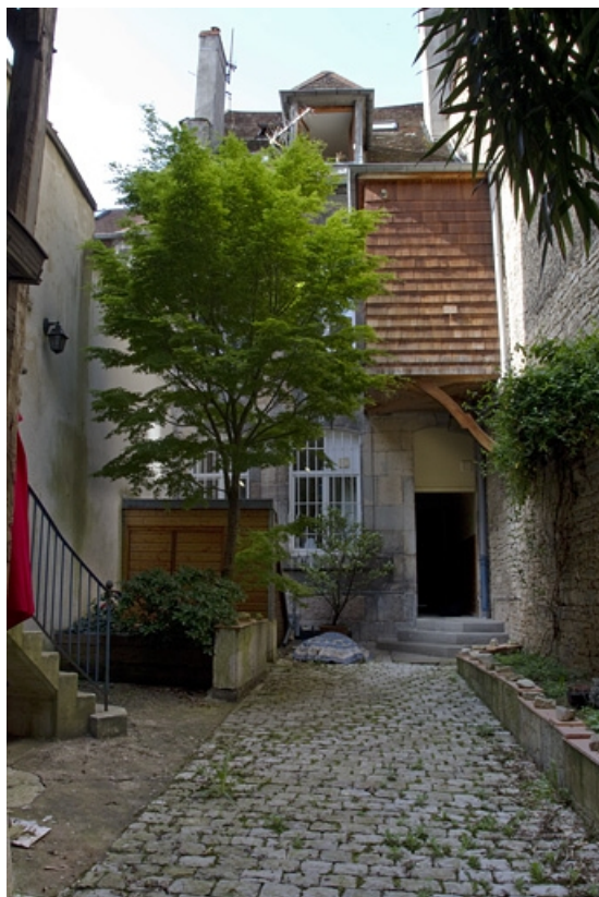
Deuxième cour : vue d'ensemble de la façade postérieure du premier logis secondaire. 25, Besançon Grande Rue 33, lieudit : îlot Bouteiller
