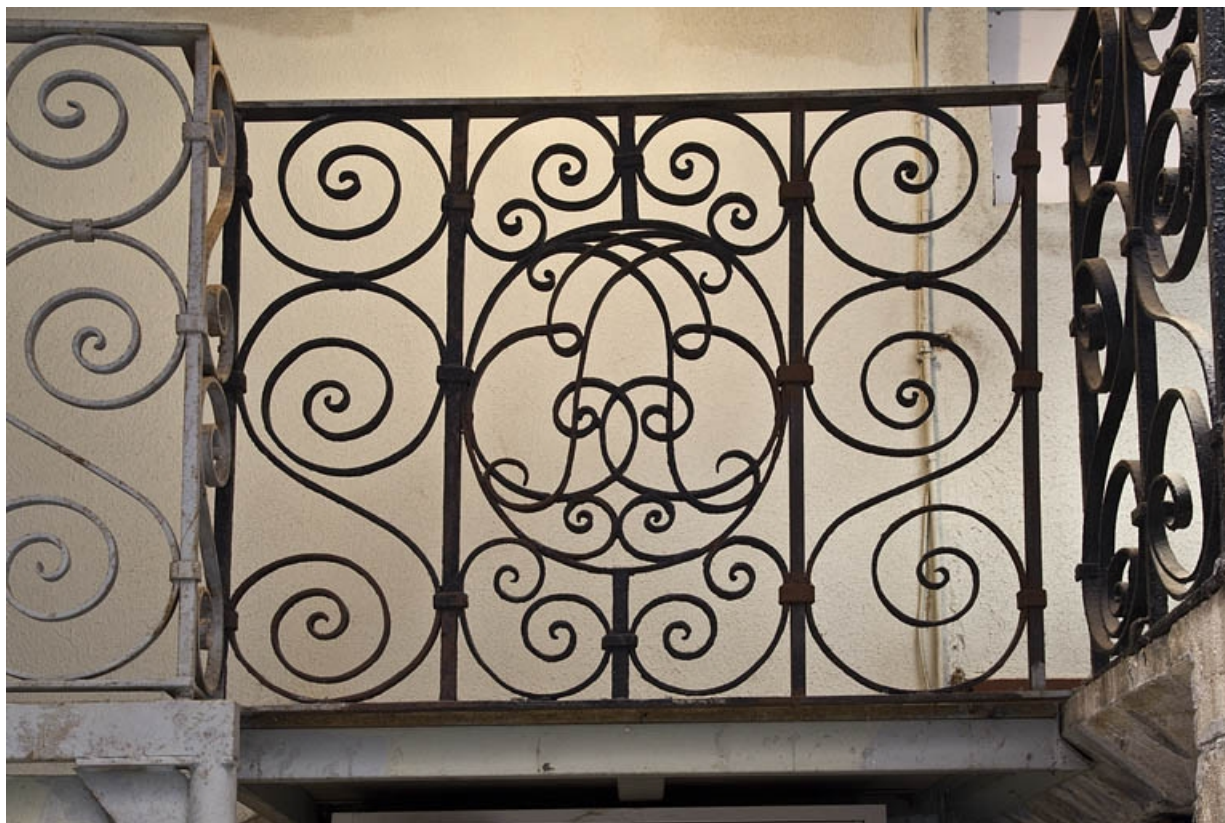
Première cour, escalier à cage ouverte : détail d'un panneau de la rampe en fer forgé avec un monogramme. 25, Besançon Grande Rue 35, lieudit : îlot Bouteiller
