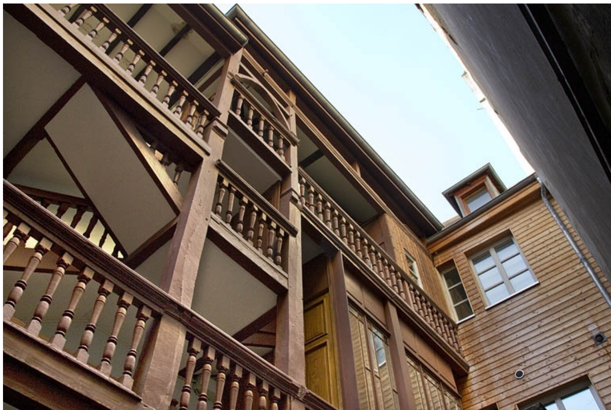
Première cour, escalier à cage ouverte : détail de la partie supérieure en charpente.
