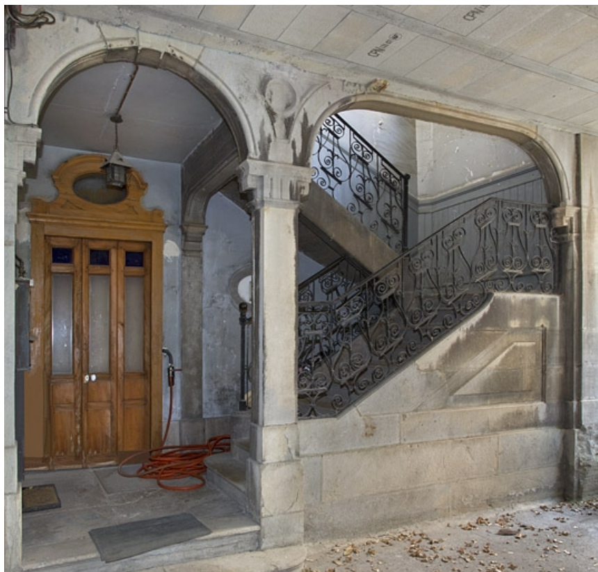
Deuxième cour, logis secondaire en fond de parcelle : détail de l'escalier et de la porte d'entrée. 25, Besançon Grande Rue 35, lieudit : îlot Bouteiller
