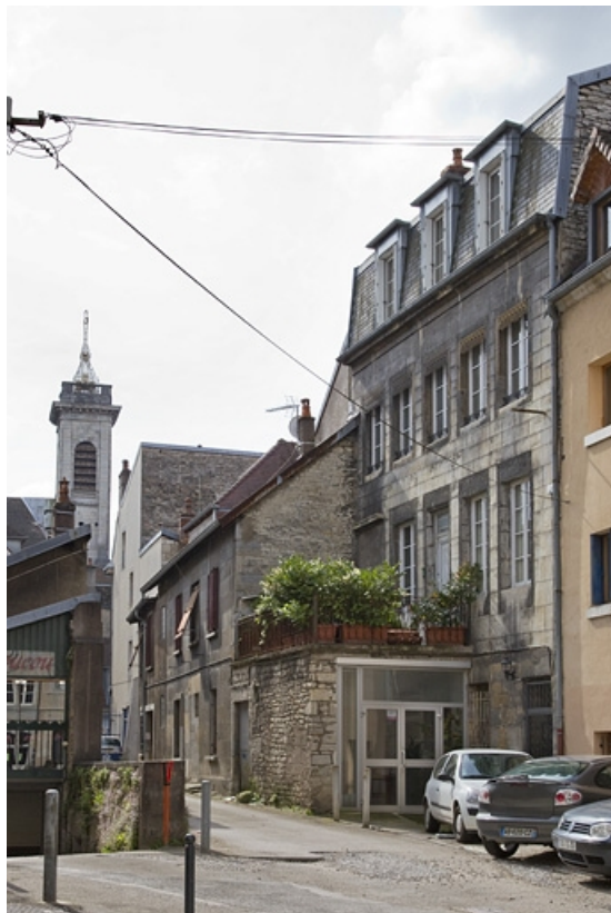
Logis secondaire en fond de parcelle : façade postérieure de trois quarts droit. 25, Besançon Grande Rue 35, lieudit : îlot Bouteiller
