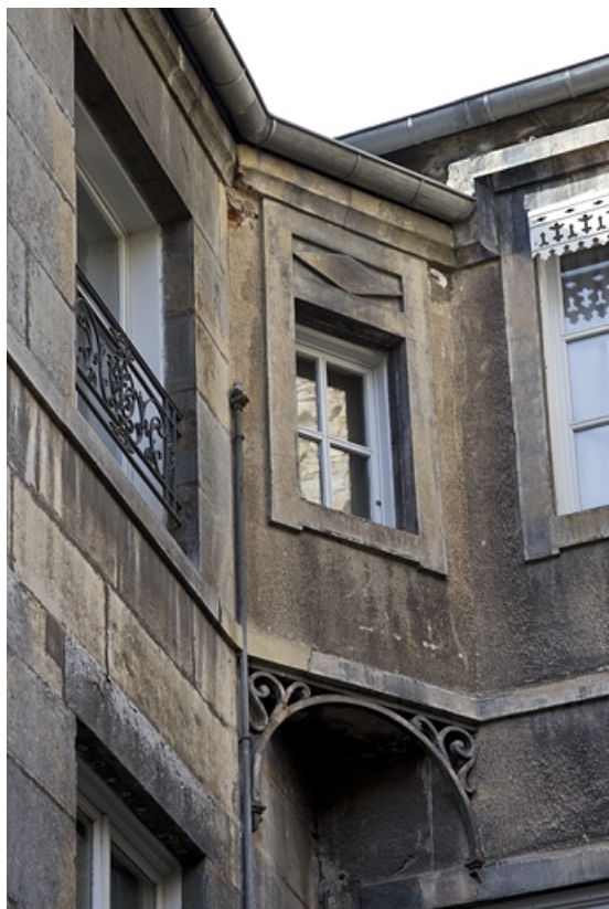
Deuxième cour, façade postérieure du premier logis secondaire : détail d'angle au niveau du premier étage. 25, Besançon Grande Rue 35, lieudit : îlot Bouteiller
