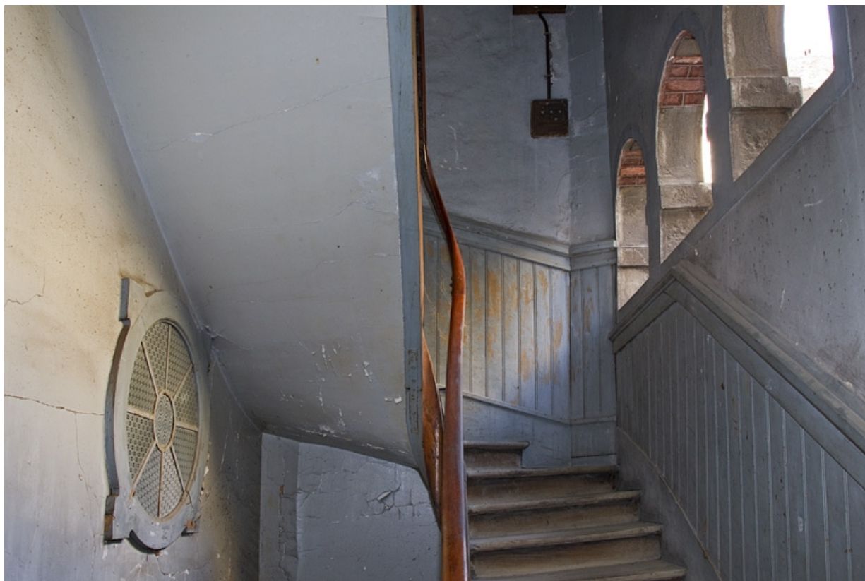
Deuxième cour, logis secondaire en fond de cour : détail de l'intérieur de l'escalier.
