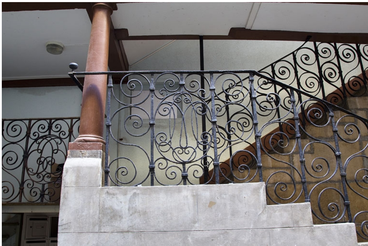
Première cour, escalier à cage ouverte : détail de la rampe en fer forgé.
