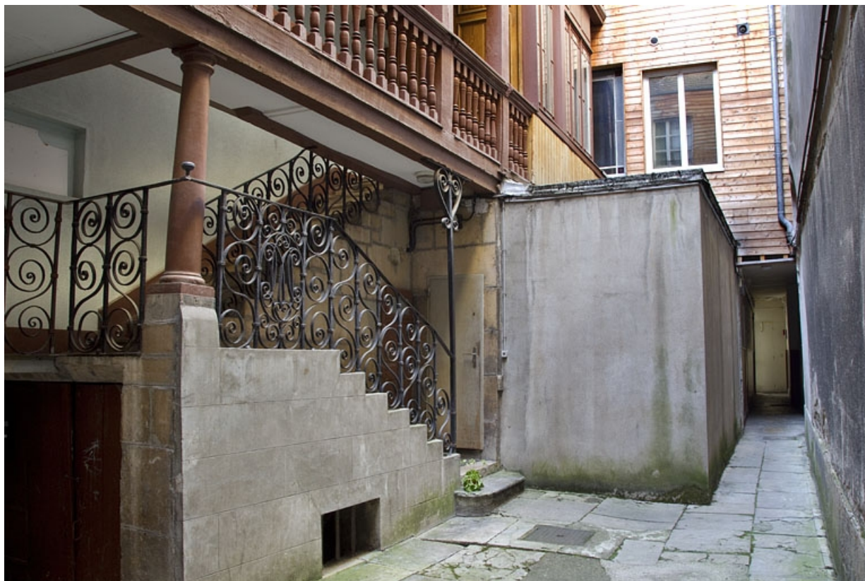
Première cour, escalier à cage ouverte : détail de la ferronnerie des deux premières volées, de trois quarts gauche. 25, Besançon Grande Rue 35, lieudit : îlot Bouteiller
