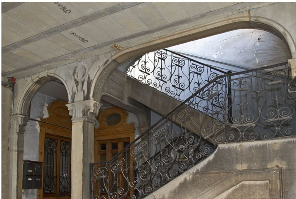
Deuxième cour, logis secondaire en fond de parcelle : détail des premières volées de l'escalier.
