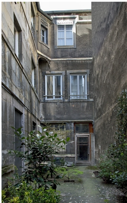
Deuxième cour, façade postérieure du premier logis secondaire : vue d'ensemble. 25, Besançon Grande Rue 35, lieudit : îlot Bouteiller
