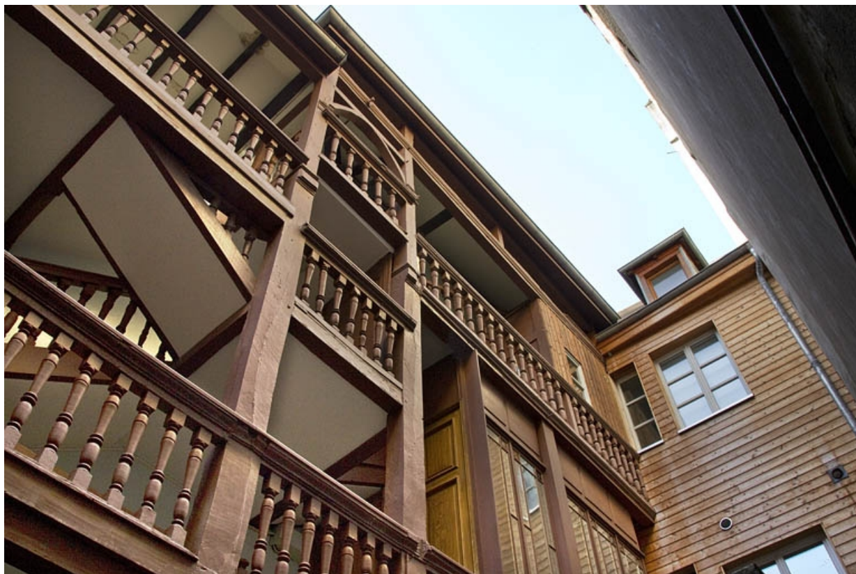
Première cour, escalier à cage ouverte : détail de la partie supérieure en charpente.
