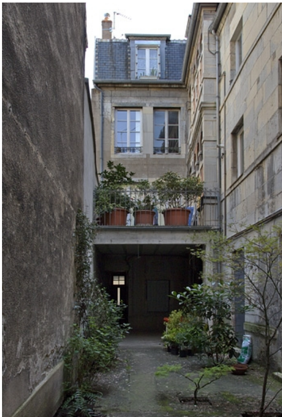
Deuxième cour : vue d'ensemble du logis secondaire en fond de cour.
