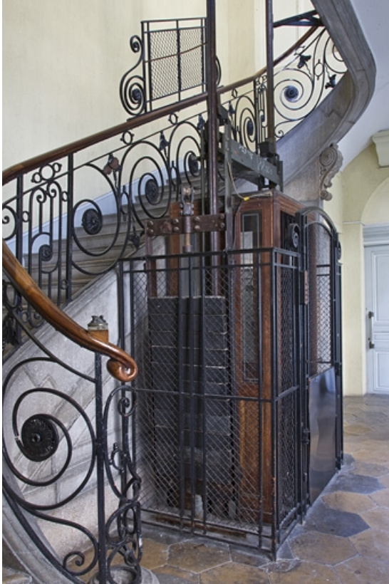
Aile droite : détail du départ de l'escalier et de l'ascenseur, vue rapprochée. 25, Besançon Grande Rue 49, lieudit : îlot Bouteiller
