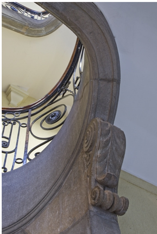
Aile droite, escalier : détail d'un modillon du limon. 25, Besançon Grande Rue 49, lieudit : îlot Bouteiller
