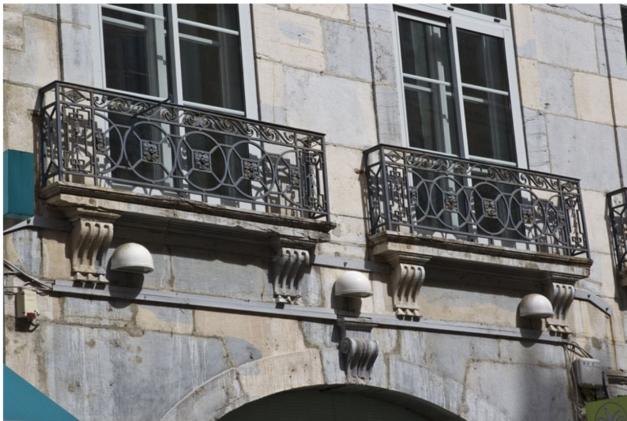
Logis principal, façade antérieure : détail de deux garde-corps en ferronnerie, fenêtres du premier étage. 25, Besançon Grande Rue 39, lieudit : îlot Bouteiller
