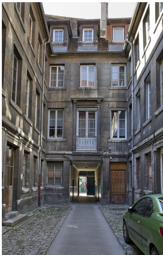
Logis principal : vue d'ensemble des façades depuis le fond de la cour. 25, Besançon Grande Rue 39, lieudit : îlot Bouteiller
