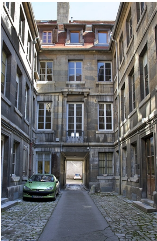
Logis principal : vue d'ensemble des façades en fond de cour.
