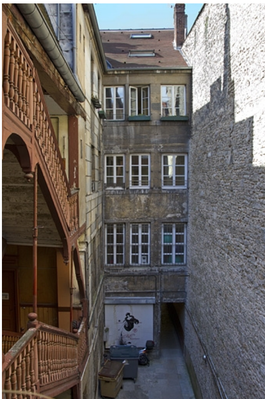
Logis principal : vue d'ensemble de la façade postérieure depuis l'escalier à cage ouverte. 25, Besançon, 41 Grande Rue, lieudit : îlot Bouteiller
