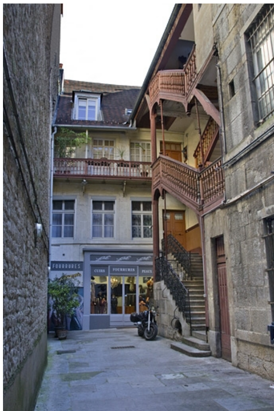
Logis secondaire : vue d'ensemble depuis l'entrée de la cour.
