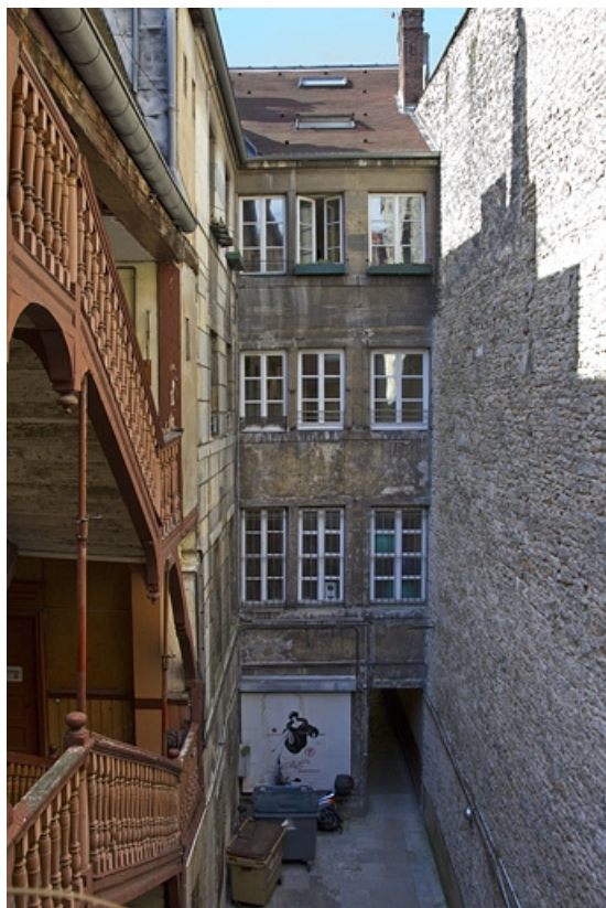
Logis principal : vue d'ensemble de la façade postérieure depuis l'escalier à cage ouverte. 25, Besançon, 41 Grande Rue, lieudit : îlot Bouteiller
