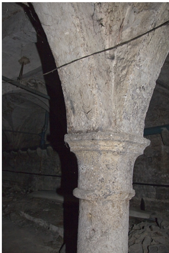
Logis principal : détail du chapiteau d'une colonne soutenant les voûtes de de la cave. 25, Besançon, 41 Grande Rue, lieudit : îlot Bouteiller
