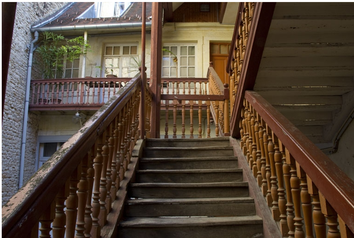
Vue d'ensemble du balcon de l'étage du logis secondaire et de l'intérieur de l'escalier à cage ouverte.
