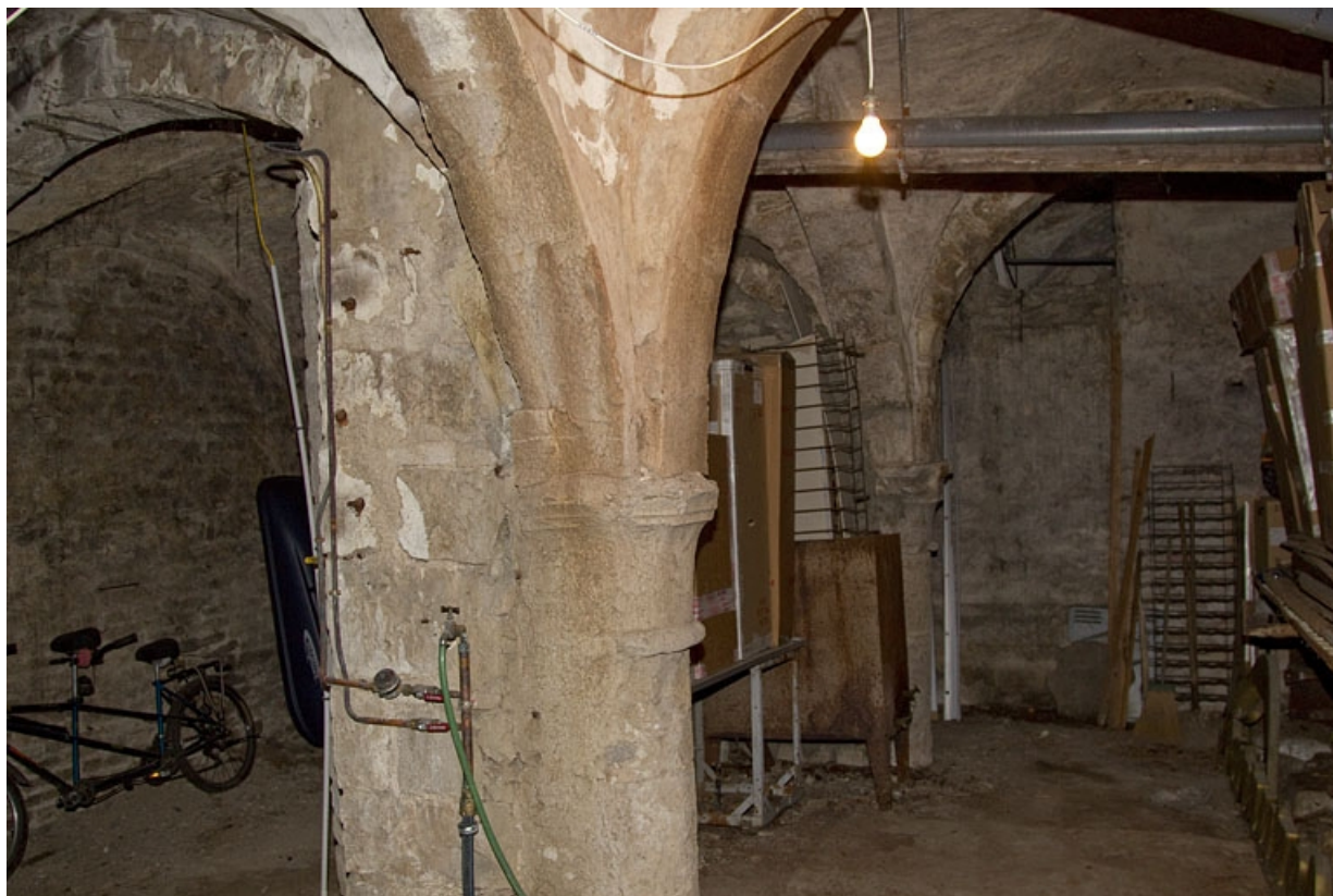
Logis principal : vue d'ensemble d'une partie de la cave.
