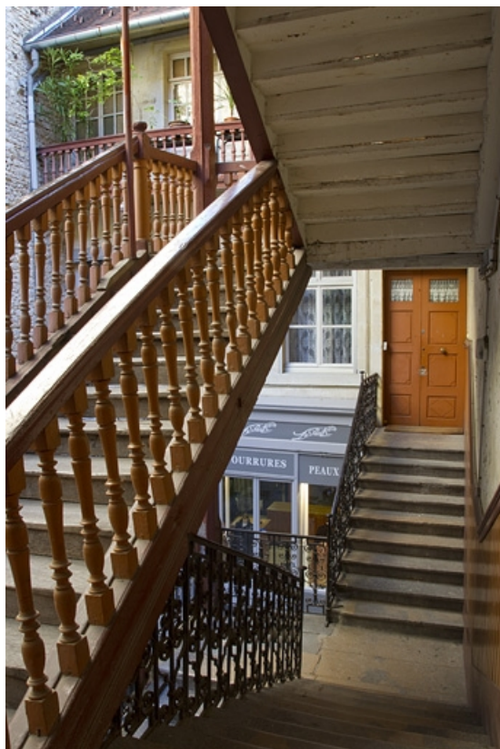
Escalier à cage ouverte : vue des volées depuis l'intérieur.
