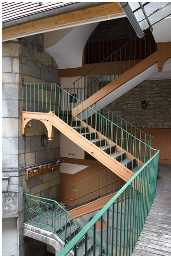
Vue d'ensemble de l'escalier à cage ouverte sur cour. 25, Besançon, 16 rue des Granges, lieudit : îlot Bouteiller
