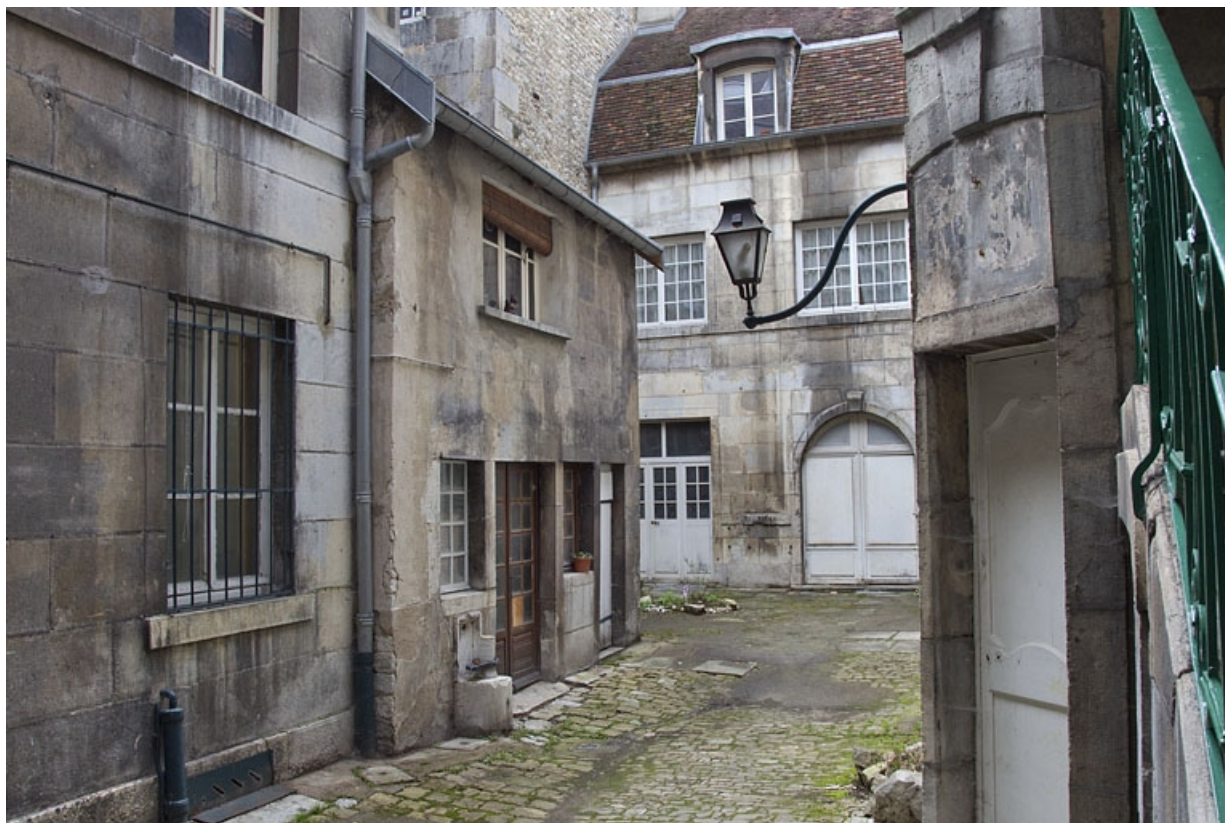
Logis secondaire gauche : détail de l'extrémité de l'aile, de trois quarts gauche. 25, Besançon, 16 rue des Granges, lieudit : îlot Bouteiller
