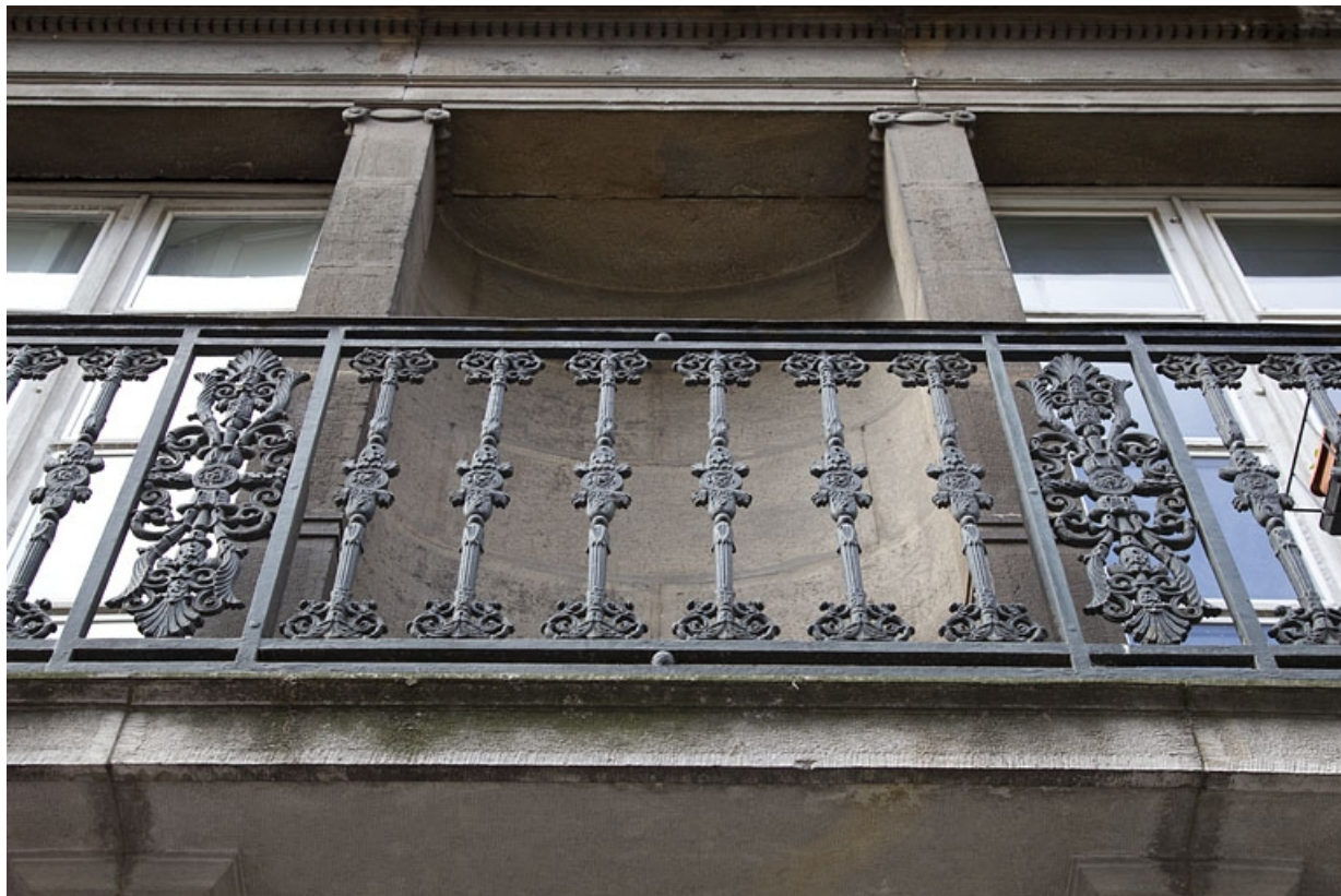
Logis principal, façade sur rue : détail du balcon en fonte du premier étage.
