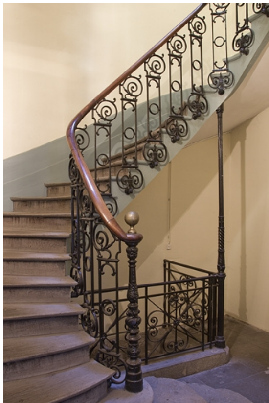
Logis principal droit : détail du départ de l'escalier.
