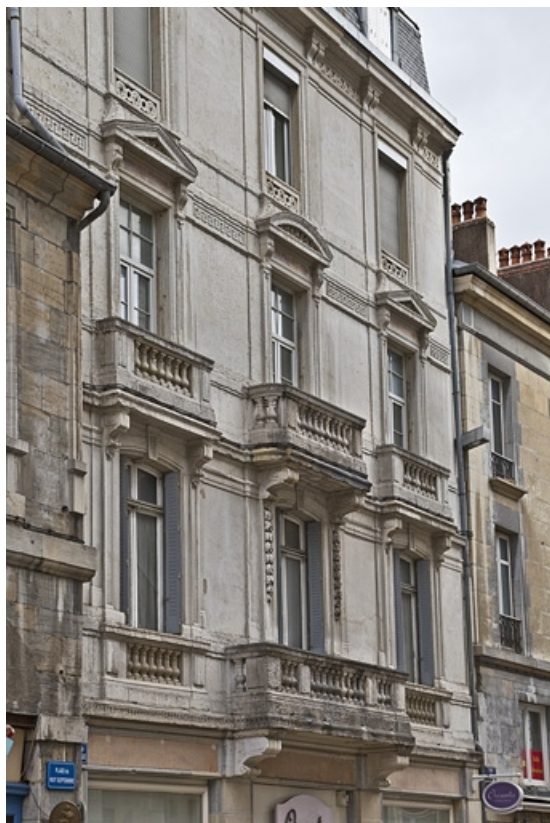
Logis principal droit : détail de la façade sur rue, de trois quarts gauche.
