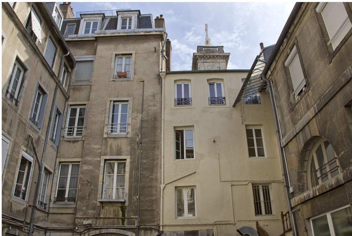
Vue d'ensemble des façade postérieures des deux logis principaux, de face.
