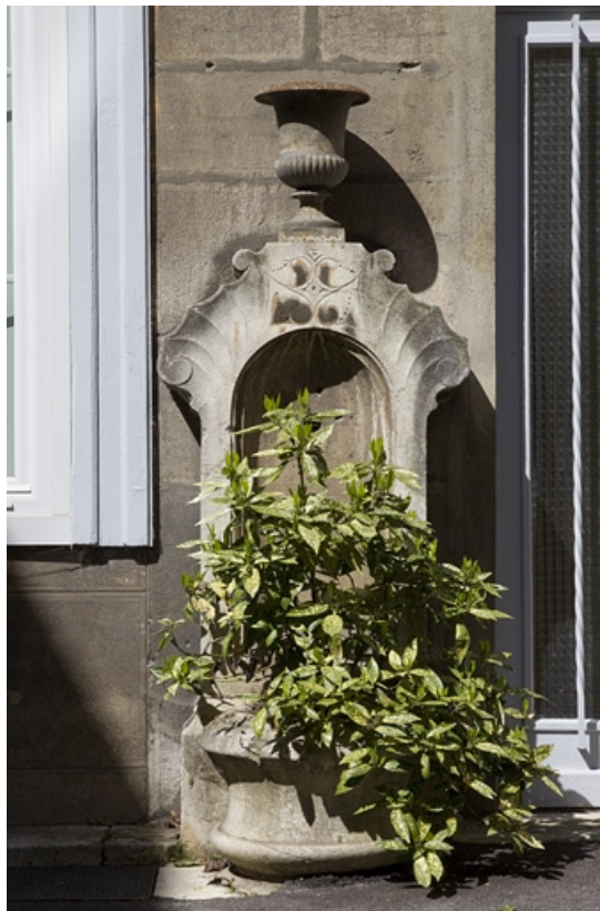
Détail de la borne-fontaine située au fond de la cour.
