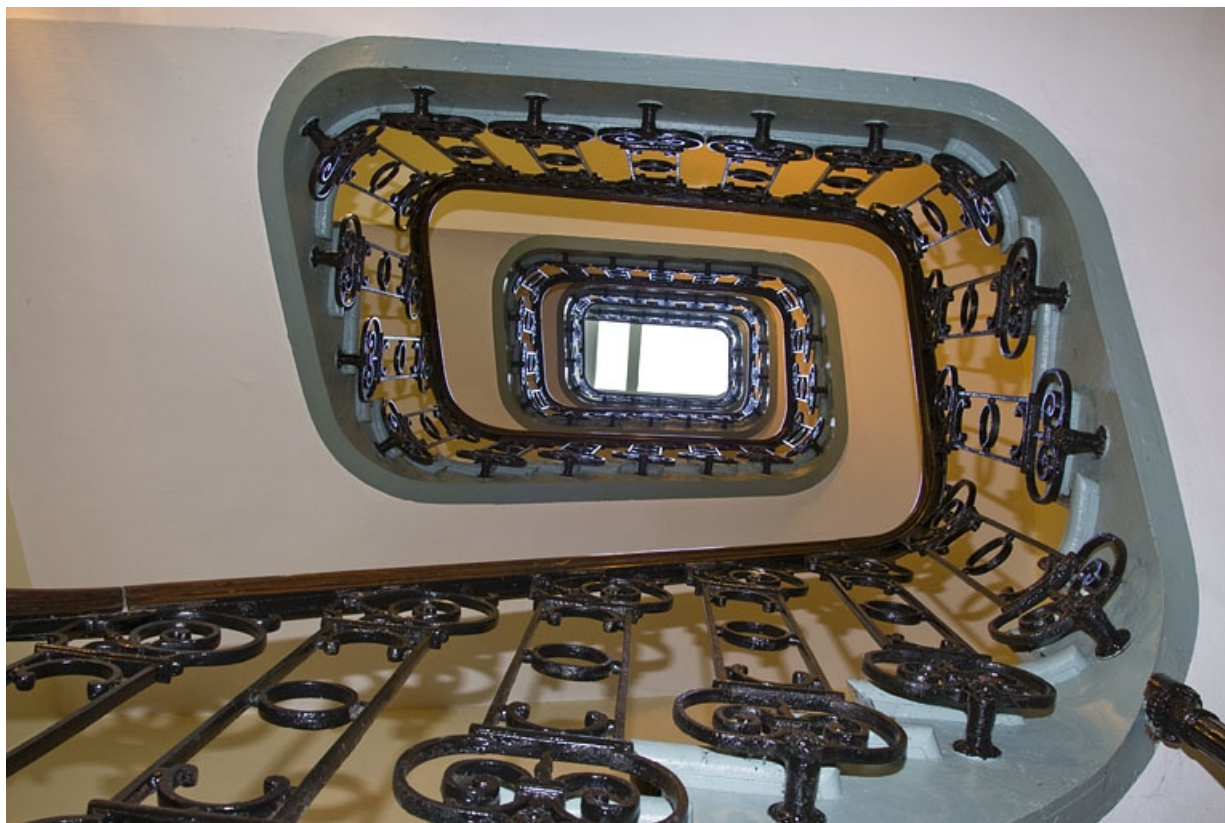
Logis principal droit : vue d'ensemble de l'escalier, en contre-plongée.
