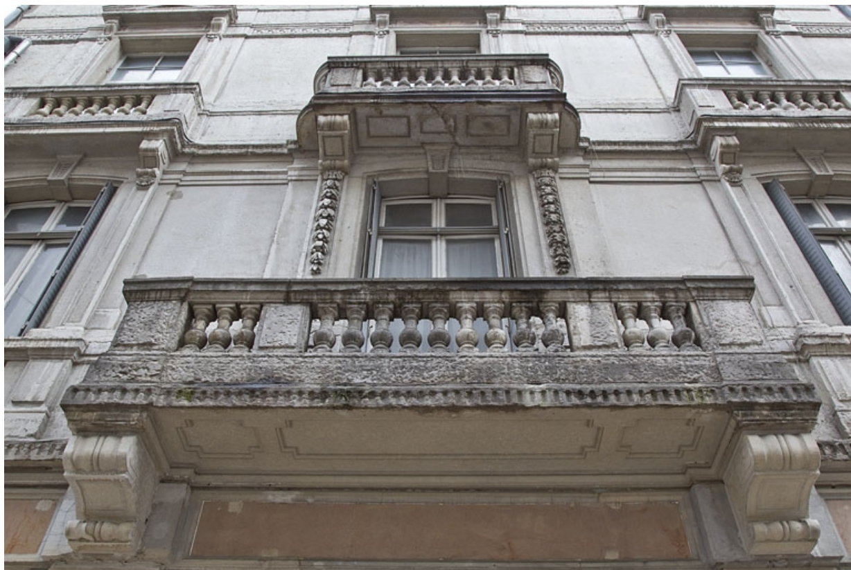
Logis principal droit : détail des balcons en pierre de la façade sur rue, en contre-plongée.
