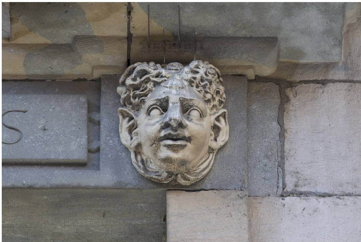
Façade antérieure, partie droite, quatrième fenêtre de l'étage à partir de la droite : détail du mascaron droit. 25, Besançon, 2, 4 rue des Granges, lieudit : îlot Bouteiller
