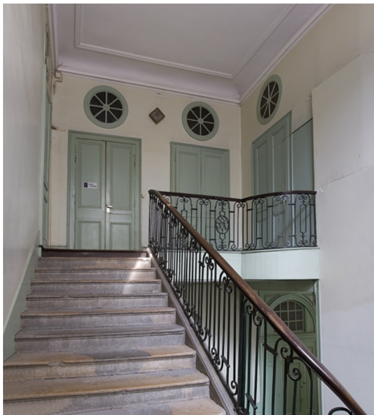
Intérieur, escalier d'honneur : détail de la partie supérieure droite.
