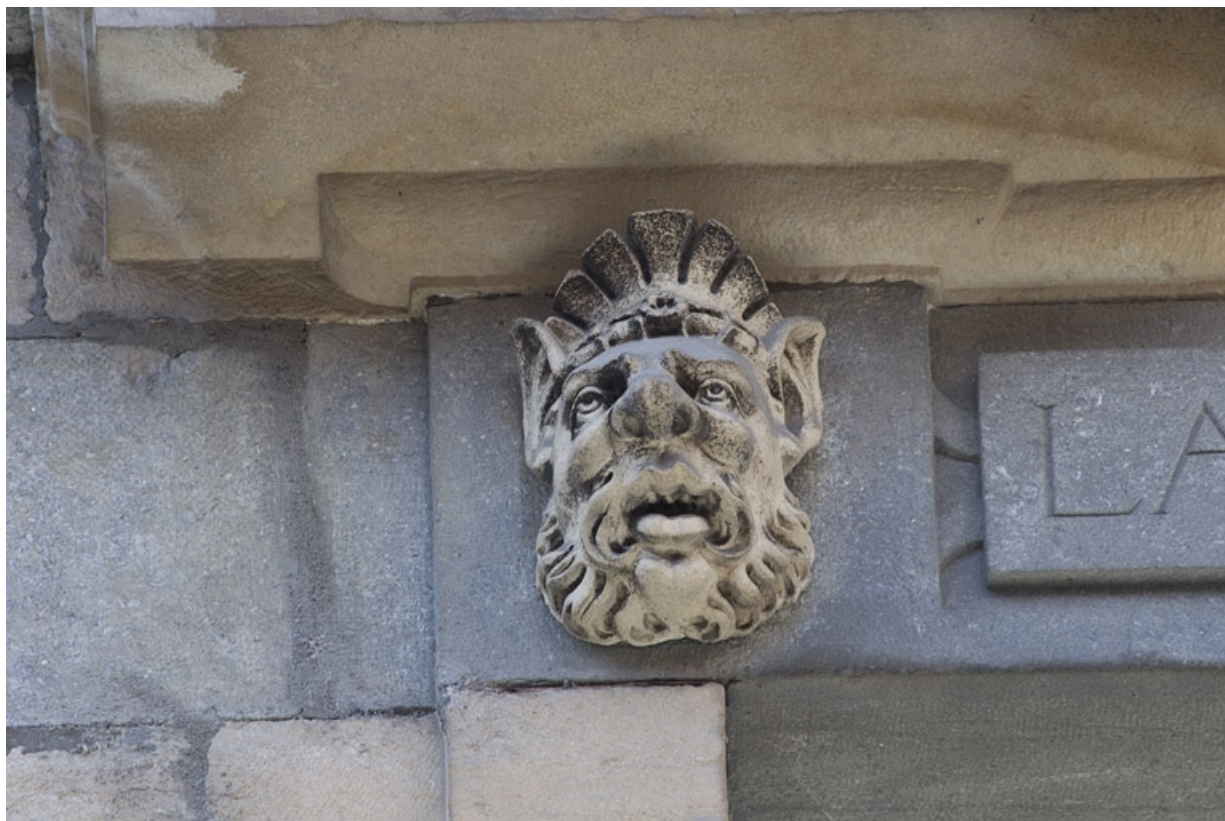
Façade antérieure, partie droite, quatrième fenêtre de l'étage à partir de la droite : détail du mascaron gauche. 25, Besançon, 2, 4 rue des Granges, lieudit : îlot Bouteiller
