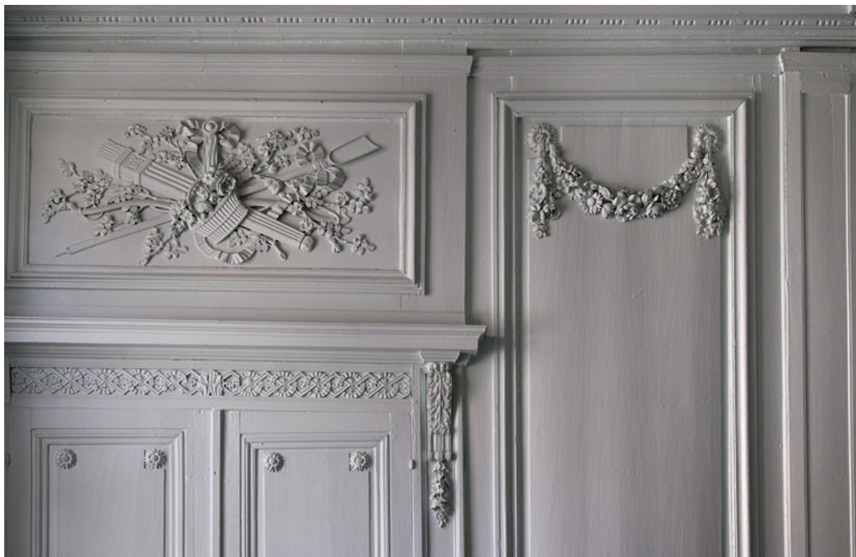
Intérieur, salon : détail du décor d'un dessus de porte et de la partie supérieure d'un lambris. 25, Besançon, 2, 4 rue des Granges, lieudit : îlot Bouteiller
