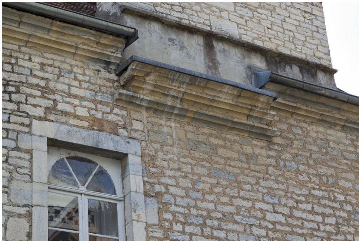
Façade latérale droite : détail de la corniche sous le toit.
