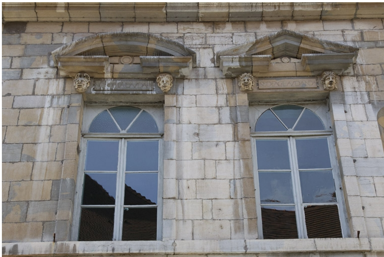
Façade antérieure, partie droite, premier étage : vue d'ensemble de la cinquième et sixième fenêtres à partir de la droite. 25, Besançon, 2, 4 rue des Granges, lieudit : îlot Bouteiller
