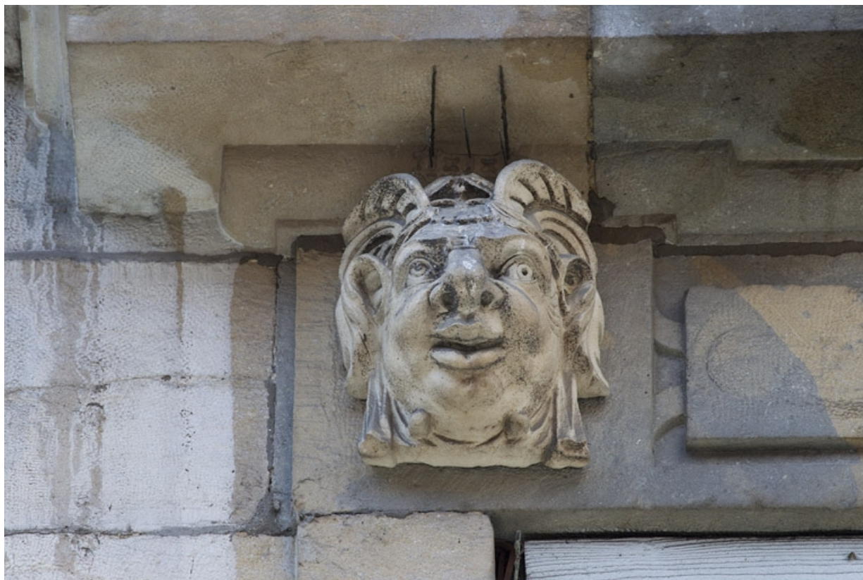
Façade antérieure, partie droite, troisième fenêtre de l'étage à partir de la droite : détail du mascaron gauche. 25, Besançon, 2, 4 rue des Granges, lieudit : îlot Bouteiller
