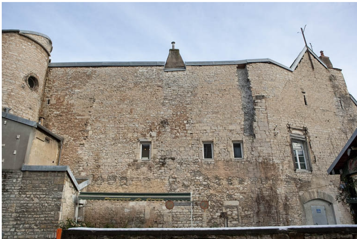
Façade postérieure donnant sur l'impasse : vue d'ensemble, de face.
