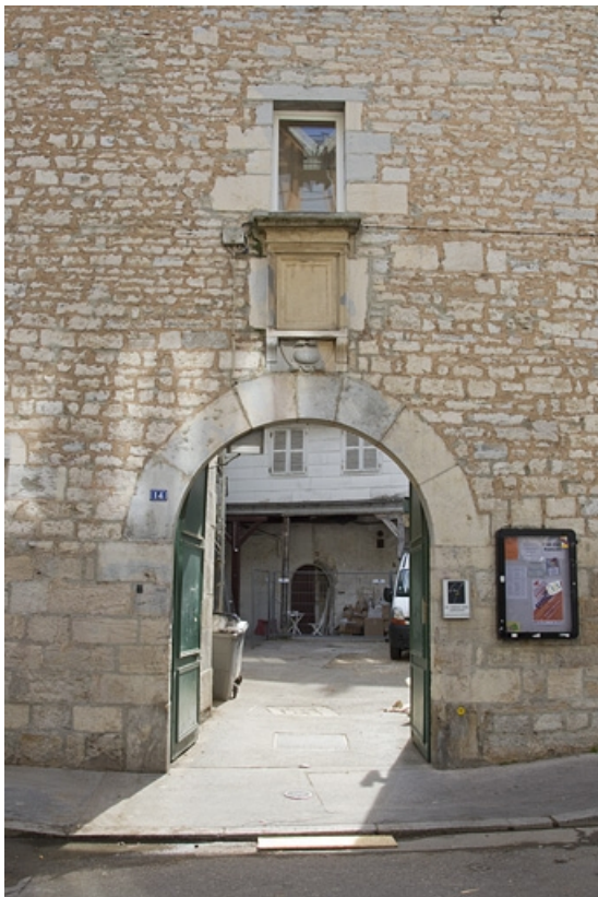
Façade latérale droite : détail du portail d'entrée.
