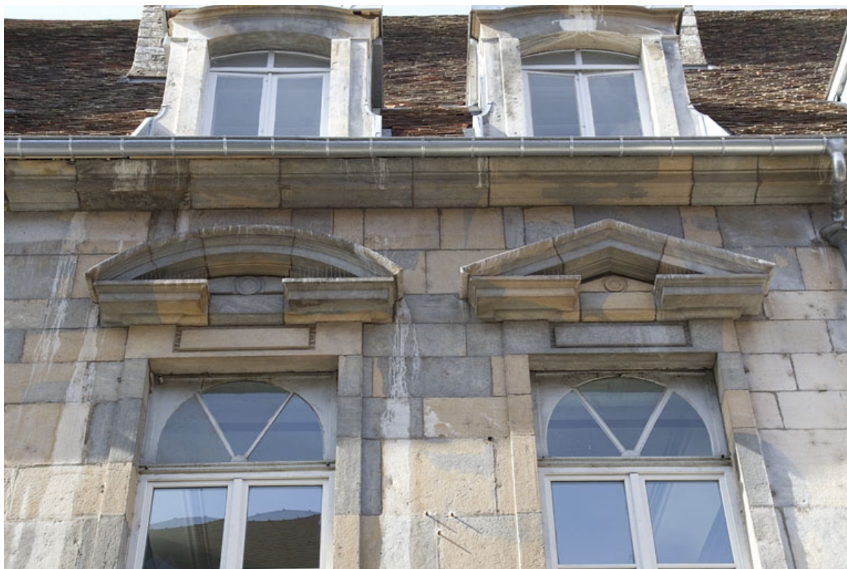
Façade antérieure, partie gauche, premier étage : détail des frontons de deux fenêtres.
