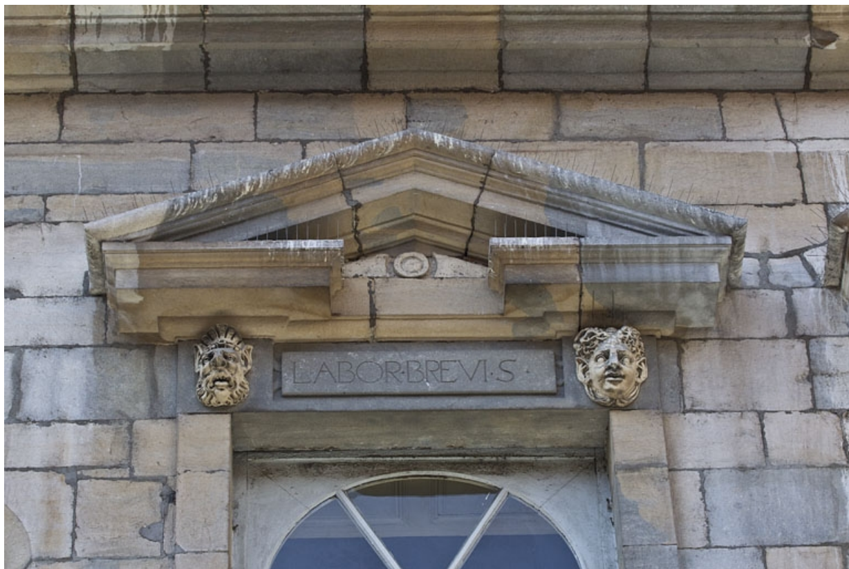
Façade antérieure, partie droite, quatrième fenêtre de l'étage à partir de la droite : détail du fronton triangulaire. 25, Besançon, 2, 4 rue des Granges, lieudit : îlot Bouteiller
