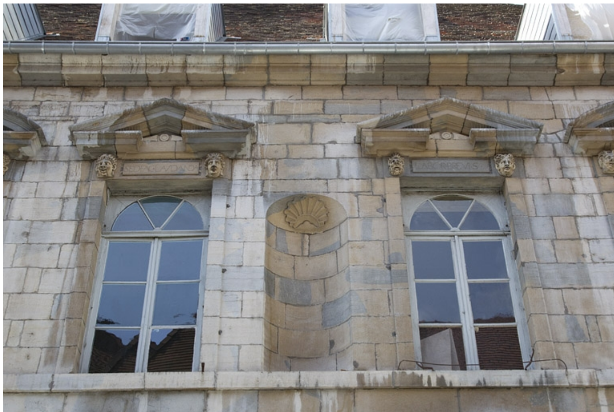
Façade antérieure, partie droite, premier étage : vue d'ensemble de la quatrième et cinquième fenêtres à partir de la droite. 25, Besançon, 2, 4 rue des Granges, lieudit : îlot Bouteiller
