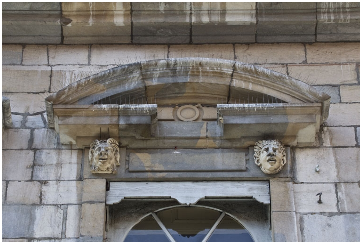
Façade antérieure, partie droite, troisième fenêtre de l'étage à partir de la droite : détail du fronton cintré. 25, Besançon, 2, 4 rue des Granges, lieudit : îlot Bouteiller
