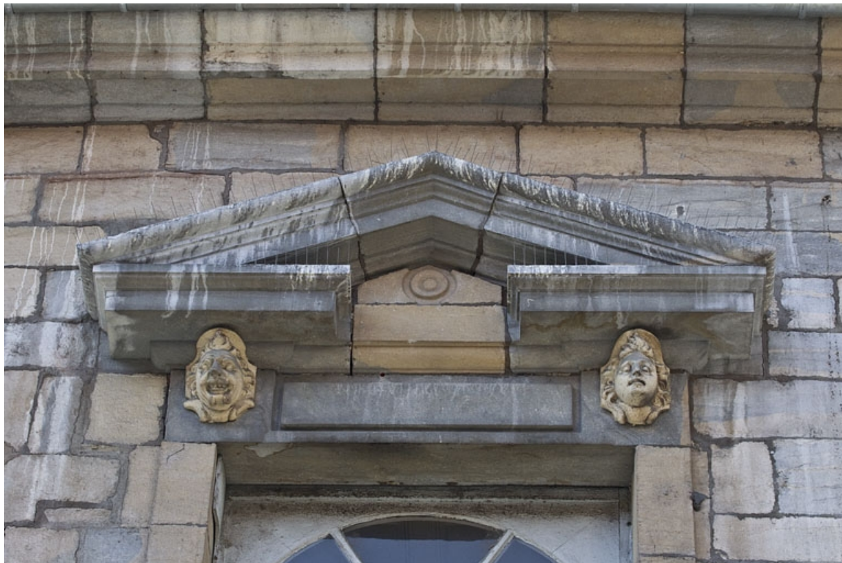
Façade antérieure, partie droite, deuxième fenêtre de l'étage à partir de la droite : détail du fronton triangulaire. 25, Besançon, 2, 4 rue des Granges, lieudit : îlot Bouteiller
