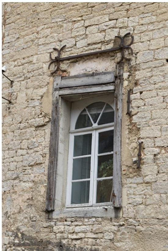
Façade postérieure donnant sur l'impasse : détail d'une ouverture.
