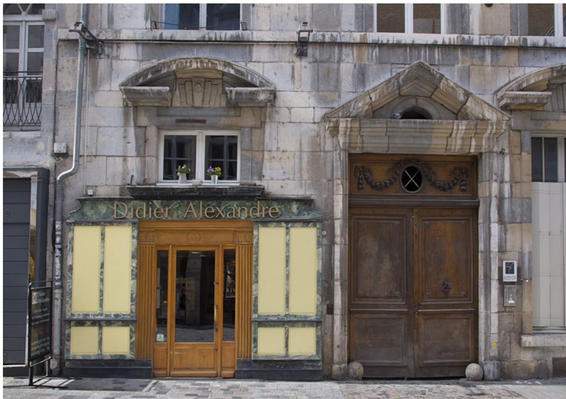
Façade antérieure, partie gauche : détail du portail d'entrée.
