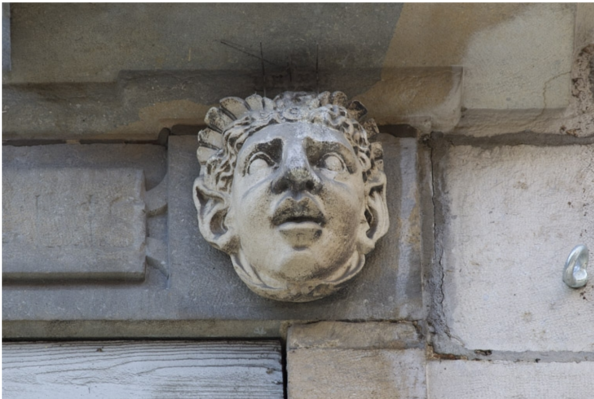
Façade antérieure, partie droite, troisième fenêtre de l'étage à partir de la droite : détail du mascarone droit. 25, Besançon, 2, 4 rue des Granges, lieudit : îlot Bouteiller
