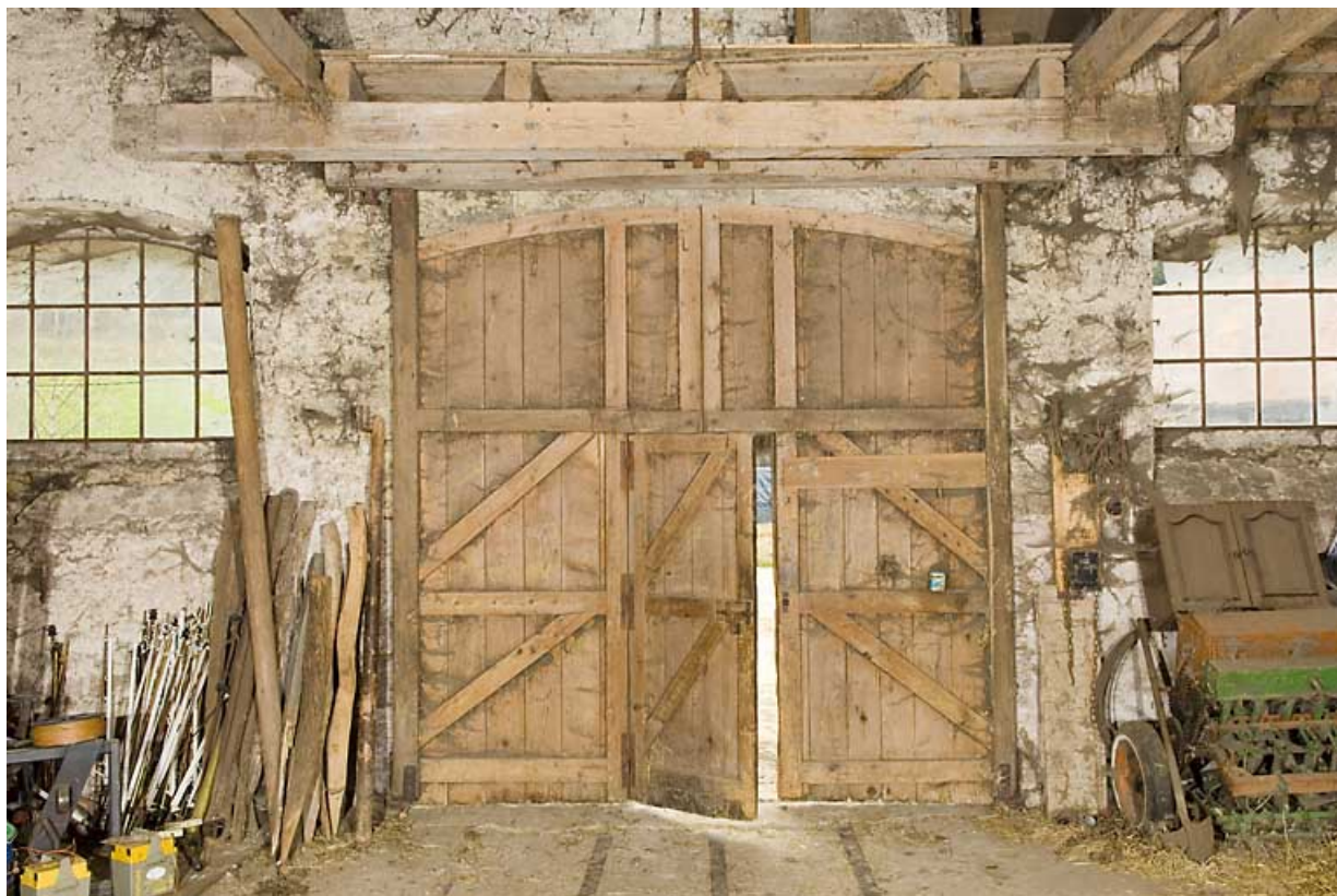
Grange haute : porte vue de l'intérieure.
