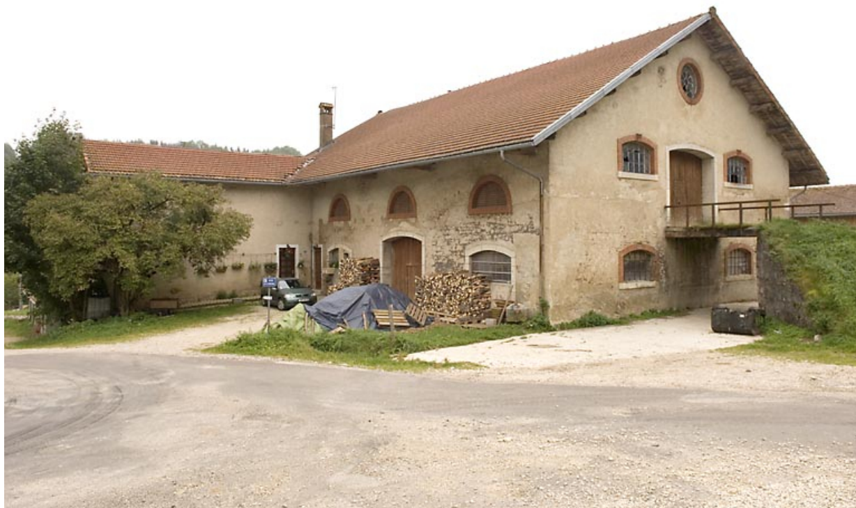
Etables et granges : façades postérieure et latérale droite.
