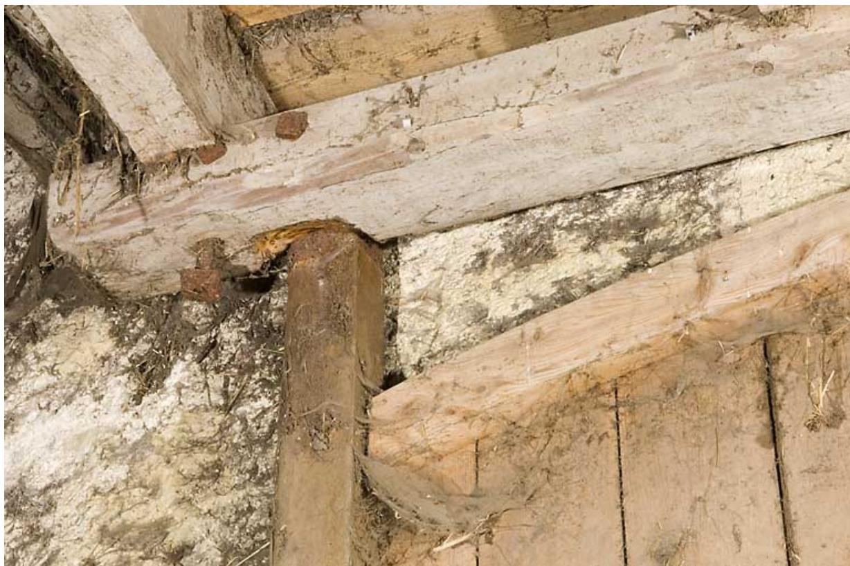
Grange haute : fixation du pivotement haut d'un vantail de la porte.
