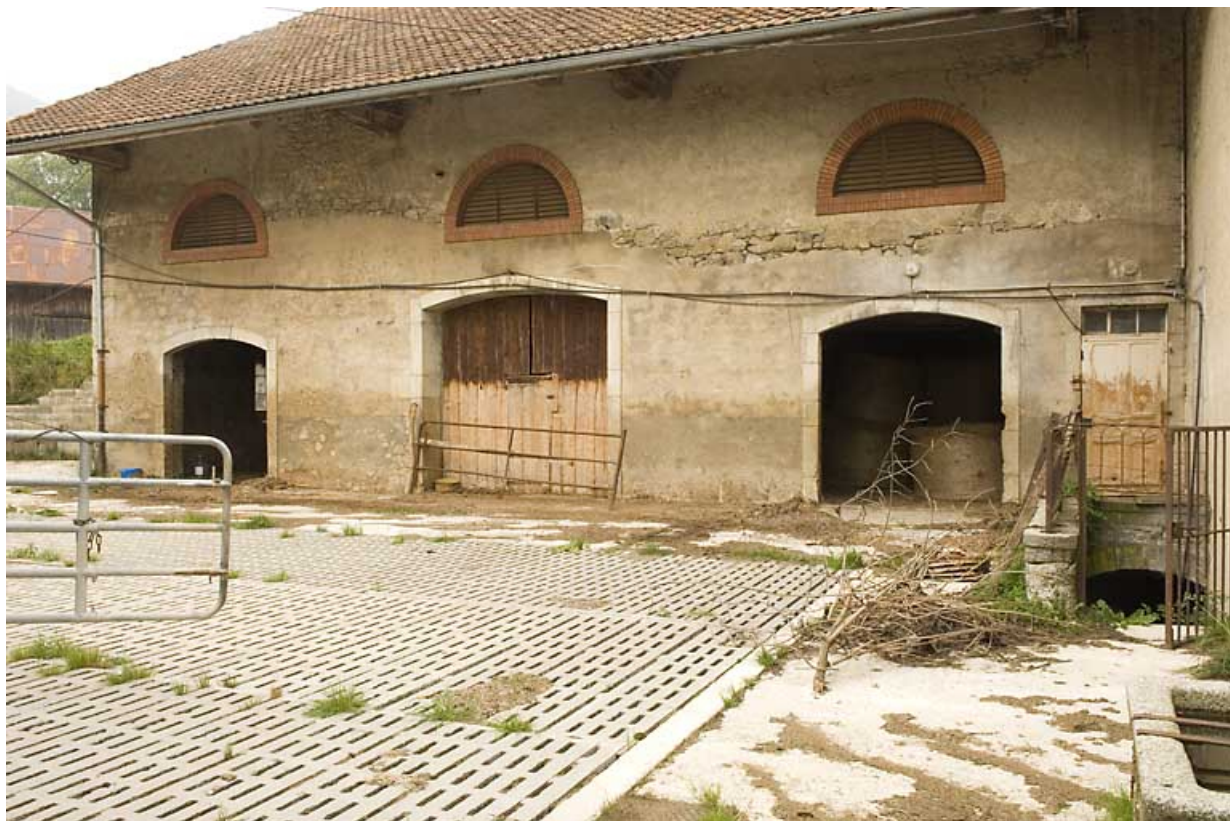
Etables et granges : façade latérale gauche.
