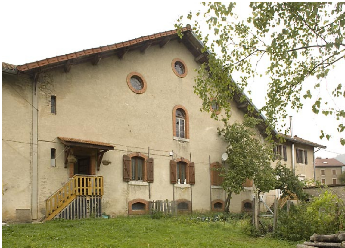
Habitation : partie centrale de la façade antérieure, de trois quarts gauche.
