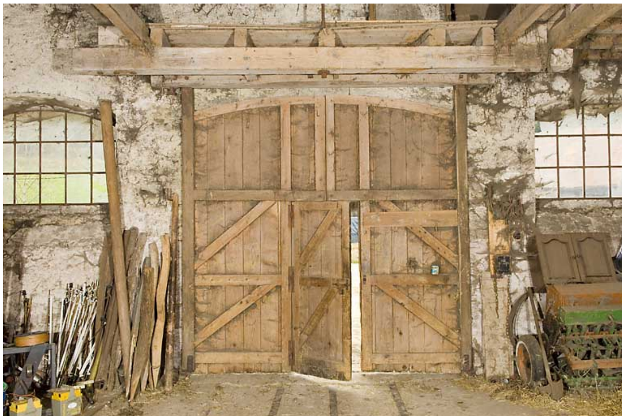
Grange haute : porte vue de l'intérieure.
