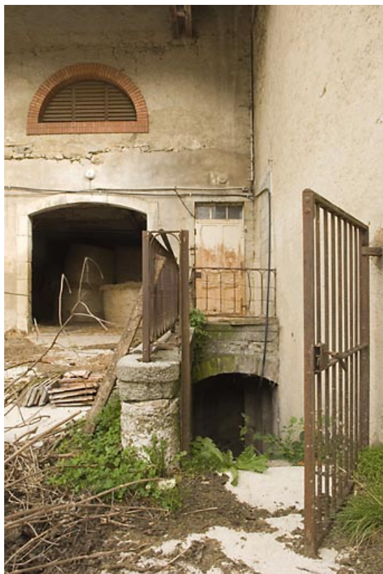
Habitation : façade postérieure, descente de cave.
