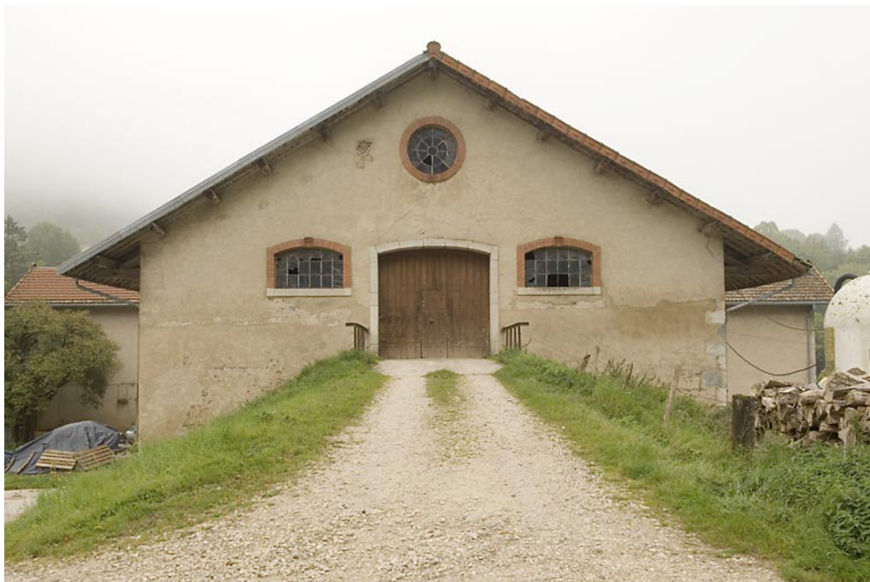
Etables et granges : façade postérieure, avec accès à la grange haute.
