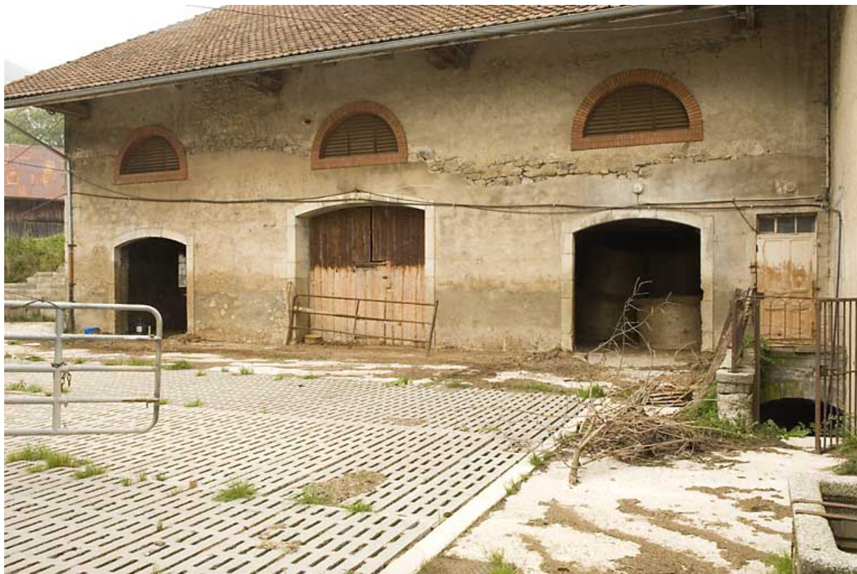
Etables et granges : façade latérale gauche.
