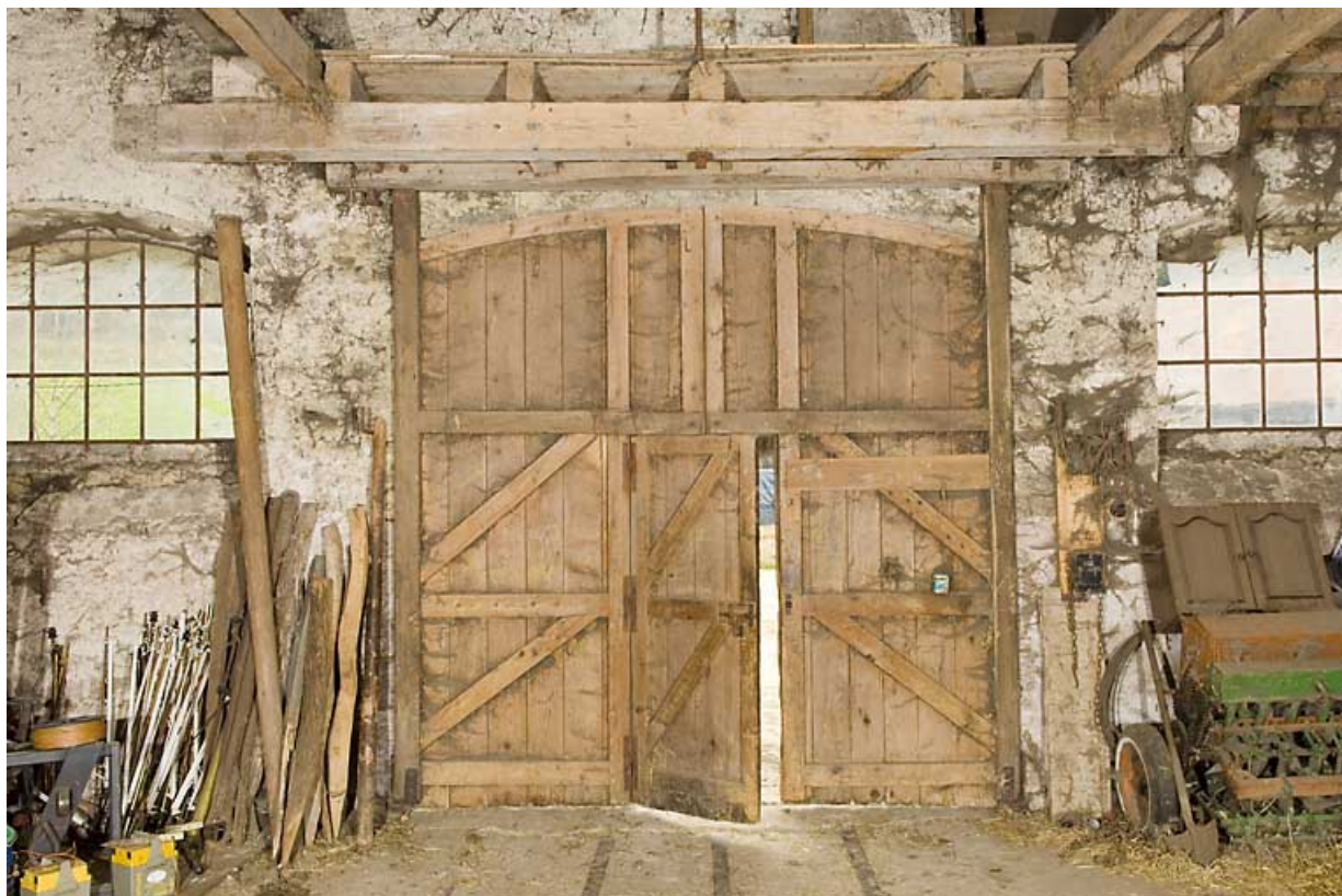
Grange haute : porte vue de l'intérieure.
