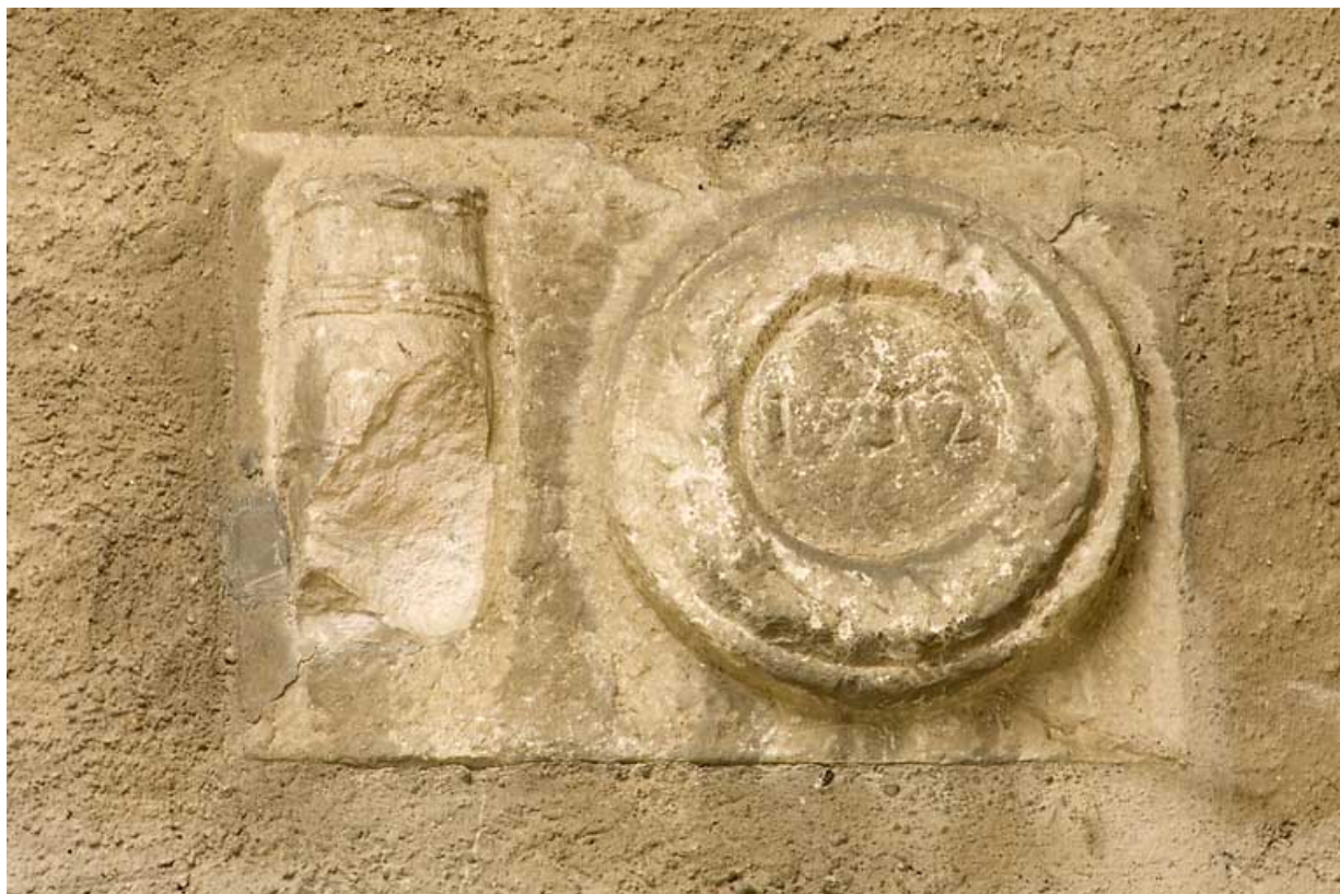
Habitation : façade antérieure, cartouche millésimé 1752.
