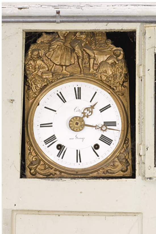
Boiseries de la première chambre : cadran de l'horloge comtoise (porte ouverte). 25, Jougne, 6 rue de Jougne, lieudit : Entre-les-Fourgs
