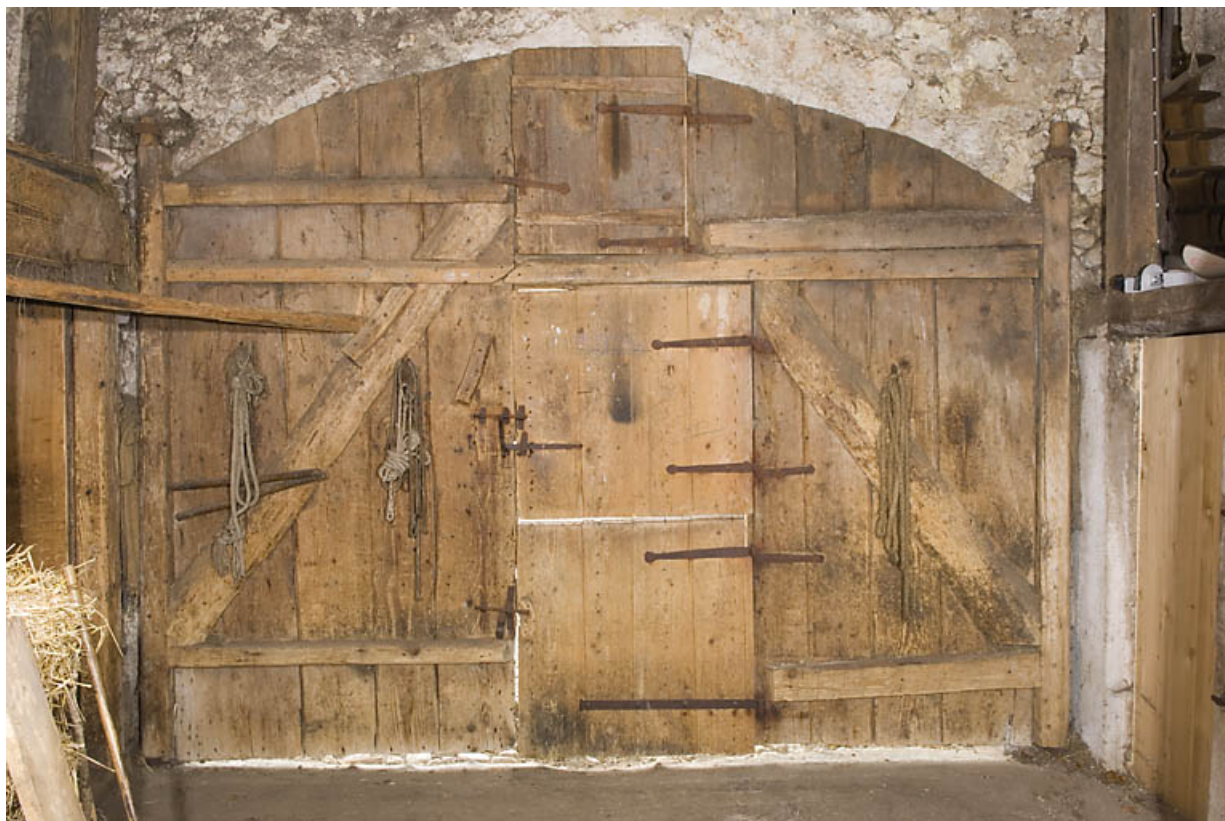
Façade antérieure : porte de la grange, depuis l'intérieur. 25, Jougne, 1 place des Cloutiers, lieudit : Entre-les-Fourgs
