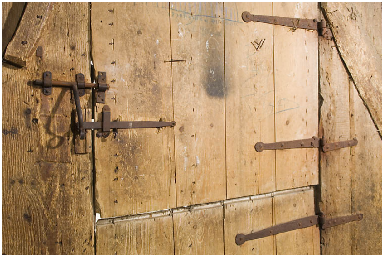
Façade antérieure, porte de grange : fermeture.
