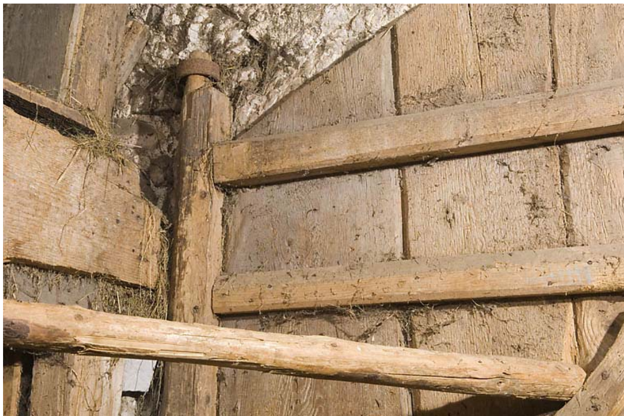
Façade antérieure, porte de grange : fixation de l'axe vertical du vantail de droite (collier en partie haute). 25, Jougne, 1 place des Cloutiers, lieudit : Entre-les-Fourgs
