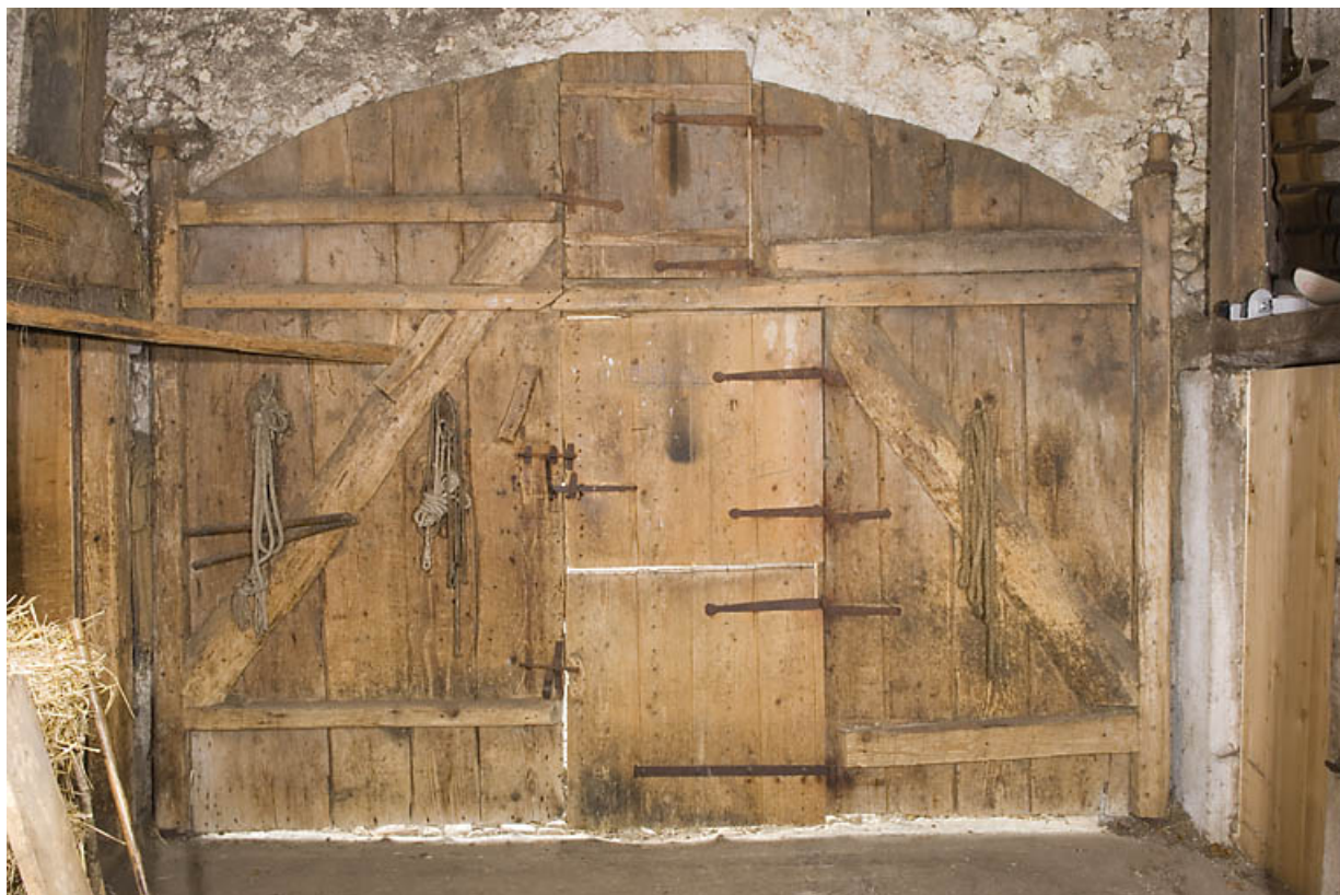
Façade antérieure : porte de la grange, depuis l'intérieur.
