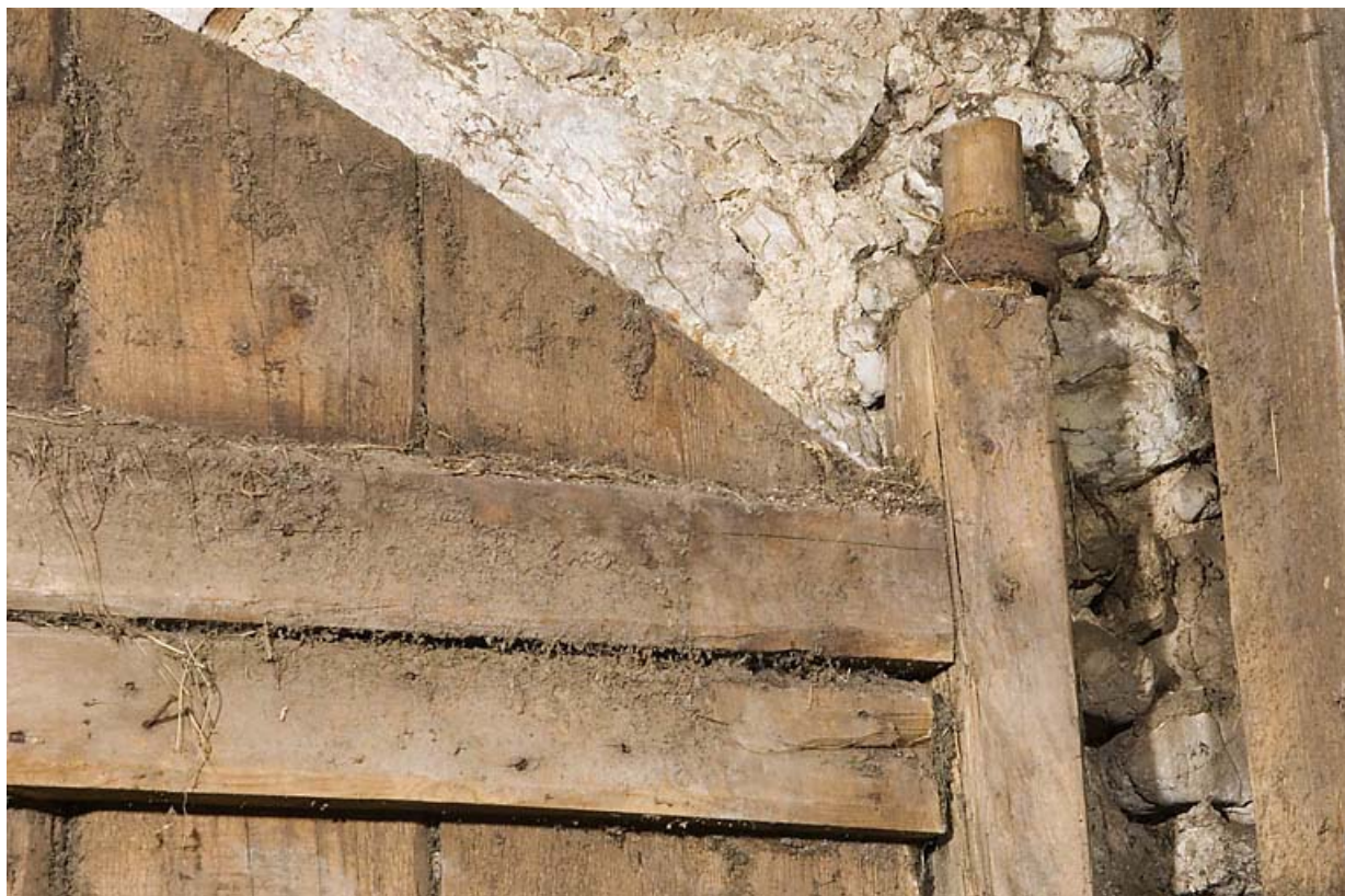
Façade antérieure, porte de grange : fixation de l'axe vertical du vantail de gauche (collier en partie haute). 25, Jougne, 1 place des Cloutiers, lieudit : Entre-les-Fourgs
