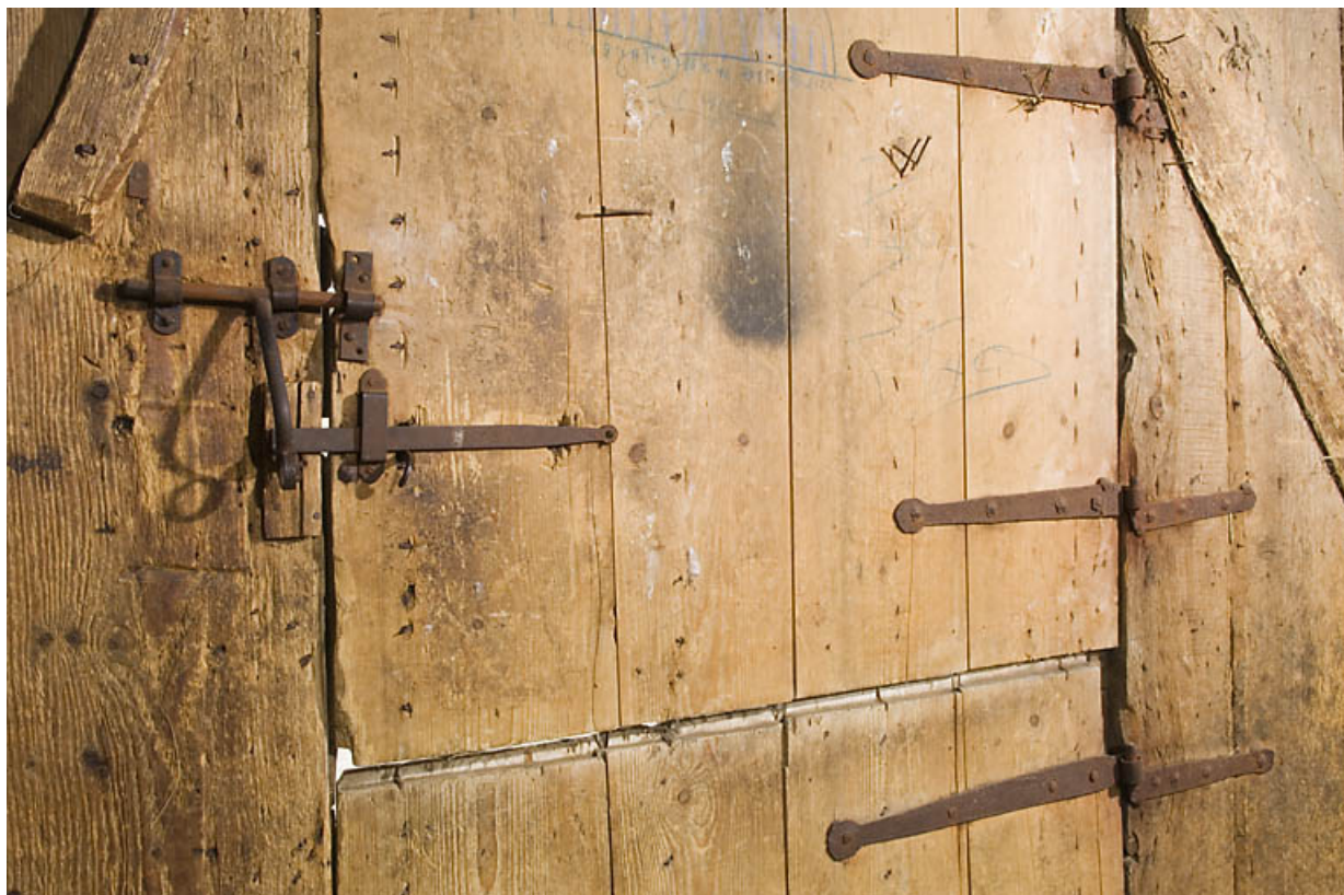
Façade antérieure, porte de grange : fermeture.
