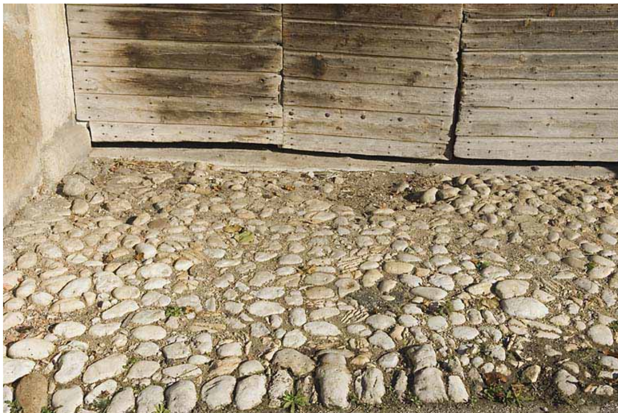
Façade antérieure : pavage devant la grange.
