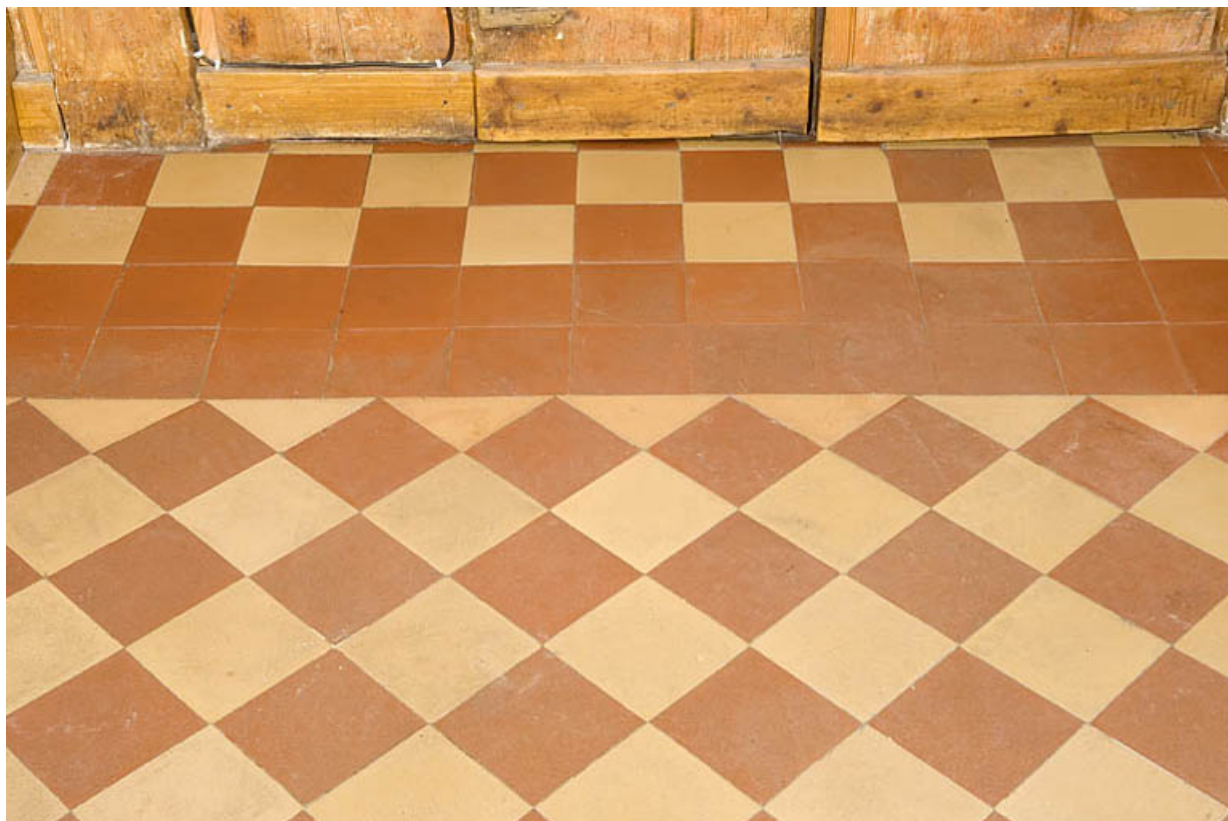
Cuisine du rez-de-chaussée : carreaux au sol.
