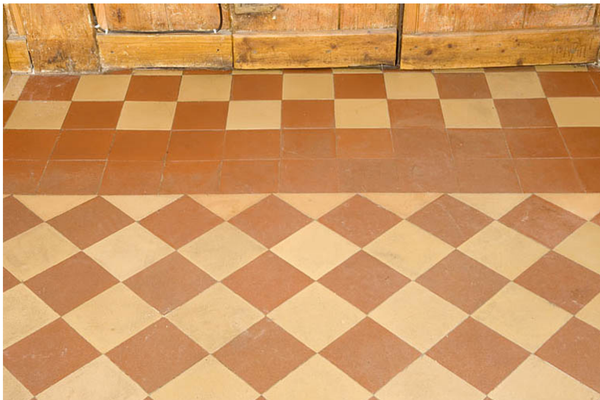
Cuisine du rez-de-chaussée : carreaux au sol.
