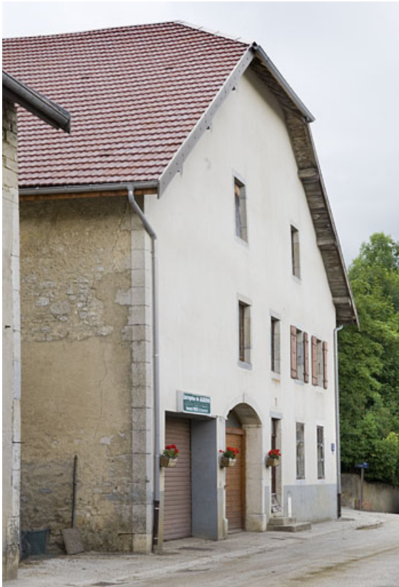
Façade antérieure, vue en enfilade.
