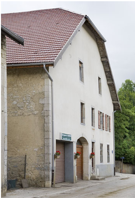
Façade antérieure, vue en enfilade.
