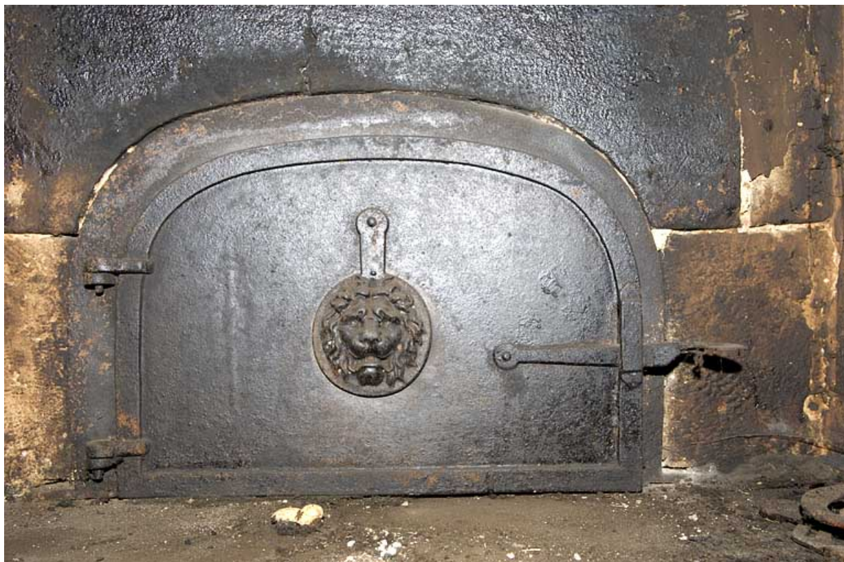
Cuisine au rez-de-chaussée : porte du four à pain. 25, Jougne, 2 rue du Faubourg
