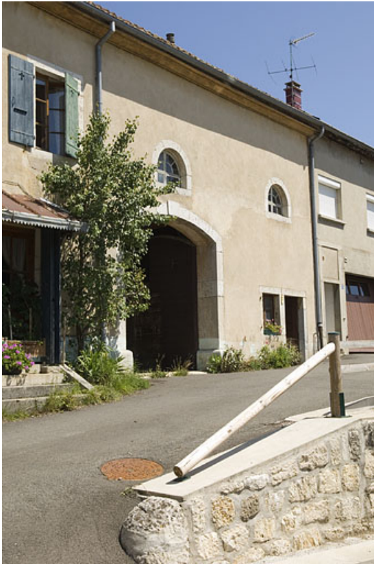
Vue de trois quart rapprochée.
