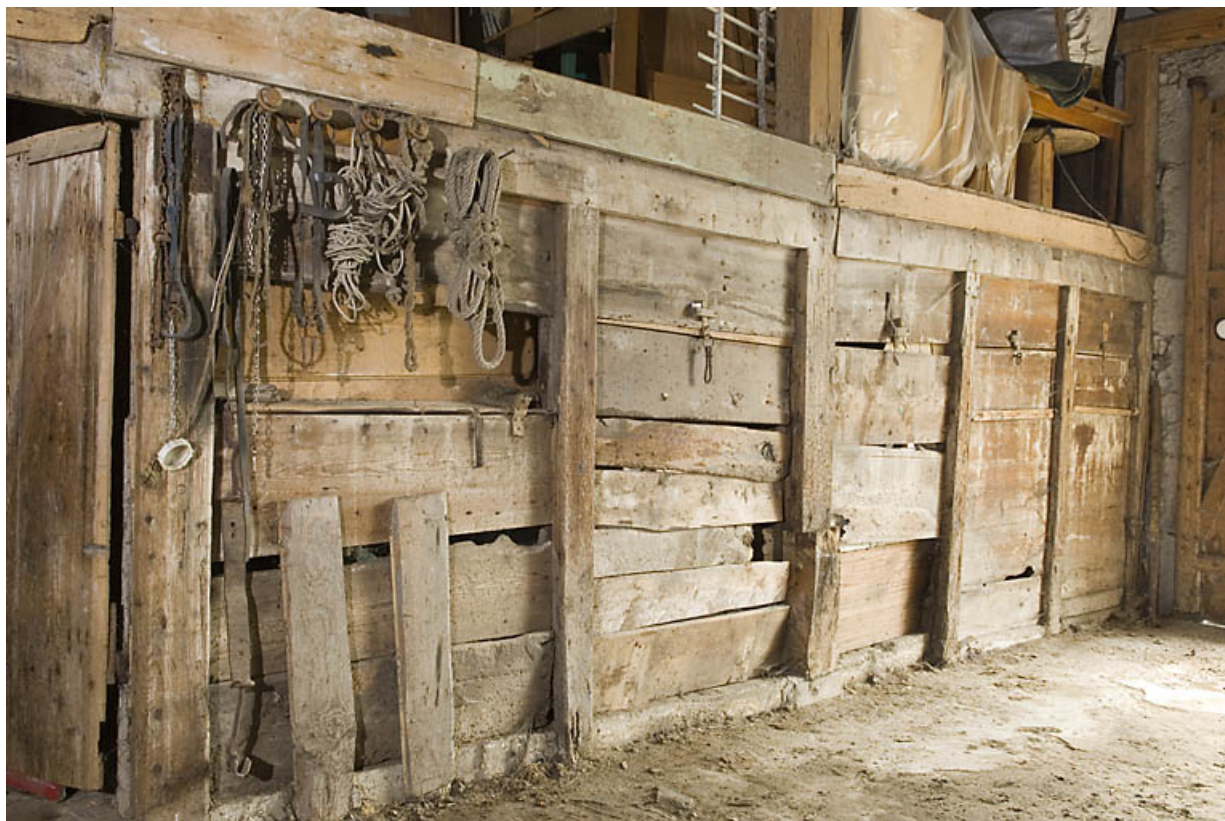
Ferme au 26 Grande Rue : cloison entre la "fourragère" et l'étable. 25, Jougne
