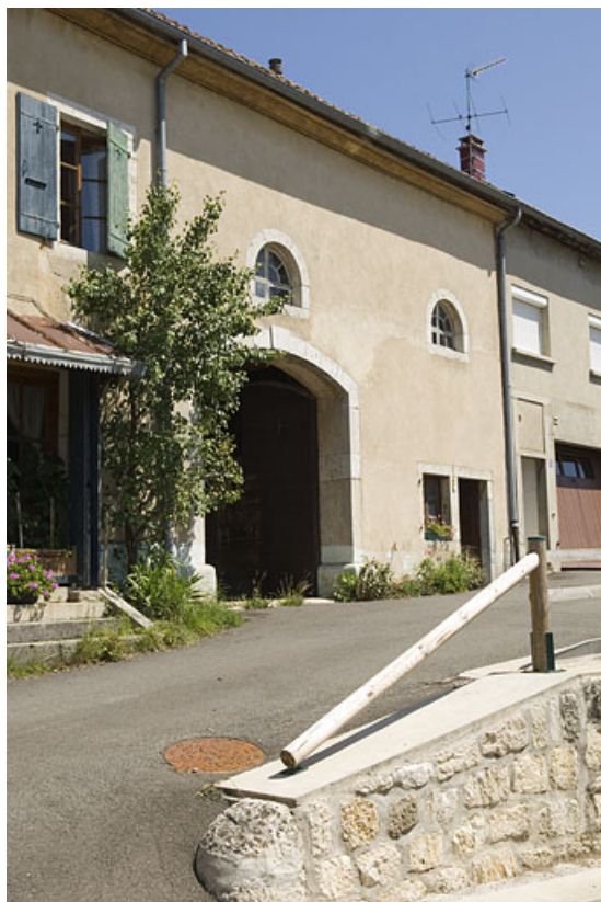
Vue de trois quart rapprochée.
