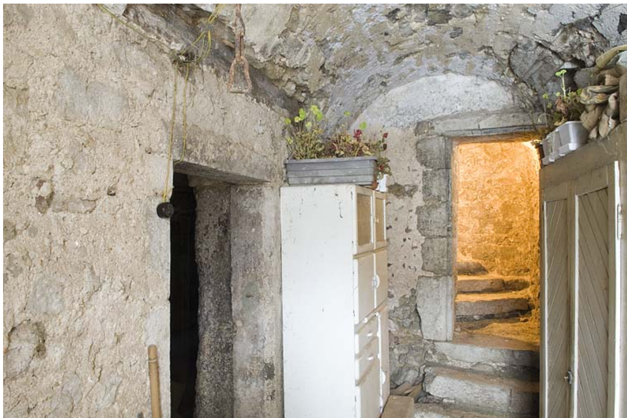
Couloir et départ de l'escalier en pierre.
