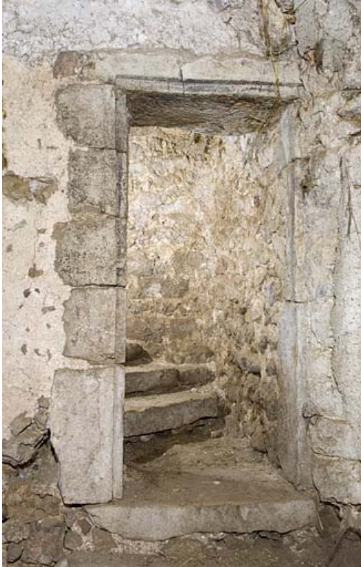
Porte donnant accès à l'escalier en pierre.
