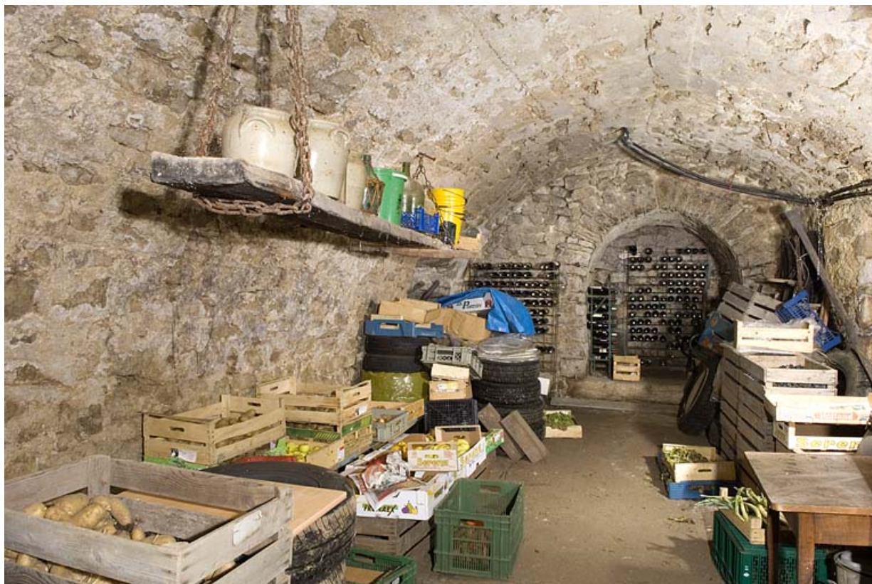
Sous-sol ("cave") voûté en berceau.
