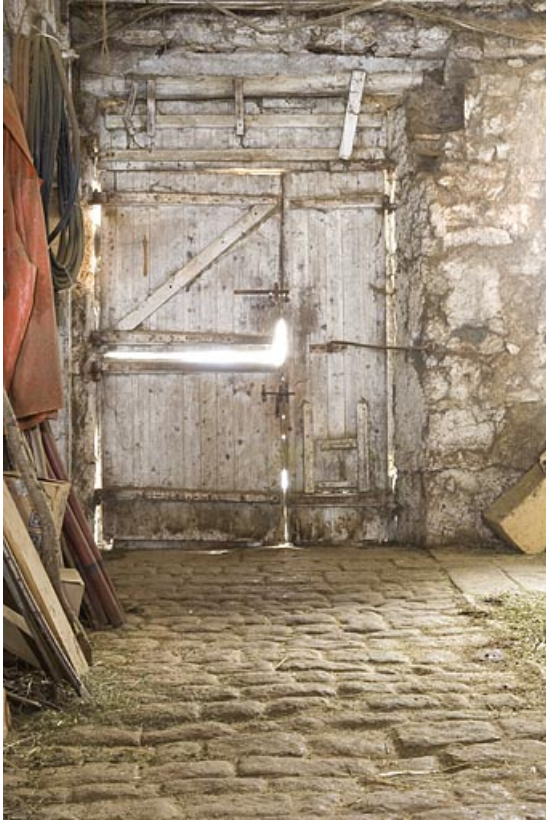
Etable : la porte vue de l'intérieur.
