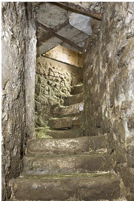
Escalier en pierre (cadrage vertical).
