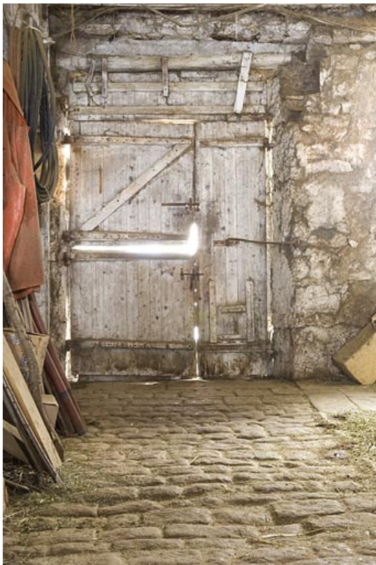
Etable : la porte vue de l'intérieur.
