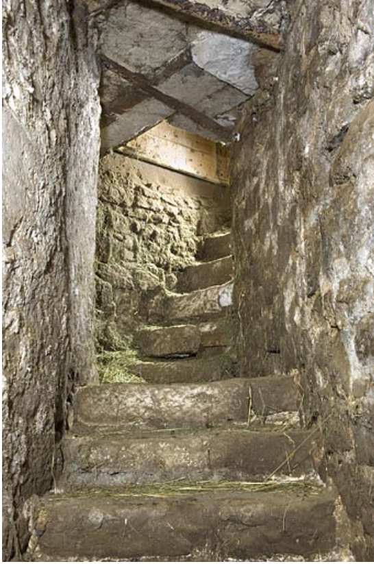
Escalier en pierre (cadrage vertical).
