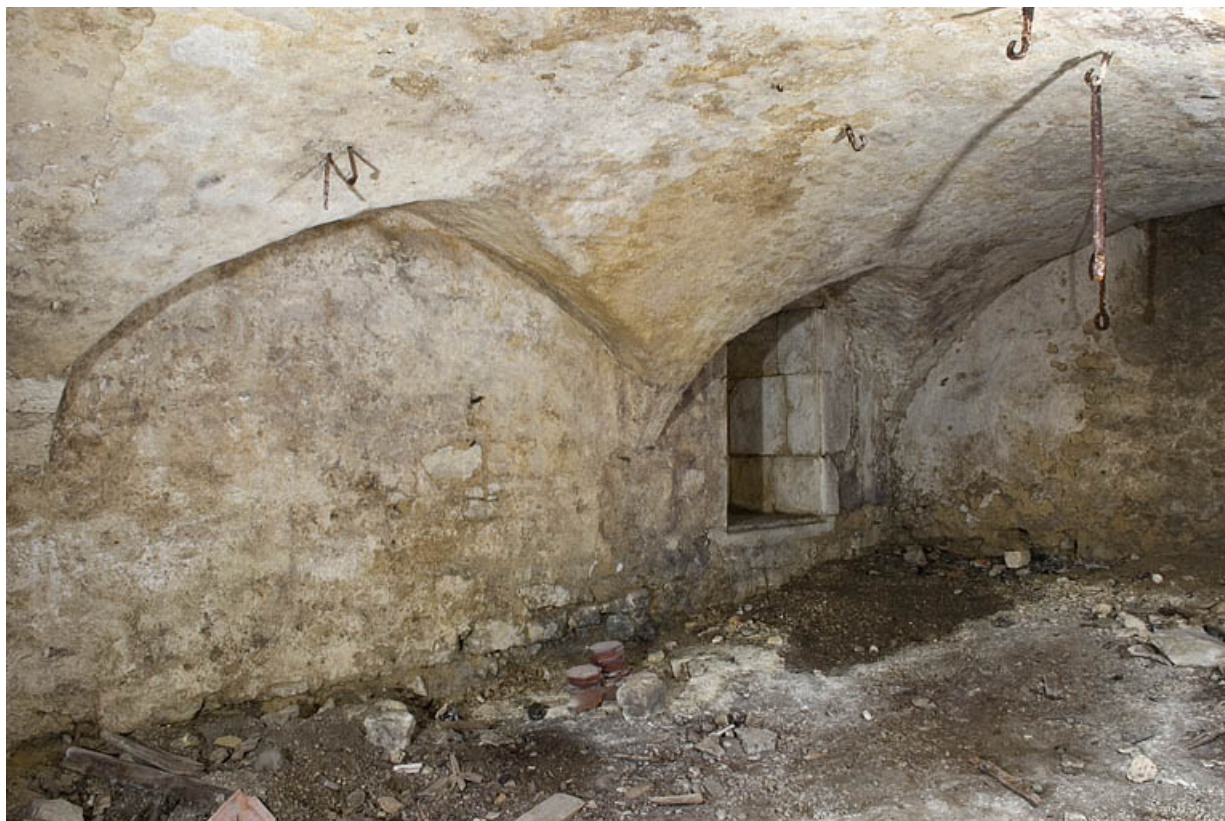
Sous-sol, vue de trois quart gauche.
