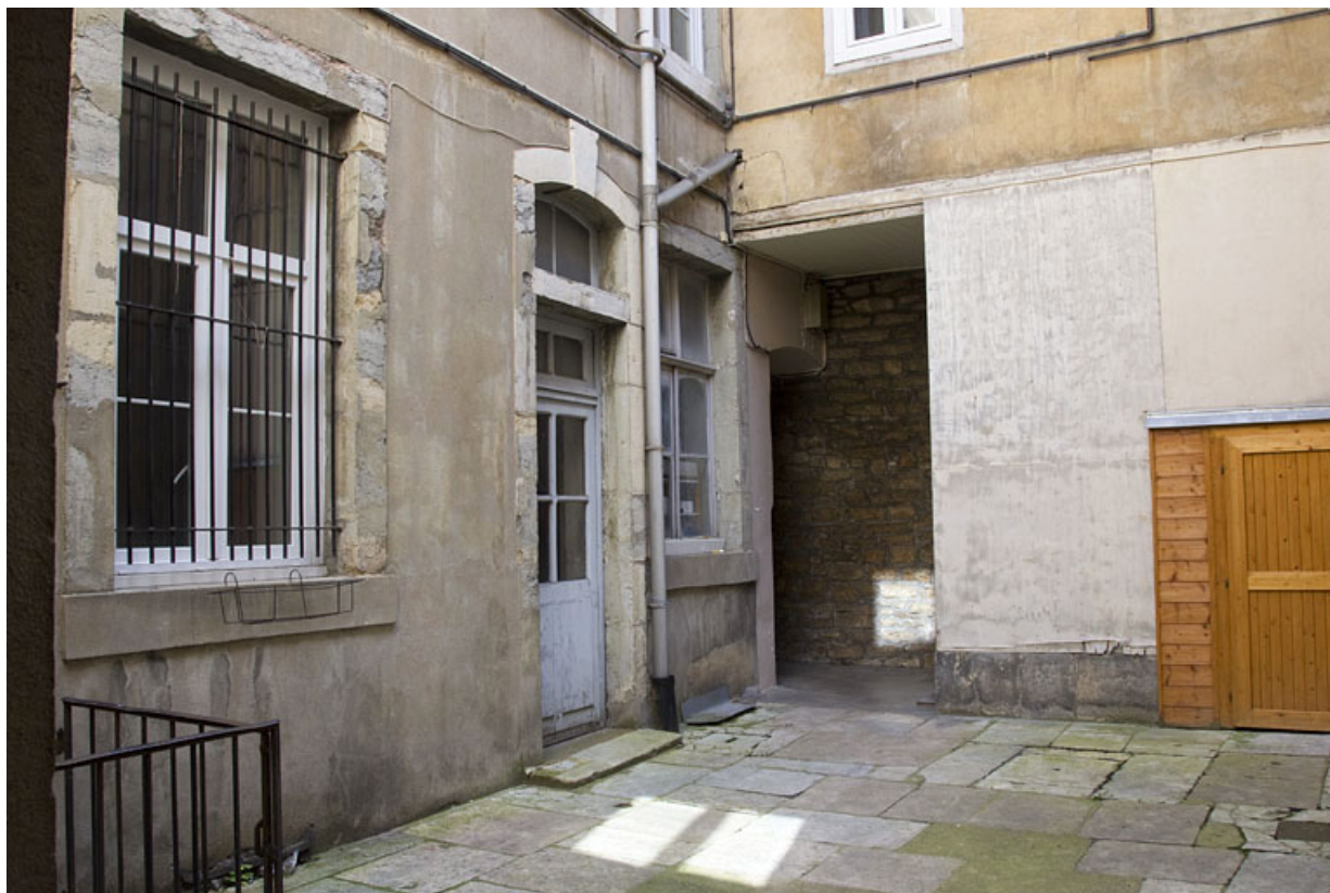
Vue du rez-de-chaussée des logis secondaires depuis le fond de la deuxième cour.
