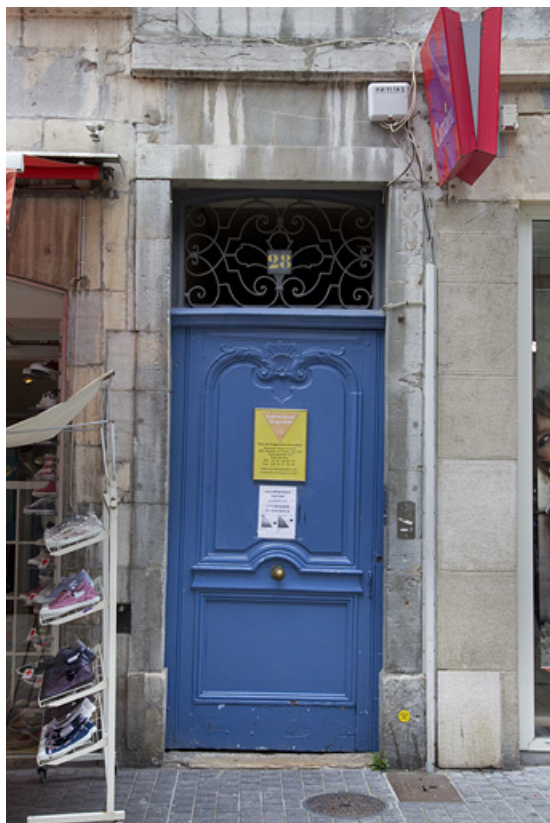
Façade antérieure de logis principal : détail de la porte du couloir.
