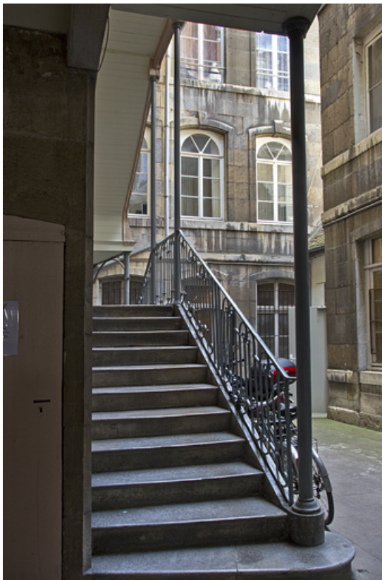
Vue du premier logis secondaire depuis le départ de l'escalier à cage ouverte. 25, Besançon Grande Rue 28, lieudit : îlot Sainte-Ursule
