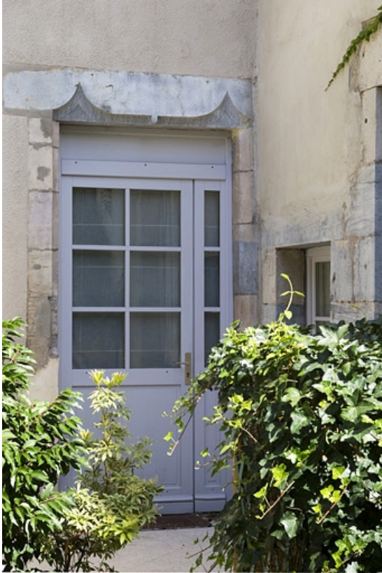
Logis principal, aile gauche sur cour : détail d'une porte du rez-de-chaussée. 25, Besançon, 11 rue Pasteur, lieudit : îlot Sainte-Ursule
