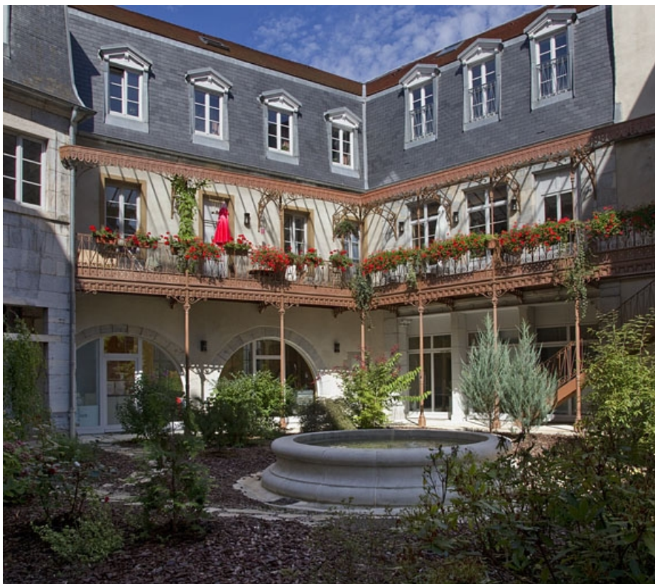
Logis principal : vue des façades depuis le fond de la cour.
