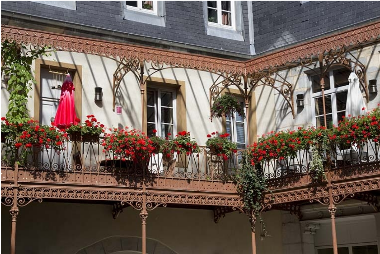
Logis principal, premier étage sur cour : détail du auvent métallique.
