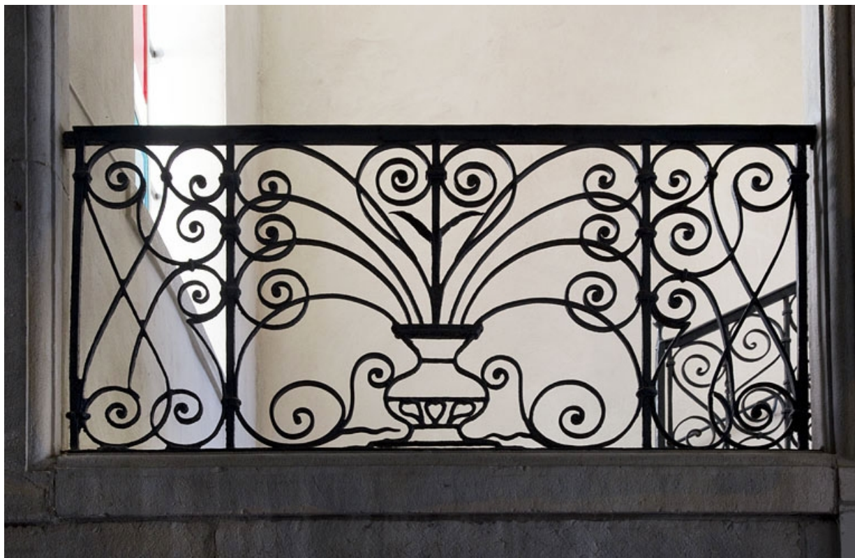
Logis principal, intérieur, escalier : détail d'un garde corps en ferronnerie. 25, Besançon, 11 rue Pasteur, lieudit : îlot Sainte-Ursule
