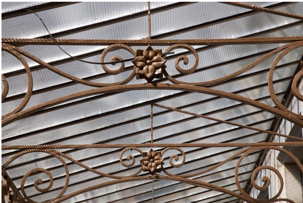
Logis principal : détail de la structure métallique du auvent.
