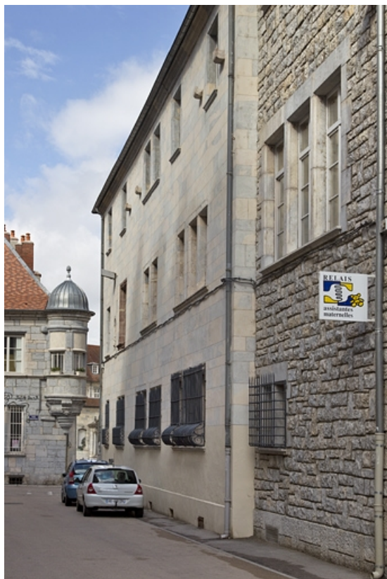
Logis principal, aile droite, façade postérieure depuis la rue d'Anvers : de trois quarts droit. 25, Besançon, 11 rue Pasteur, lieudit : îlot Sainte-Ursule
