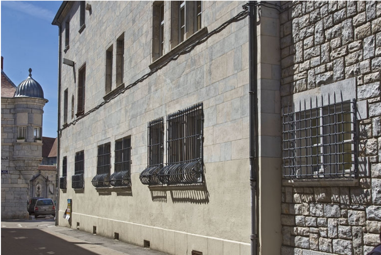
Logis principal, aile droite, façade postérieure : de trois quarts droit. 25, Besançon, 11 rue Pasteur, lieudit : îlot Sainte-Ursule
