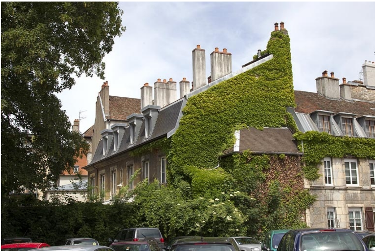
Vue du logis principal depuis la parcelle voisine, de trois quarts droit.
