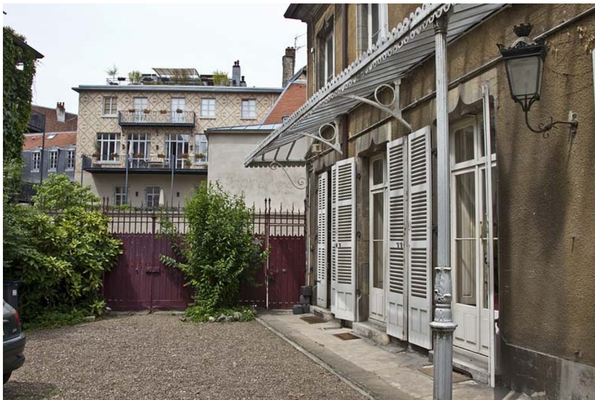
Vue de la cour depuis le fond de la parcelle : de trois quart gauche.
