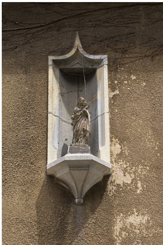
Logis principal, façade antérieure : détail de la niche. 25, Besançon, 7 rue d' Anvers, lieudit : îlot d' Emskerque
