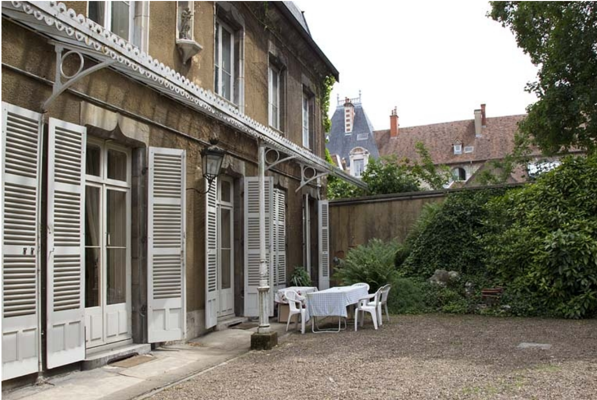
Logis principal, façade antérieure : de trois quart droit. 25, Besançon, 7 rue d' Anvers, lieudit : îlot d' Emskerque
