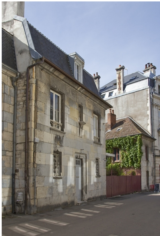
Vue d'ensemble depuis la rue, de trois quarts gauche. 25, Besançon, 7 rue d' Anvers, lieudit : îlot d' Emskerque
