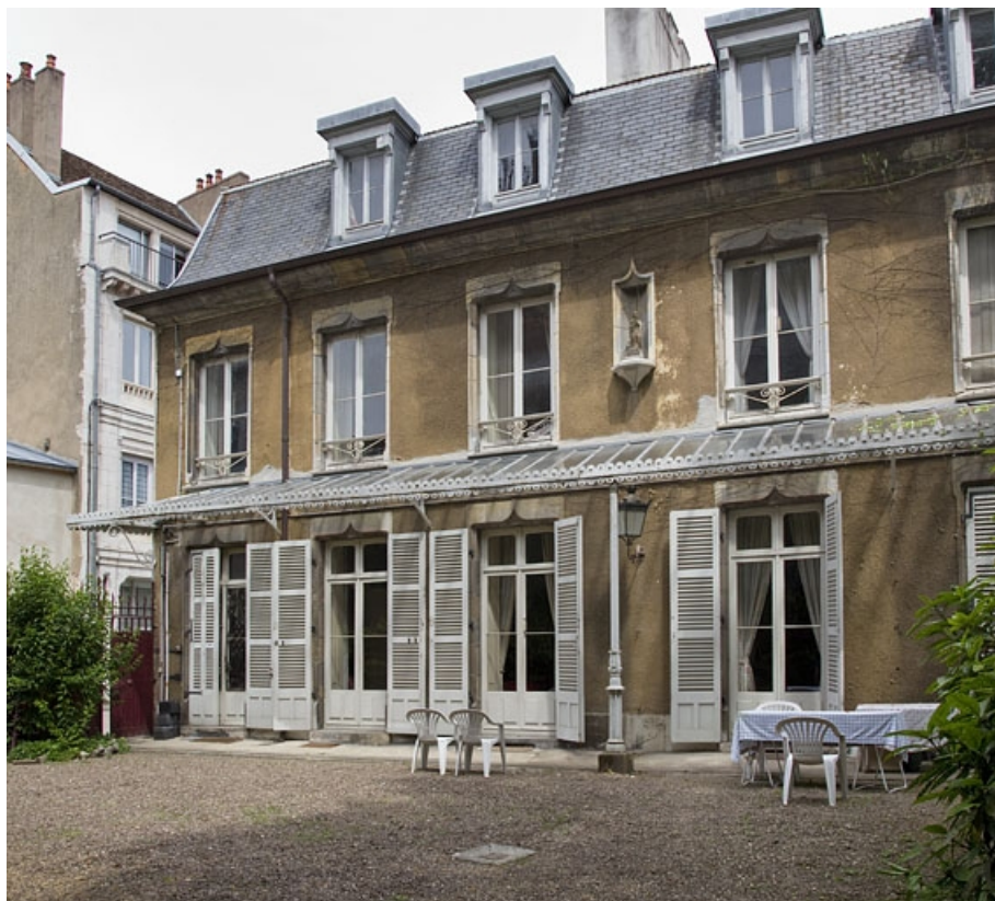
Vue d'ensemble de la façade antérieure, de trois quarts droit.
