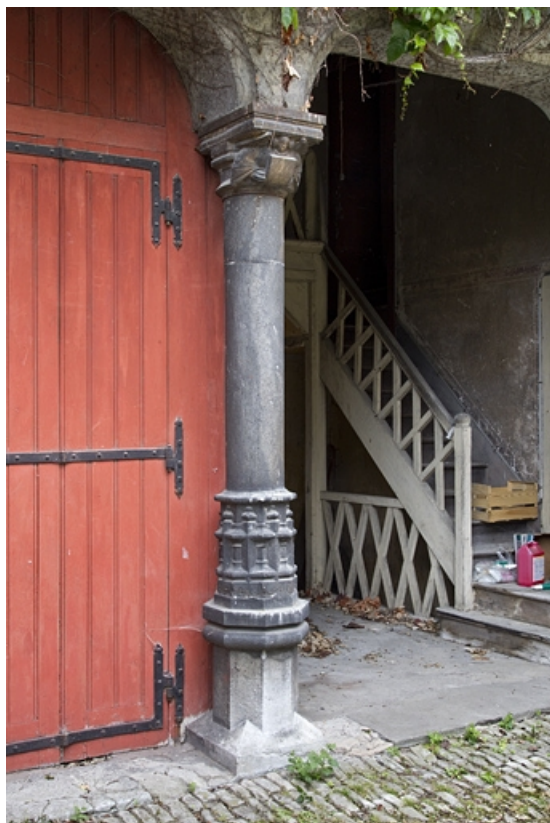
Bâtiment des remises : détail de la colonne et de son chapiteau.
