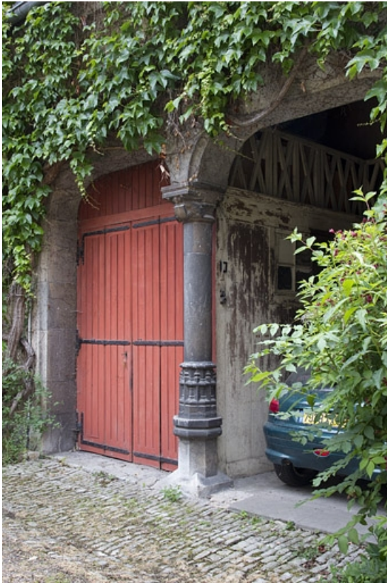
Bâtiment des remises : détail des portes des remises.
