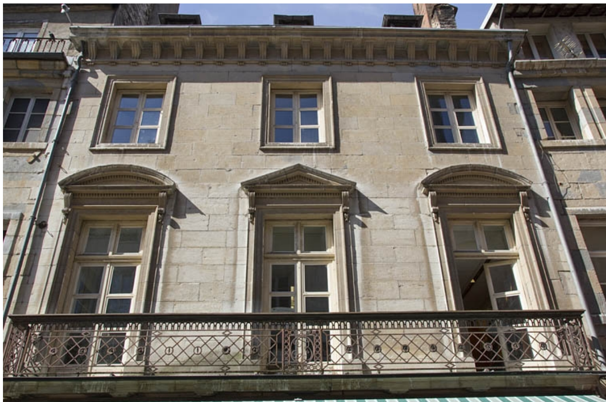
Logis principal, façade sur rue : détail des premier et deuxième étages, de face.
