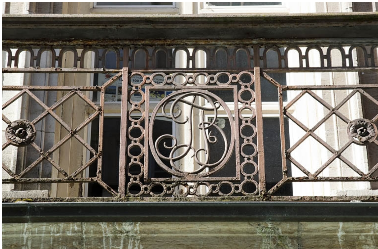
Logis principal, façade sur rue : détail du monogramme du balcon en ferronnerie.
