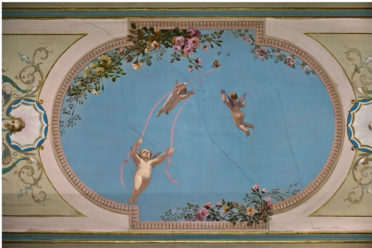
Logis principal, appartement du premier étage, grande pièce sur rue : détail du décor de la partie centrale du plafond. 25, Besançon Grande Rue 48, lieudit : îlot d' Emskerque
