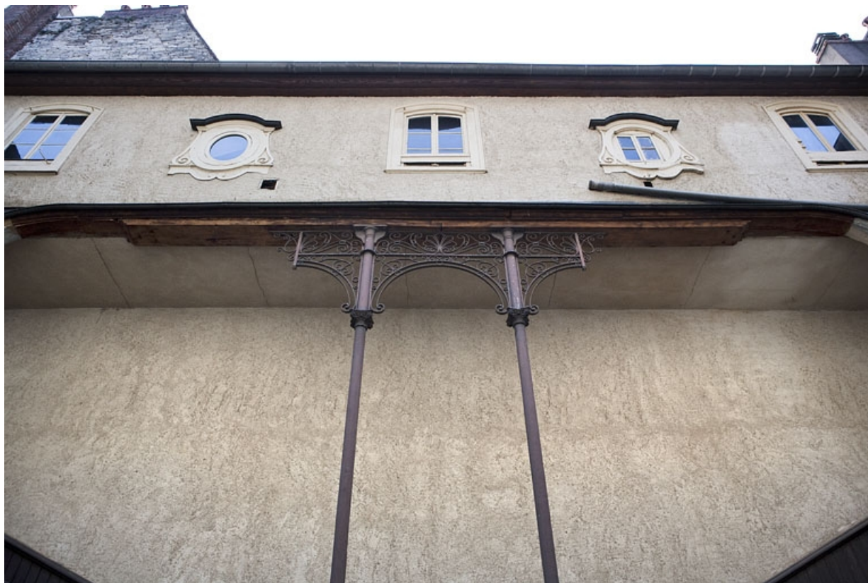
Escalier à cage ouverte sur cour : détail de la galerie fermée au-dessus de l'escalier, de face. 25, Besançon Grande Rue 48, lieudit : îlot d' Emskerque
