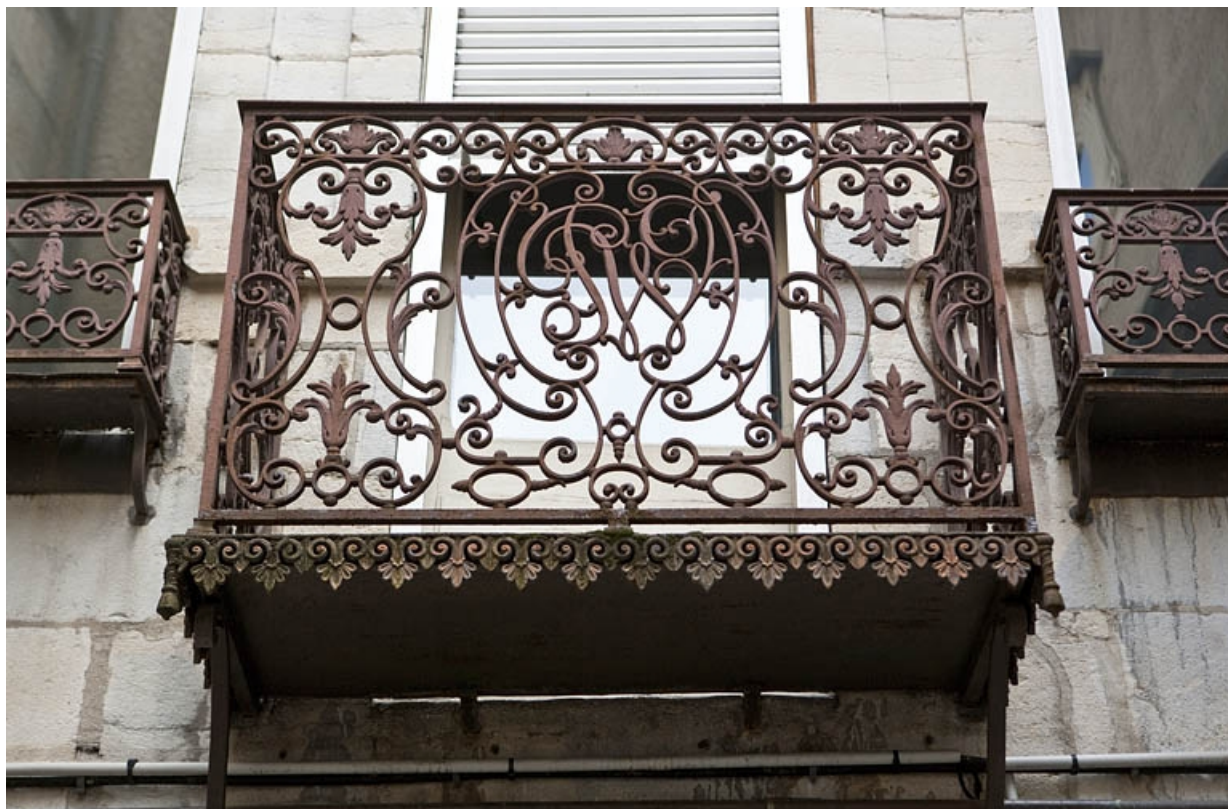
Logis principal, façade postérieure : détail du balcon en ferronnerie, de face. 25, Besançon Grande Rue 48, lieu-dit : îlot d' Emskerque
