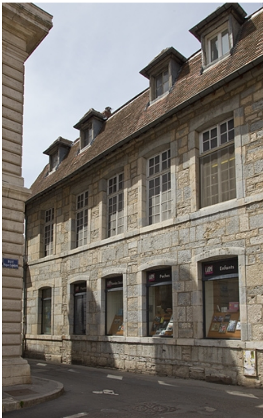
Logis principal, façade latérale gauche sur rue : vue d'ensemble de trois quarts droit. 25, Besançon Grande Rue 48, lieudit : îlot d' Emskerque
