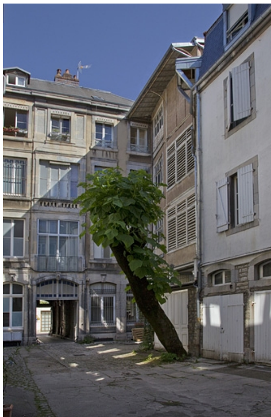
Logis principal, façade postérieure depuis le fond de la cour.
