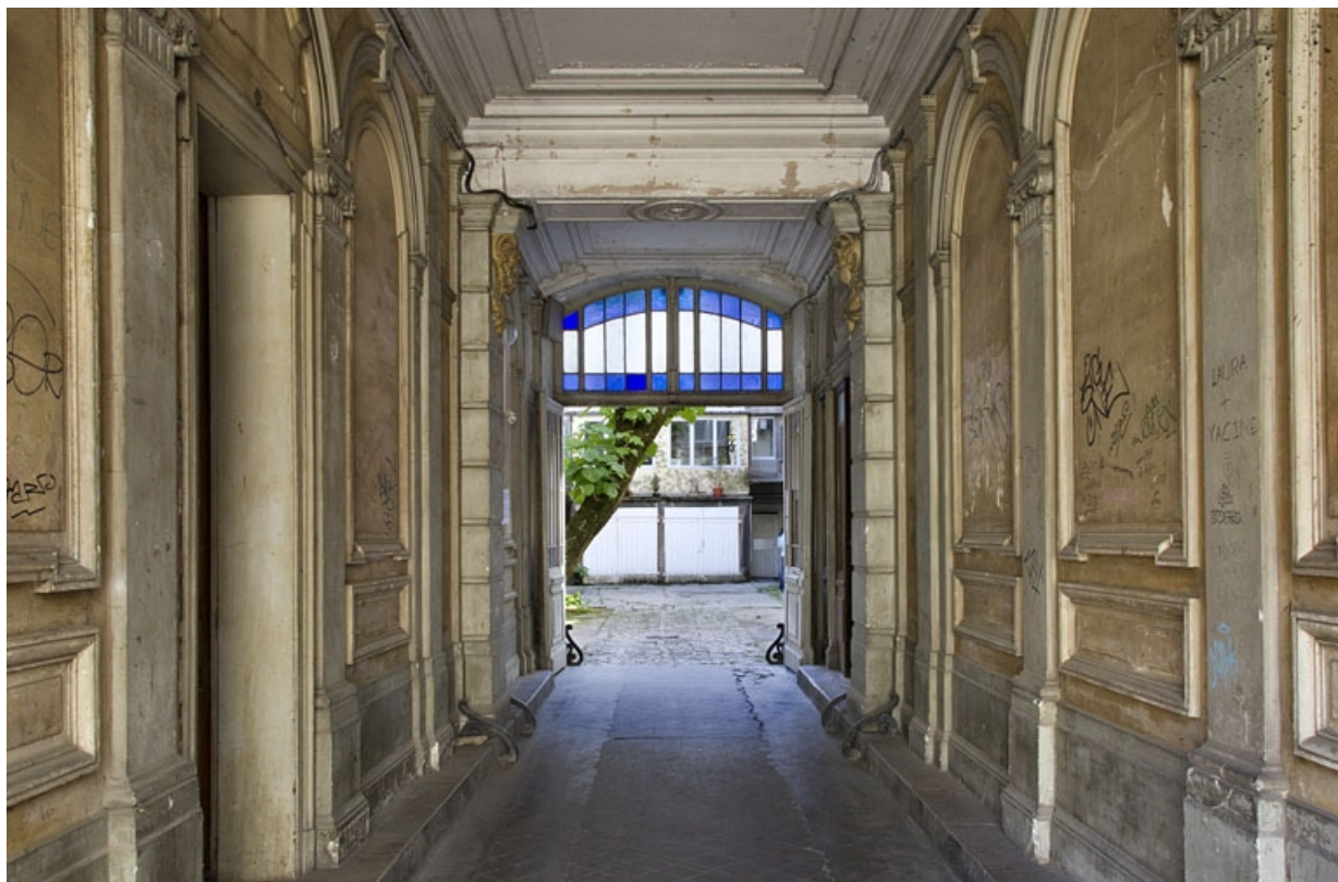
Logis principal, passage cocher : vue en direction de la cour.
