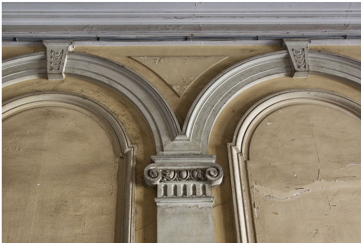
Logis principal, passage cocher : détail du décor.
