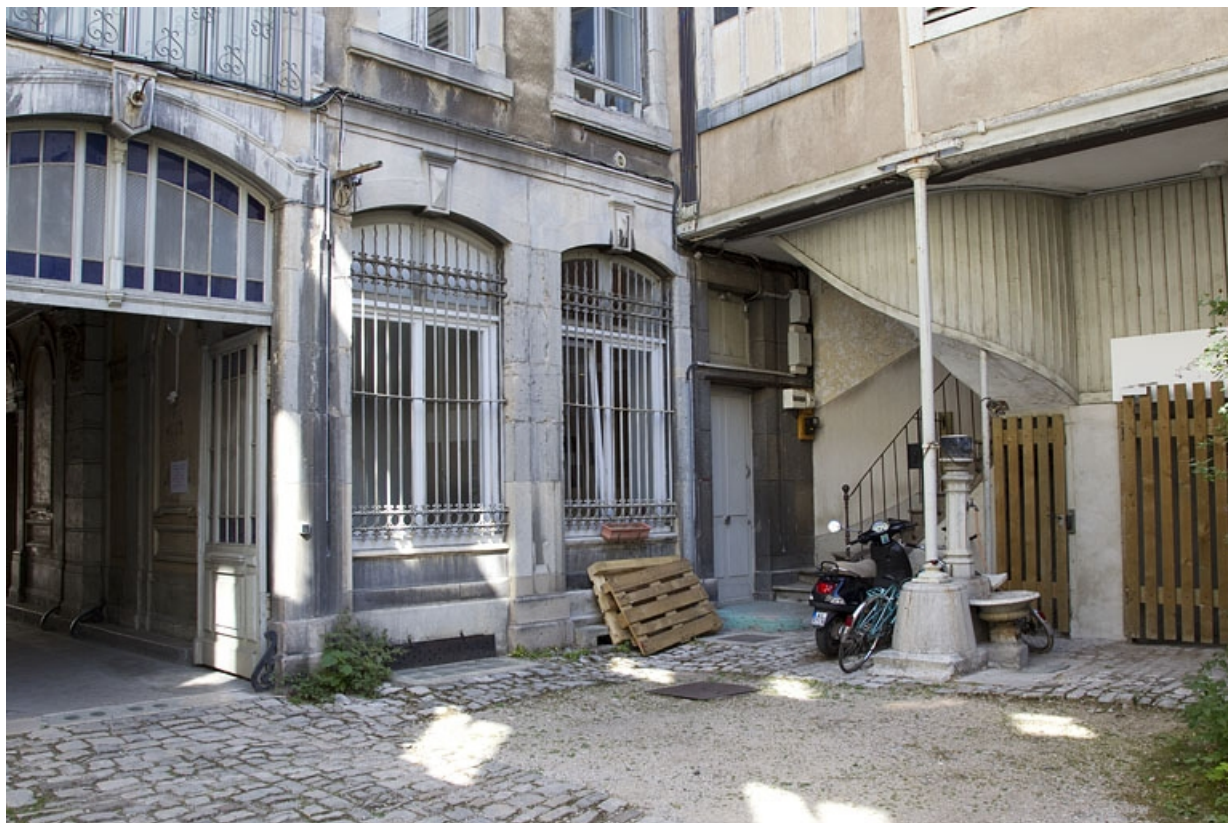
Logis principal, façade postérieure : fenêtres du rez-de-chaussée, à gauche du portail. 25, Besançon, 9 rue d' Anvers, lieu-dit : îlot d' Emskerque
