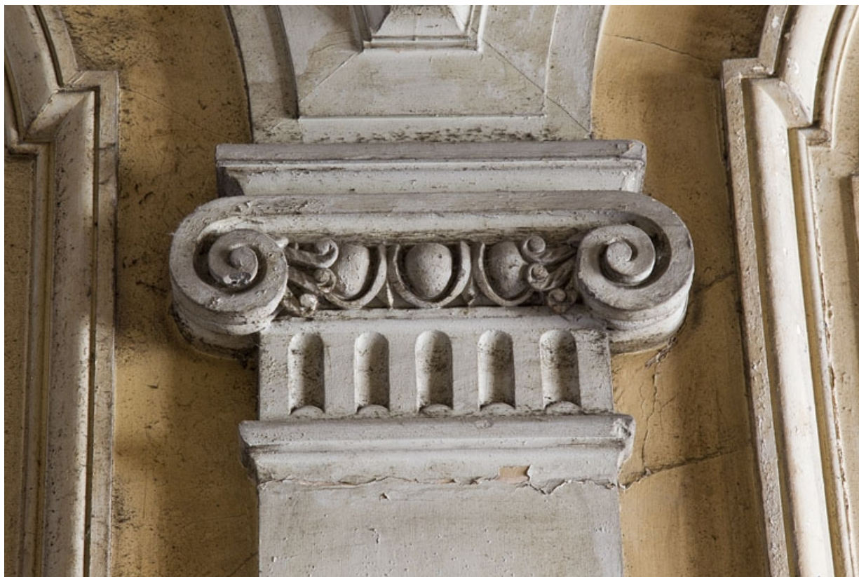
Logis principal, passage cocher : détail du décor, chapiteau ionique.
