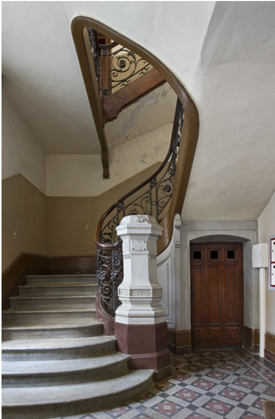
Logis principal, escalier dans oeuvre : vue d'ensemble.
