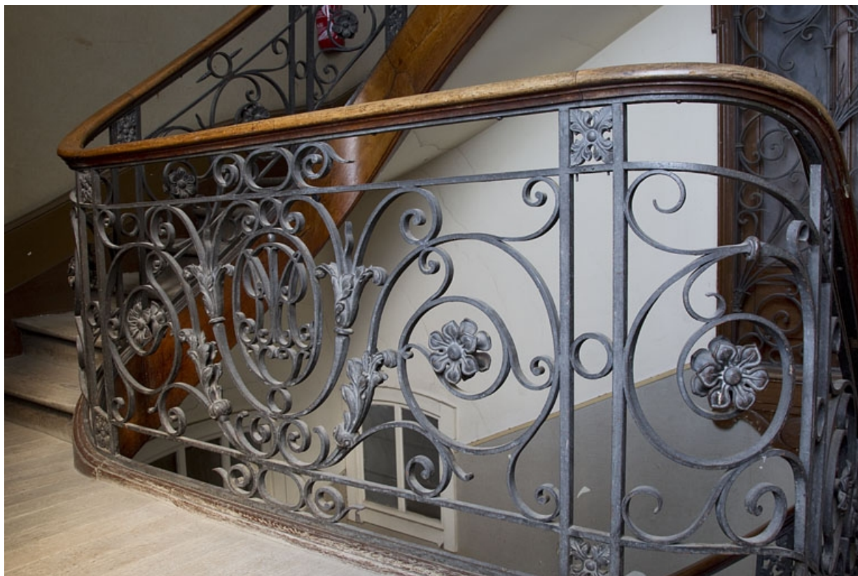
Logis principal, escalier dans oeuvre : détail de la rampe en ferronnerie.
