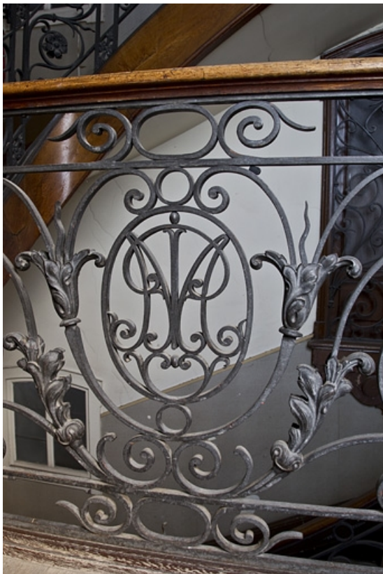
Logis principal, escalier dans oeuvre : détail du monogramme sur la rampe en ferronnerie. 25, Besançon, 9 rue d' Anvers, lieudit : îlot d' Emskerque
