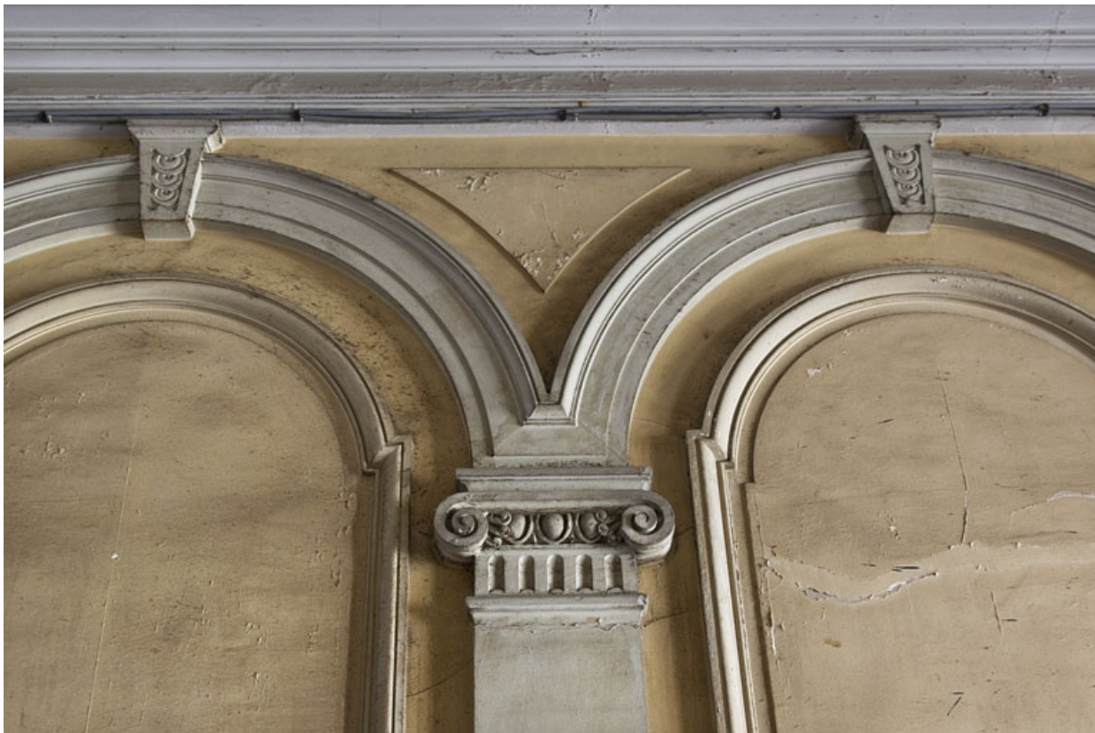
Logis principal, passage cocher : détail du décor.
