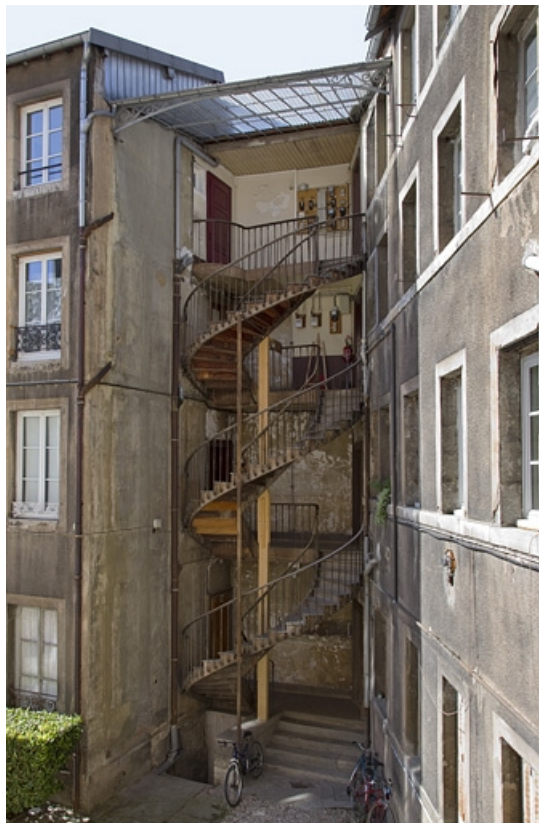
Vue d'ensemble de l'escalier à cage ouverte entre le logis secondaire droit et le logis principal. 25, Besançon, 15 rue Pasteur, lieudit : îlot d' Emskerque
