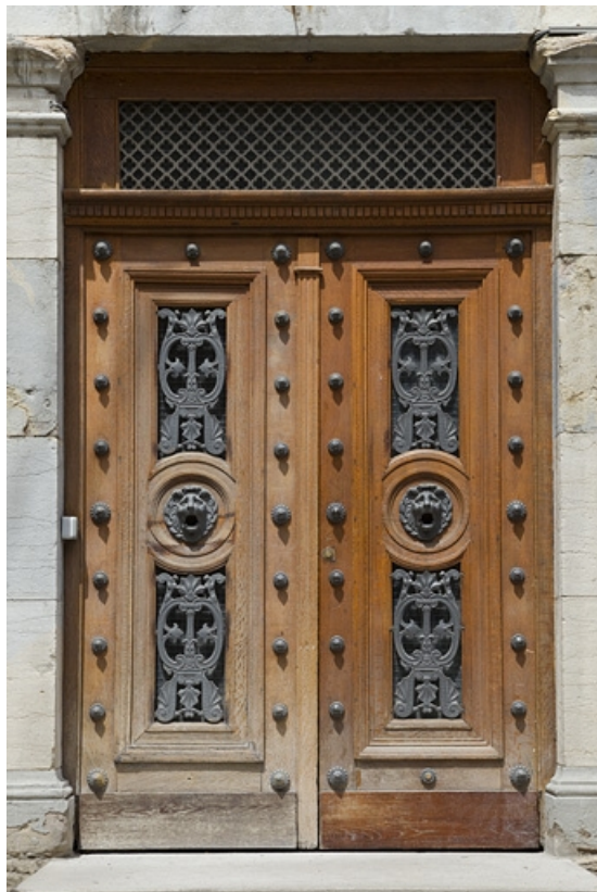
Logis secondaire gauche : vue rapprochée de la porte d'entrée.
