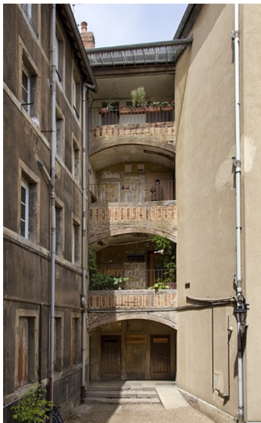
Vue d'ensemble des galeries superposées entre le logis secondaire gauche et le logis principal. 25, Besançon, 15 rue Pasteur, lieudit : îlot d' Emskerque
