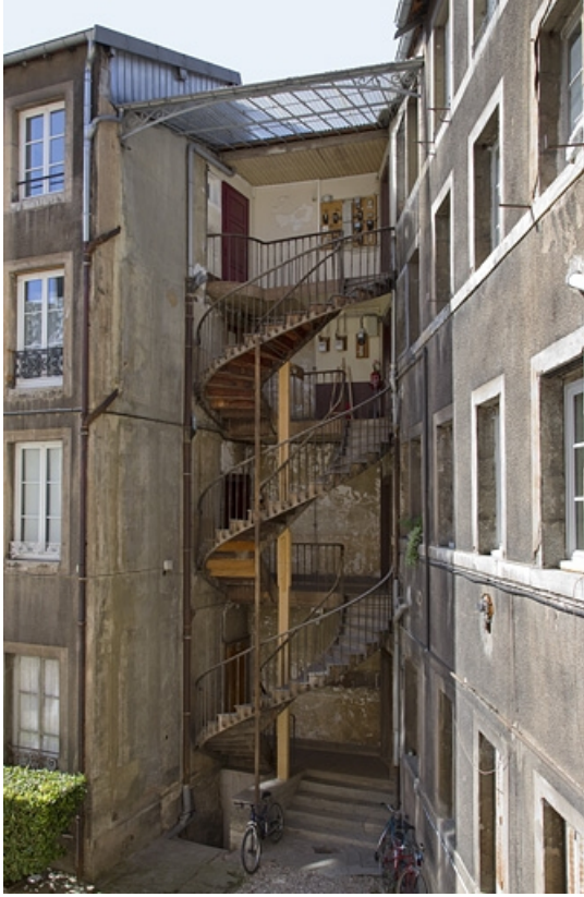
Vue d'ensemble de l'escalier à cage ouverte entre le logis secondaire droit et le logis principal. 25, Besançon, 15 rue Pasteur, lieudit : îlot d' Emskerque
