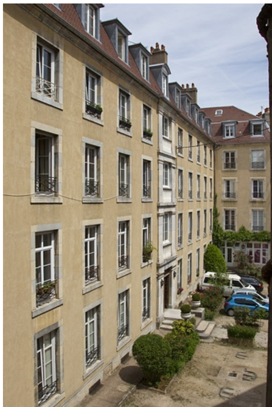
Logis secondaire gauche : vue d'ensemble de la façade antérieure, de trois quarts droit. 25, Besançon, 15 rue Pasteur, lieudit : îlot d' Emskerque
