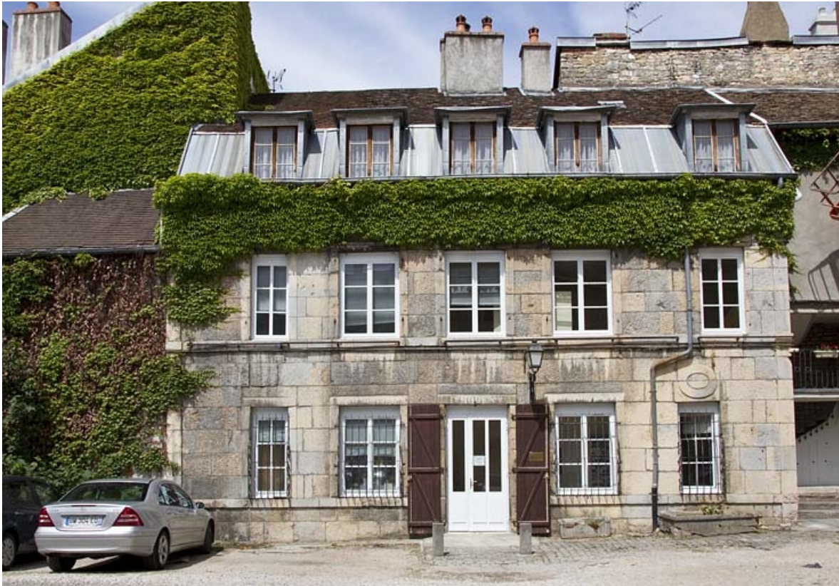
Troisième logis secondaire, façade antérieure : de face.
