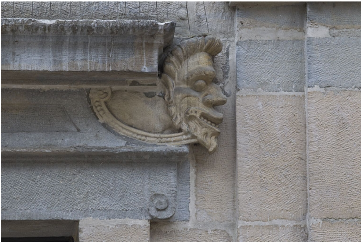
Logis principal, façade sur rue, partie droite, rez-de-chaussée, baie à droite de l'arcade boutique : mascarón droit. 25, Besançon Grande Rue 44, lieudit : îlot d' Emskerque
