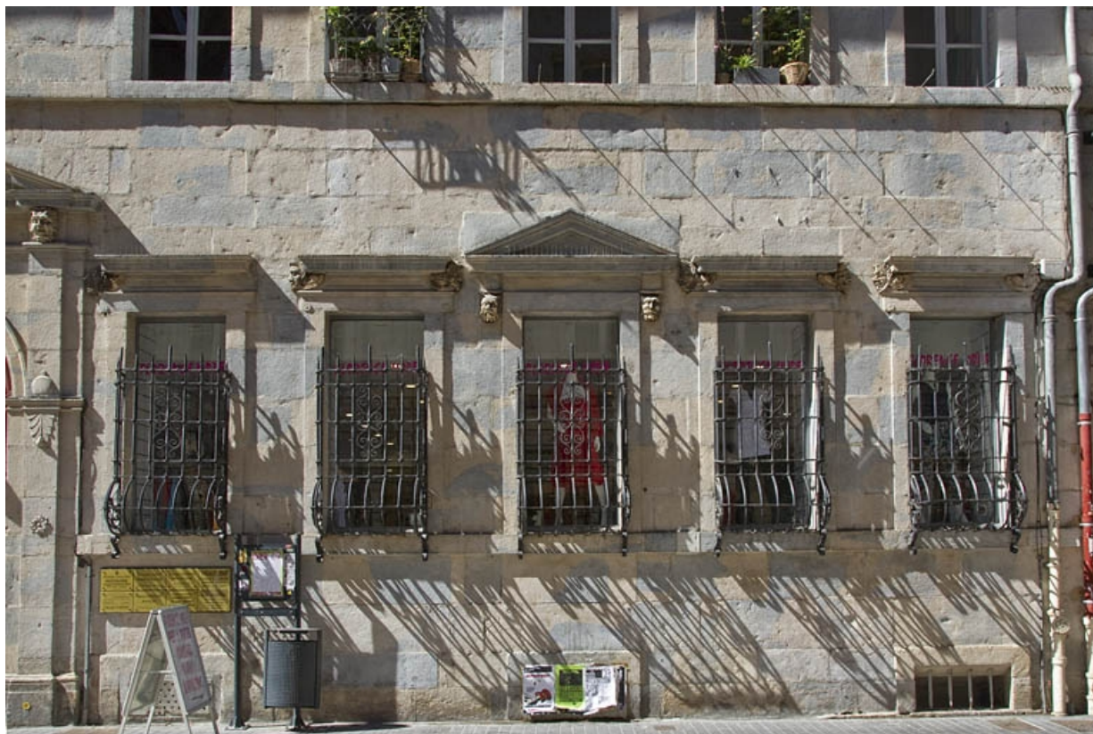
Logis principal, façade sur rue, partie droite : de face. 25, Besançon Grande Rue 44, lieudit : îlot d' Emskerque
