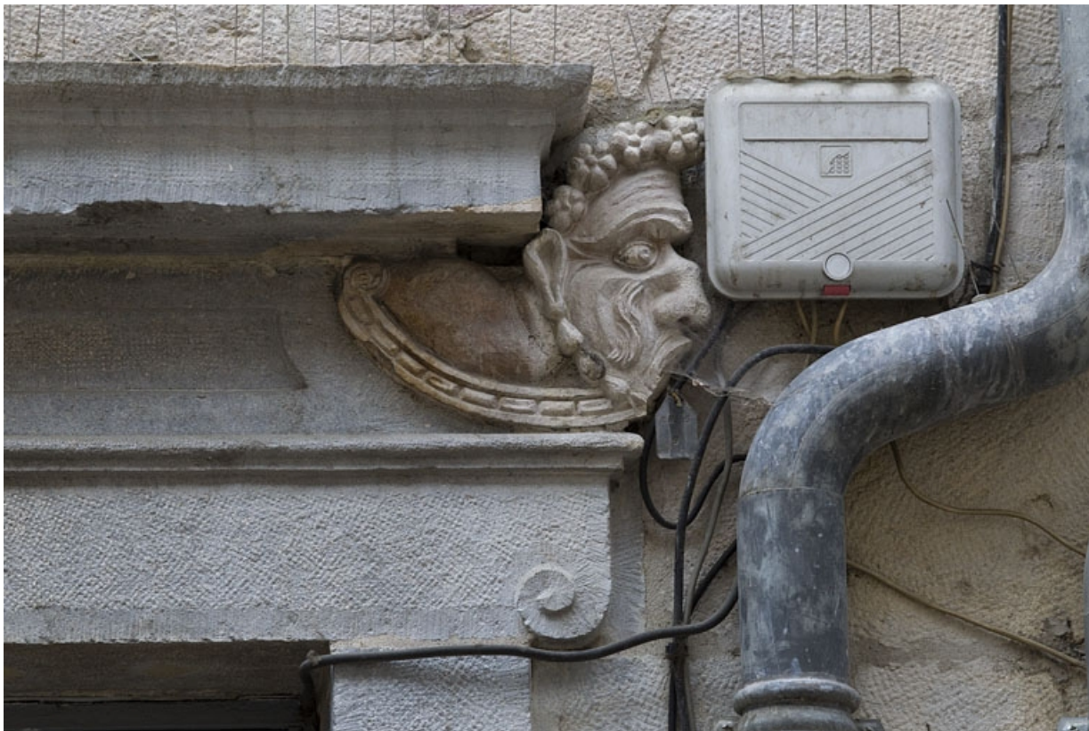
Logis principal, façade sur rue, partie droite, rez-de-chaussée, cinquième baies : mascaron droit. 25, Besançon Grande Rue 44, lieudit : îlot d' Emskerque
