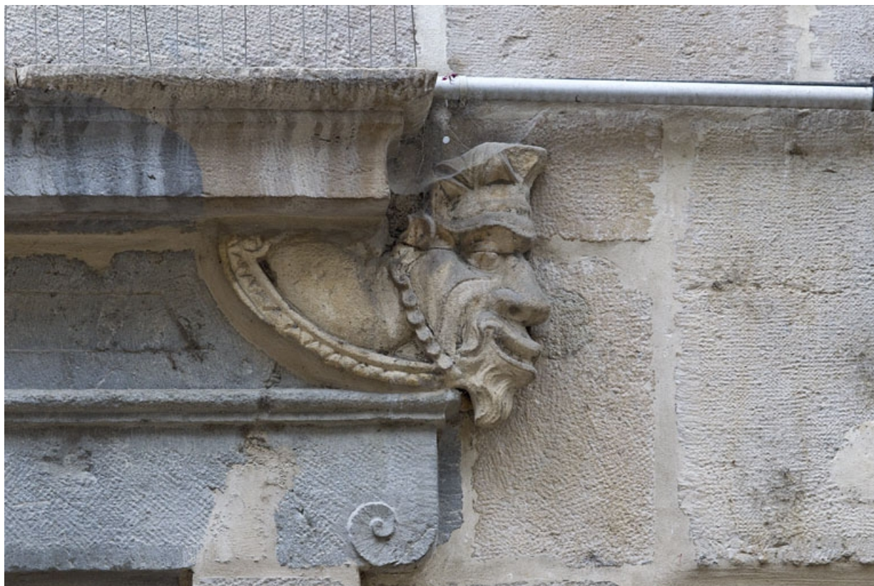
Logis principal, façade sur rue, partie droite, rez-de-chaussée, baie à gauche de l'arcade boutique : mascarón. 25, Besançon Grande Rue 44, lieudit : îlot d' Emskerque
