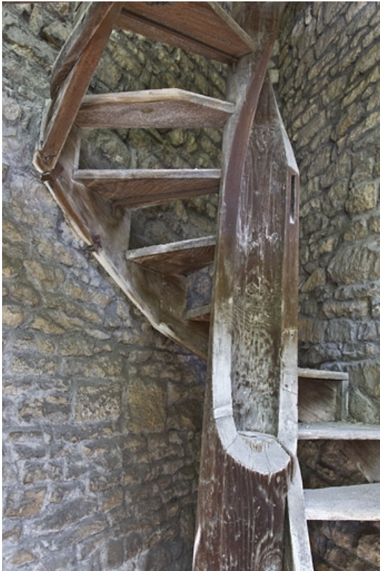
Fabrique de jardin : détail de l'escalier, vue rapprochée.
