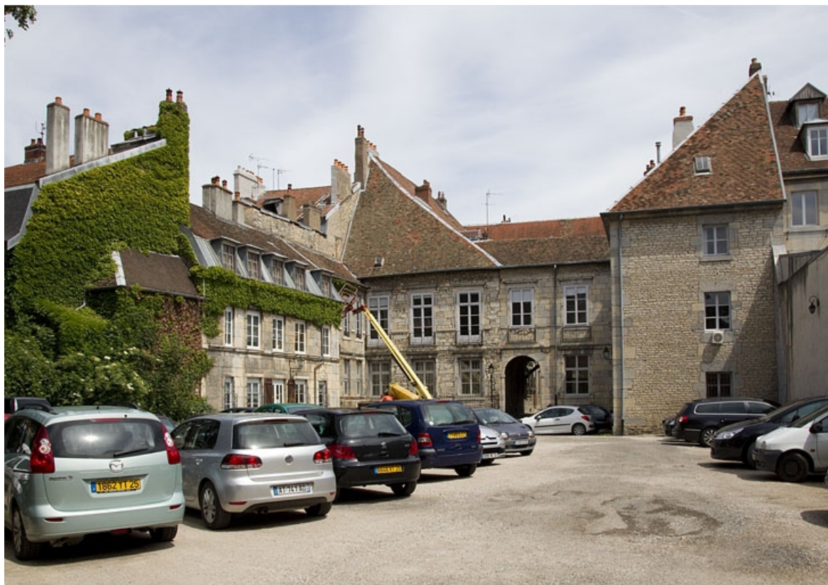
Vue d'ensemble des bâtiments depuis le fond de l'ancien jardin.
