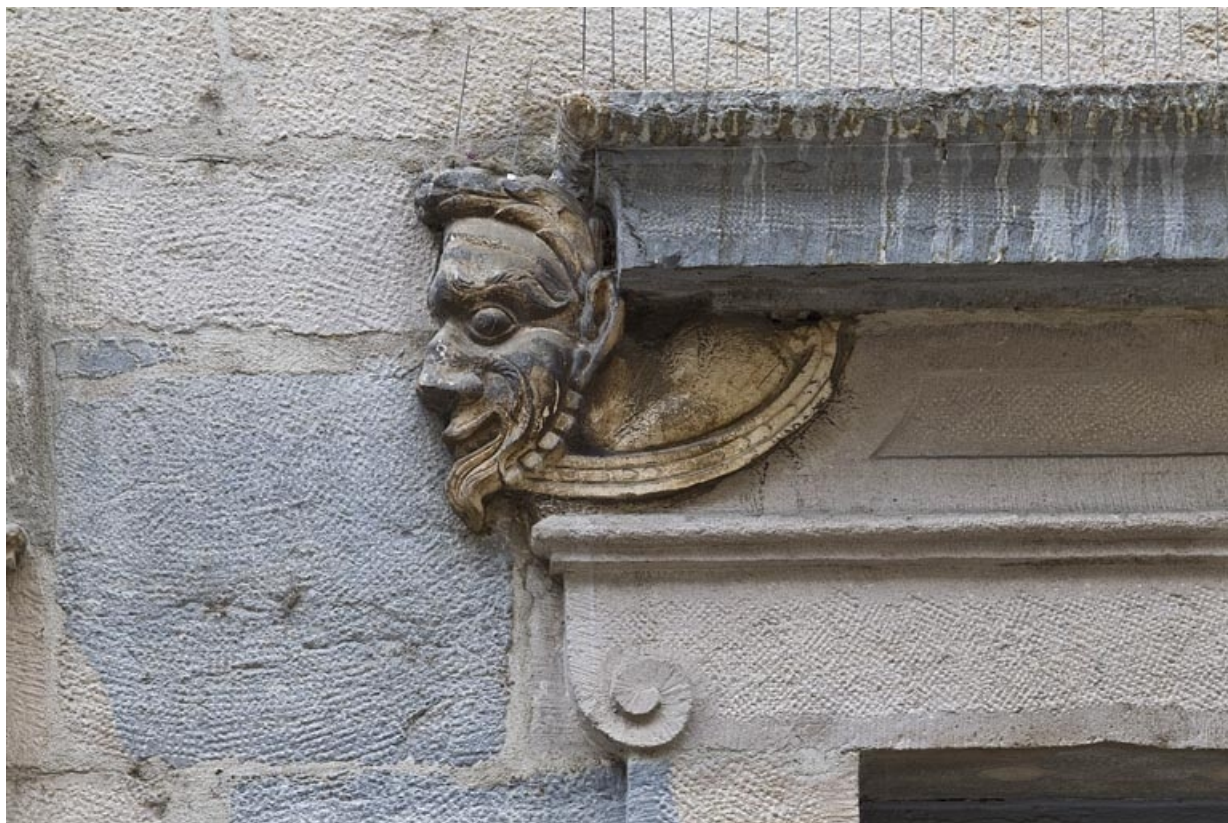
Logis principal, façade sur rue, partie droite, rez-de-chaussée, deuxième baie : mascaron droit. 25, Besançon Grande Rue 44, lieudit : îlot d' Emskerque
