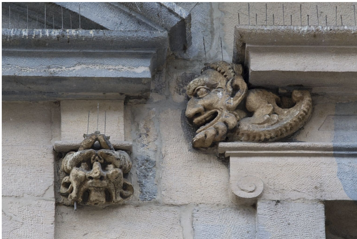
Logis principal, façade sur rue, partie gauche, premier étage, baie gauche : mascarons droit et mascarons gauche de la baie suivante. 25, Besançon Grande Rue 44, lieudit : îlot d' Emskerque
