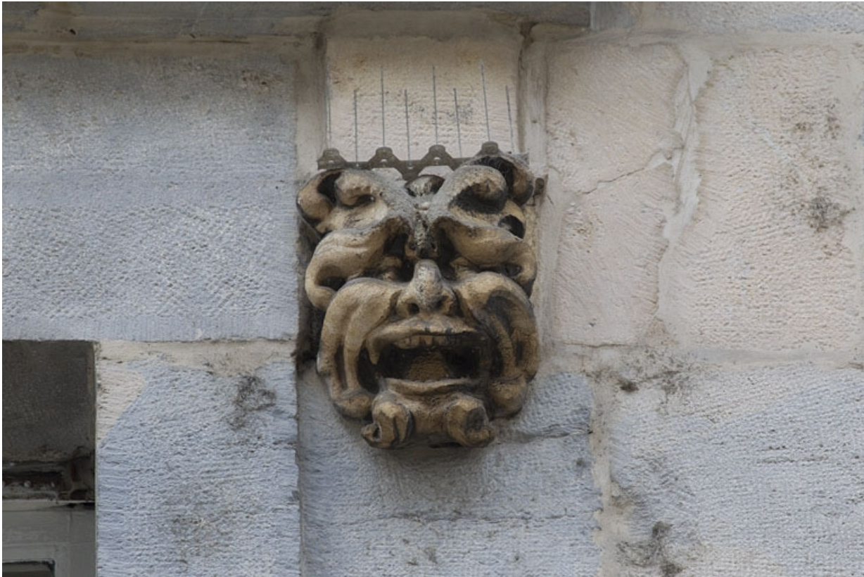
Logis principal, façade sur rue, partie gauche, premier étage, quatrième baie : mascaron droit. 25, Besançon Grande Rue 44, lieudit : îlot d' Emskerque
