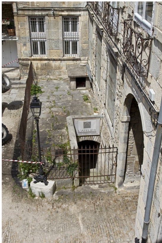
Vue de l'entrée de cave du logis principal donnant sur l'ancien jardin.
