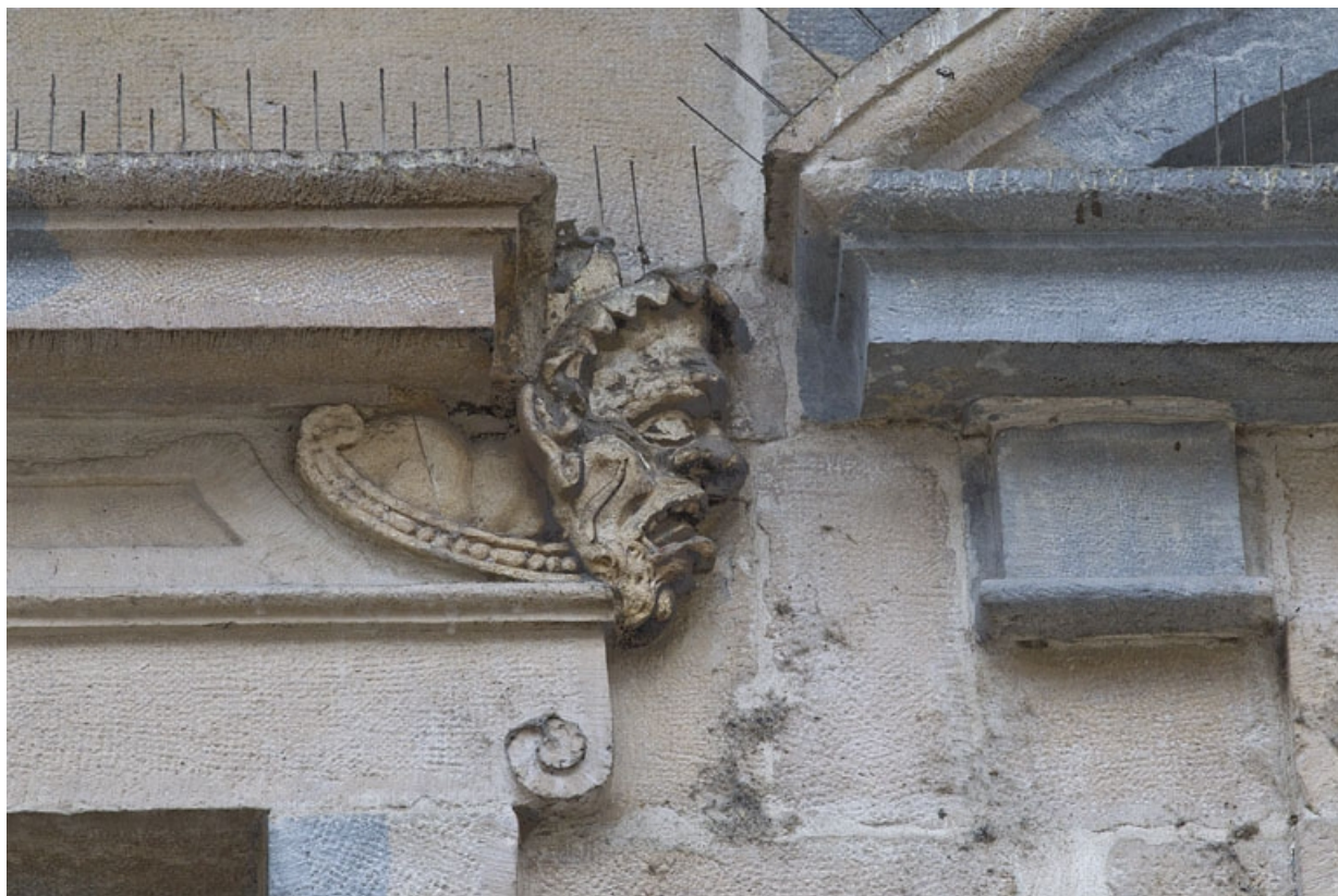
Logis principal, façade sur rue, premier étage, partie droite, fenêtre droite : mascaron droit. 25, Besançon Grande Rue 44, lieudit : îlot d' Emskerque
