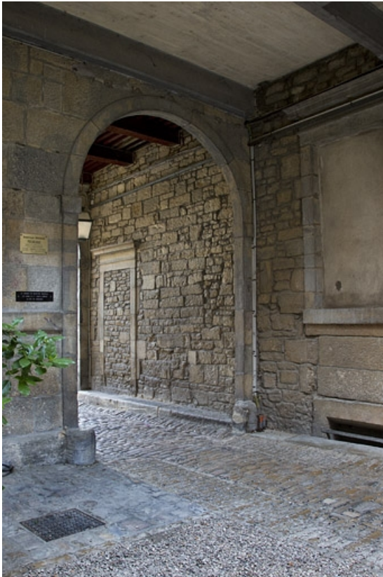
Vue du deuxième passage cocher depuis la cour, de trois quarts gauche.
