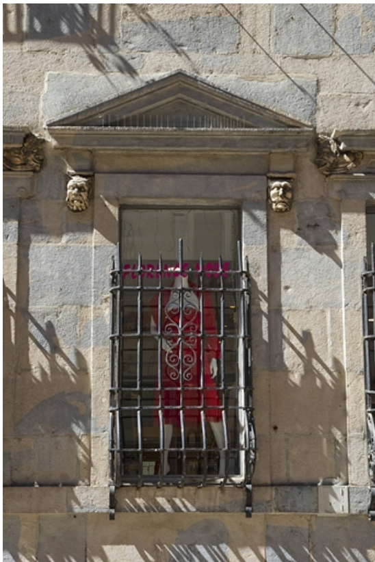
Logis principal, façade sur rue, partie droite : détail de la fenêtre centrale. 25, Besançon Grande Rue 44, lieudit : îlot d' Emskerque
