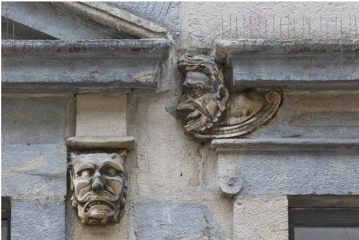
Logis principal, façade sur rue, partie droite, rez-de-chaussée, quatrième baie : mascarón gauche, et mascarón droit de la baie centrale.
