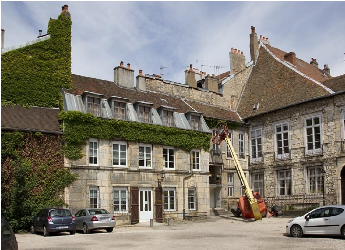
Troisième logis secondaire, à droite de l'ancien jardin : de trois quarts gauche, vue rapprochée. 25, Besançon Grande Rue 44, lieudit : îlot d' Emskerque
