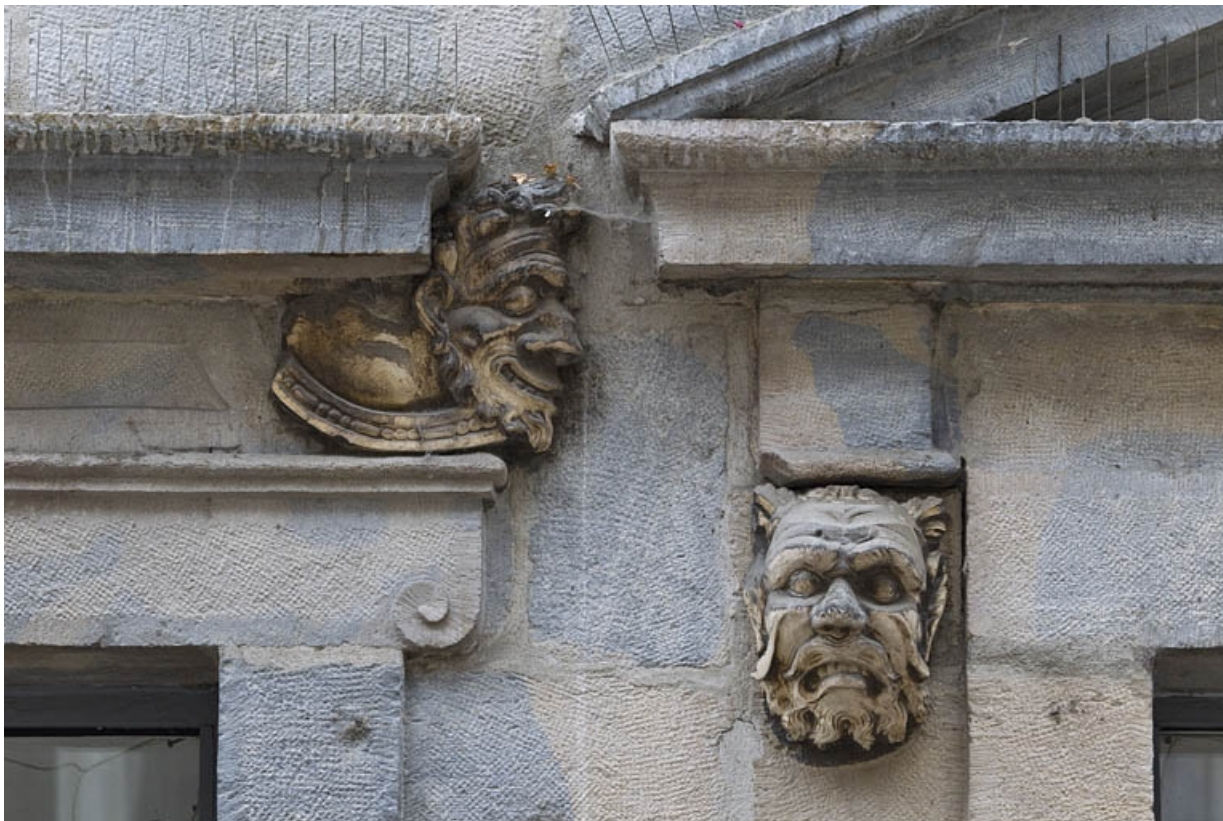
Logis principal, façade sur rue, partie droite, rez-de-chaussée, troisième baie : mascarons droit, et mascarons gauche de la baie centrale.
