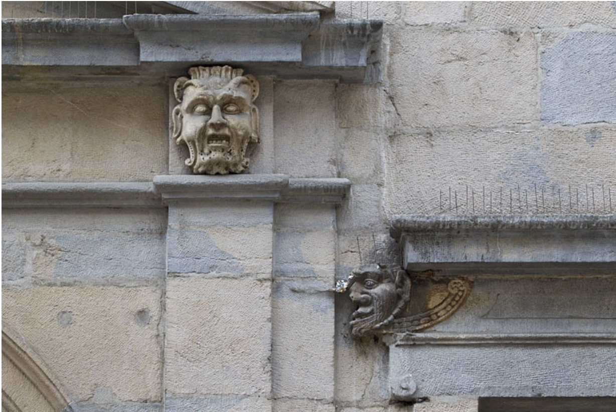
Logis principal, façade sur rue, partie droite, rez-de-chaussée : portail, mascaron droit et mascaron gauche de la première baie. 25, Besançon Grande Rue 44, lieudit : îlot d' Emskerque
