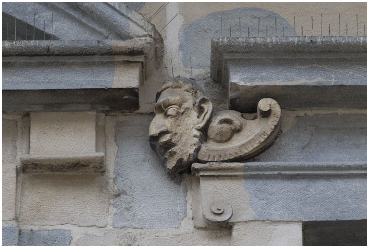
Logis principal, façade sur rue, premier étage, partie droite, troisième fenêtre : mascaron gauche. 25, Besançon Grande Rue 44, lieudit : îlot d' Emskerque
