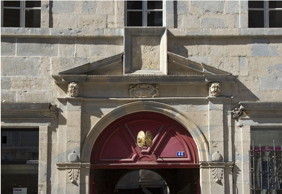
Logis principal, portail d'entrée : détail du fronton interrompu à tabernacle. 25, Besançon Grande Rue 44, lieudit : îlot d' Emskerque
