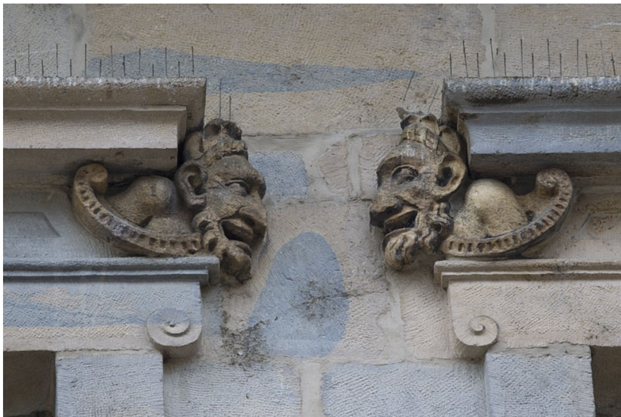
Logis principal, façade sur rue, partie gauche, premier étage, deuxième et troisième baies : mascarons gauche et droit. 25, Besançon Grande Rue 44, lieudit : îlot d' Emskerque
