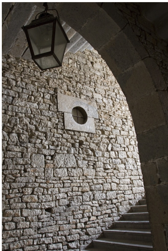
Logis principal, intérieur : détail de la cage d'escalier. 25, Besançon Grande Rue 44, lieudit : îlot d' Emskerque
