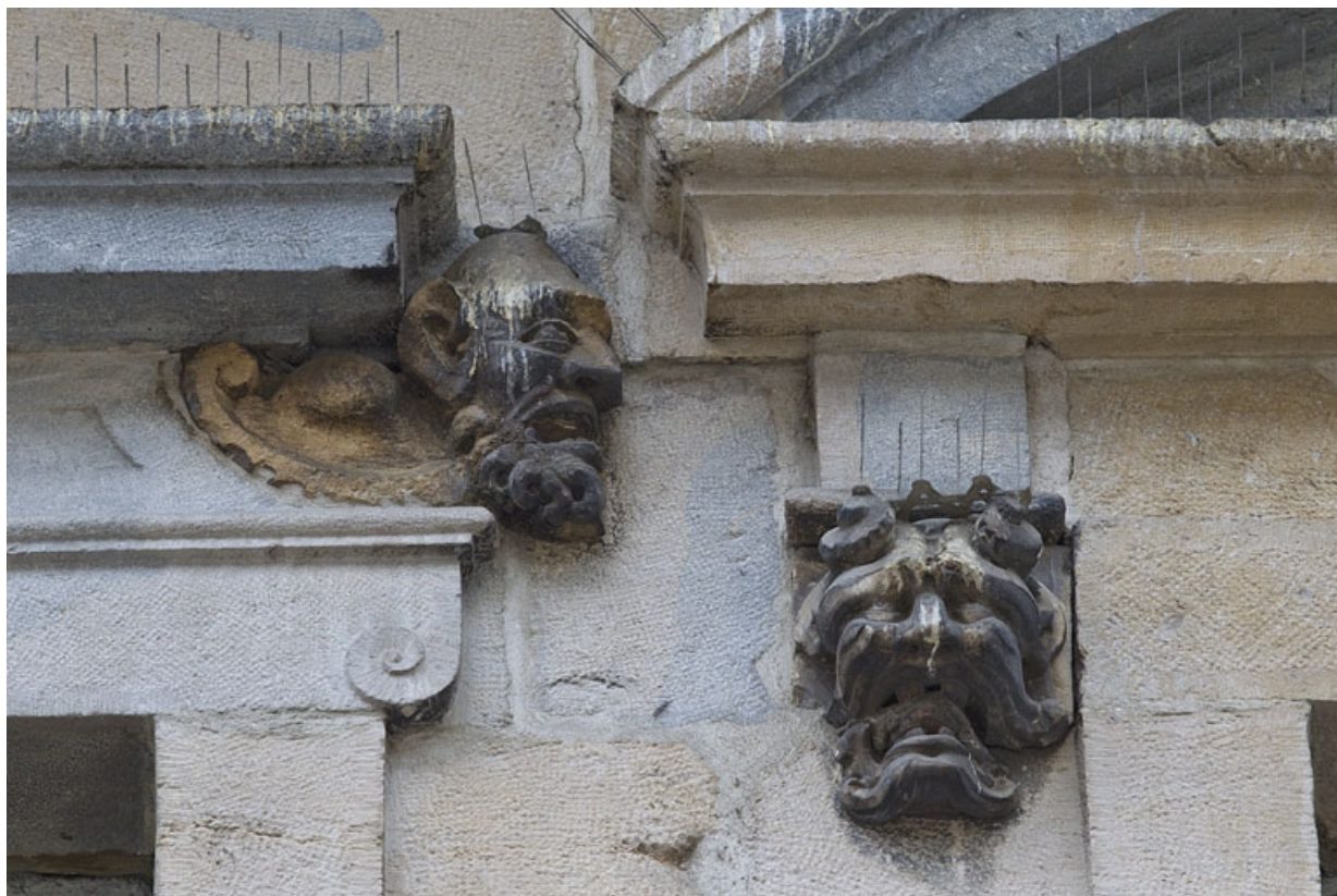
Logis principal, façade sur rue, premier étage, partie droite, quatrième et cinquième fenêtres : mascarons gauche et droit. 25, Besançon Grande Rue 44, lieudit : îlot d' Emskerque
