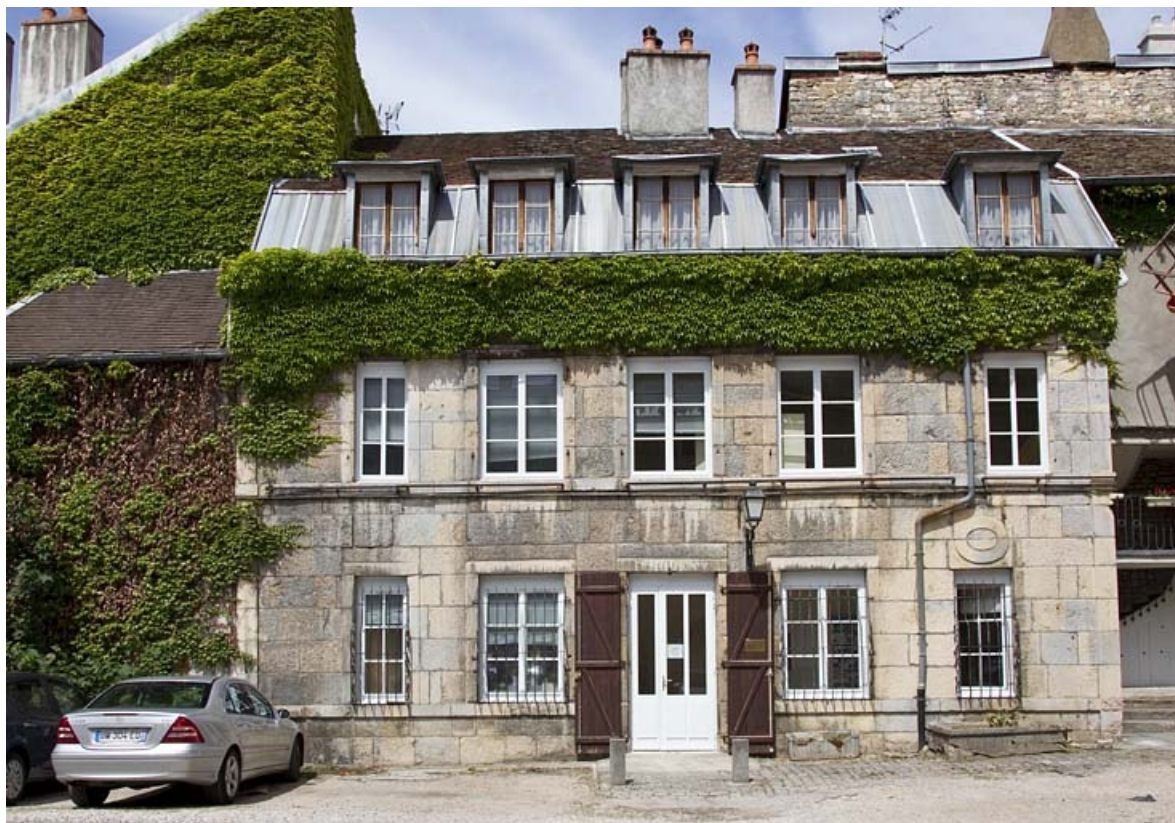
Troisième logis secondaire, façade antérieure : de face.
