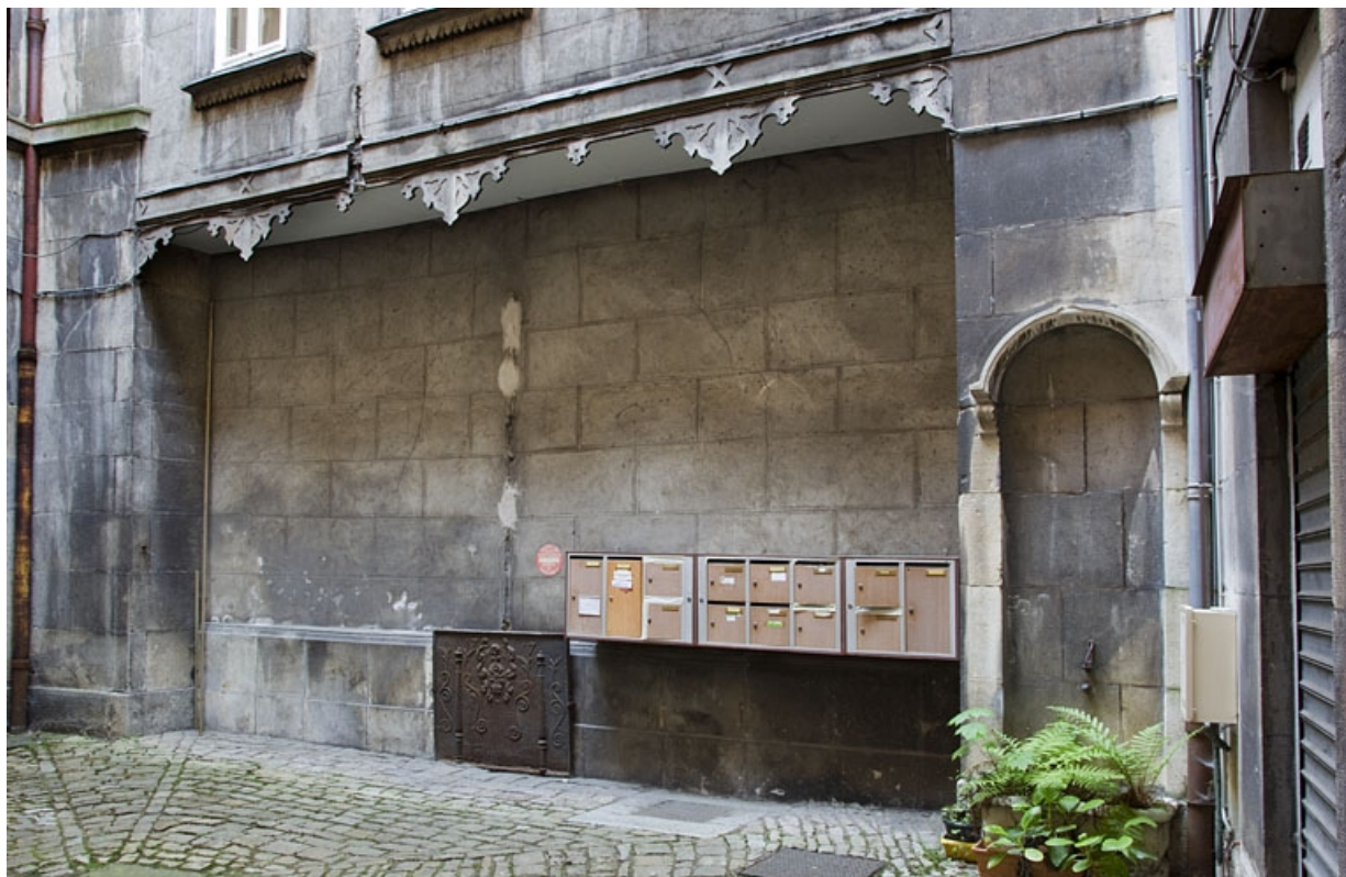
Première cour : vue d'ensemble du puits.
