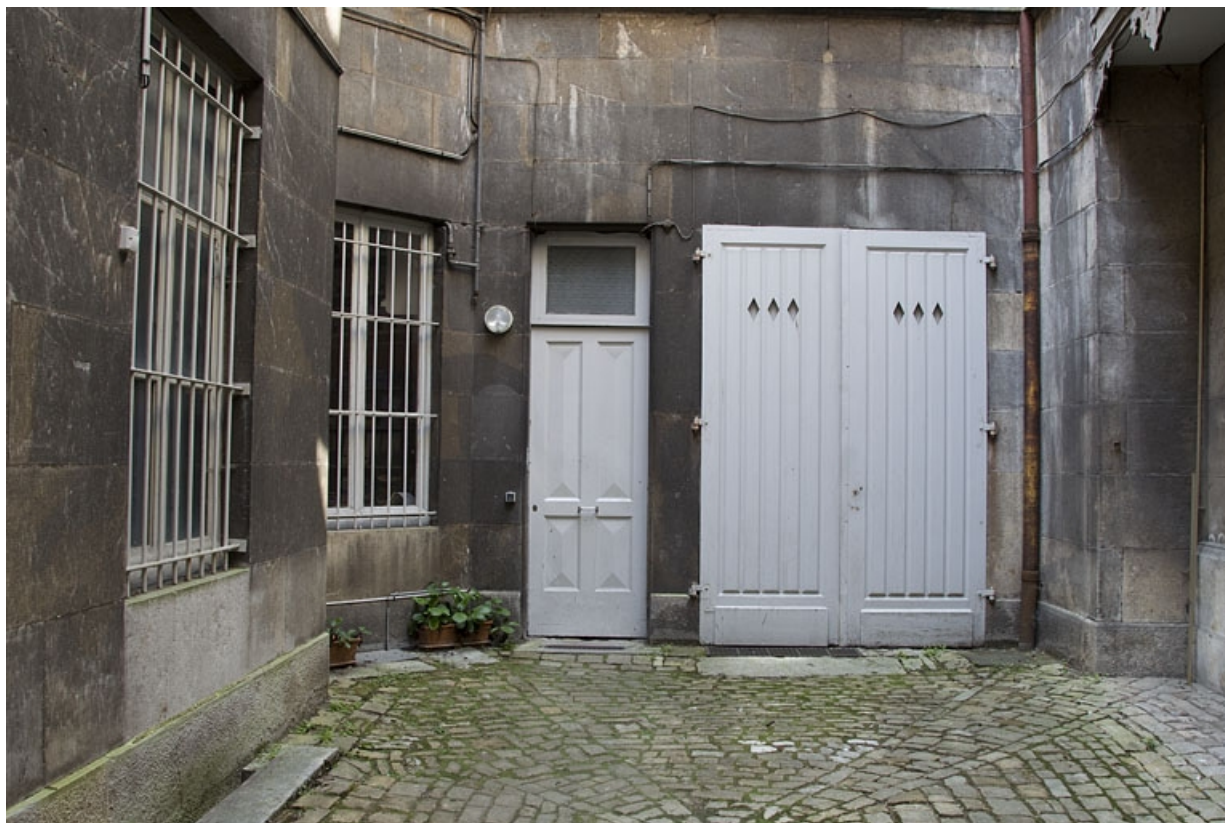
Première cour : vue de la remise et de la porte conduisant à la deuxième cour.
