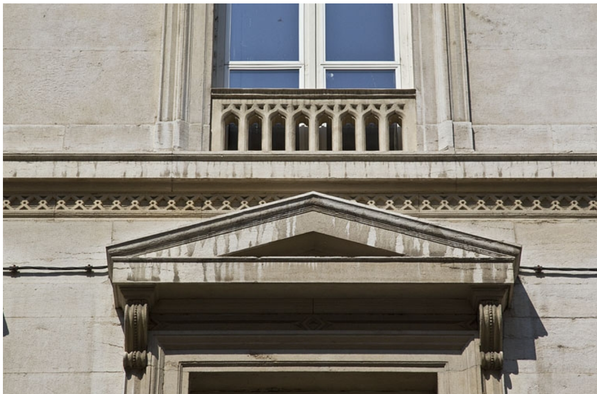
Logis principal : détail d'un fronton d'une fenêtre du premier étage.
