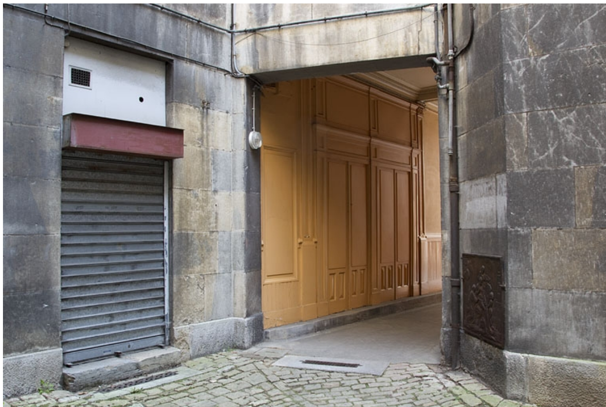
Vue du passage cocher depuis la première cour.
