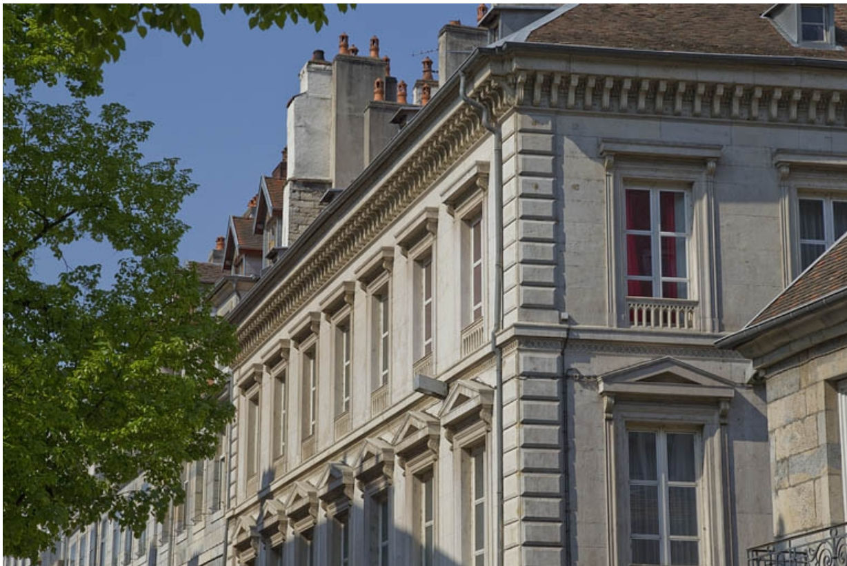
Logis principal : détail des fenêtres du deuxième étage sur la rue de la Préfecture.
