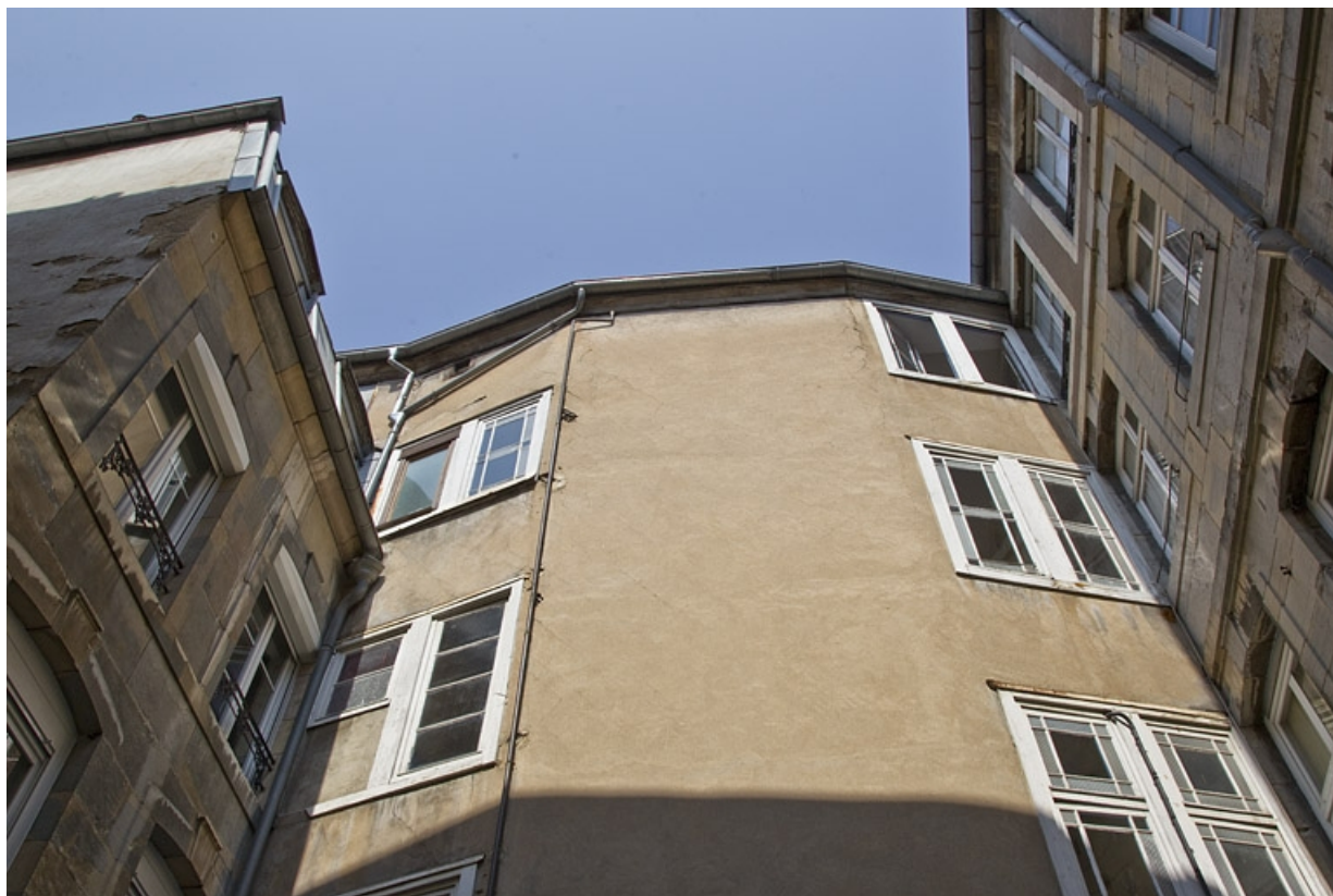
Escalier à droite de la première cour : vue de la cage extérieure.
