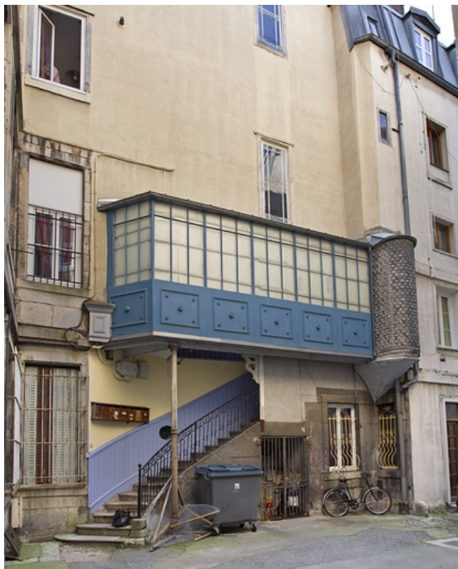
Escalier à cage ouverte à gauche de la première cour : de trois quarts gauche. 25, Besançon, 26 rue Mégevand, lieudit : îlot Mairie
