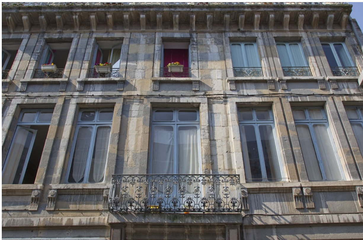
Logis principal, façade sur rue : détail des premier et deuxième étages, de face. 25, Besançon, 26 rue Mégevand, lieudit : îlot Mairie
