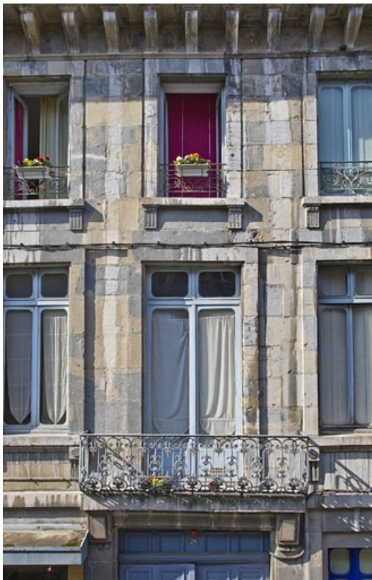
Logis principal, façade sur rue, premier étage : détail de la porte-fenêtre et du balcon. 25, Besançon, 26 rue Mégevand, lieudit : îlot Mairie
