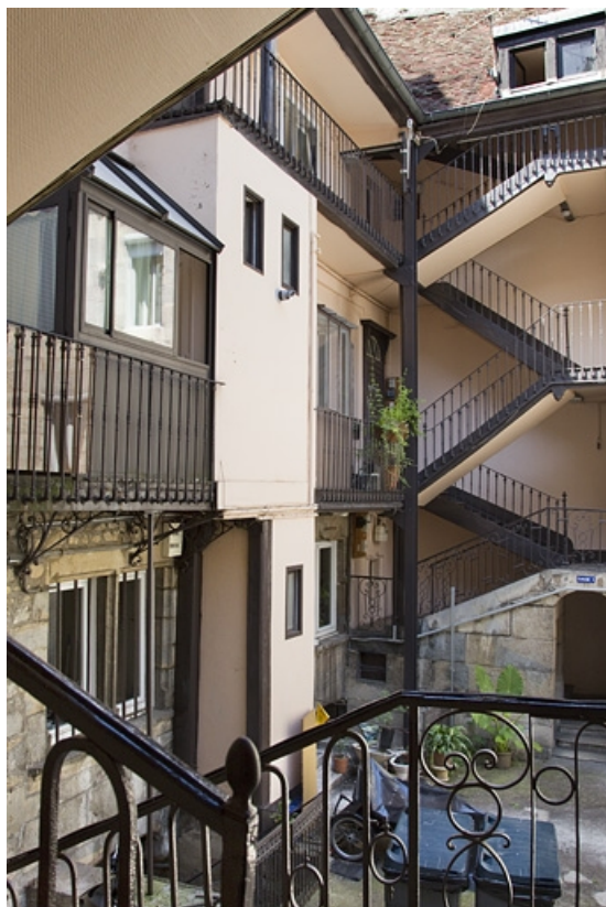
Vue d'ensemble de l'escalier à cage ouverte gauche, depuis l'escalier droit. 25, Besançon, 11 rue Rivotte, lieudit : îlot des Jacobins
