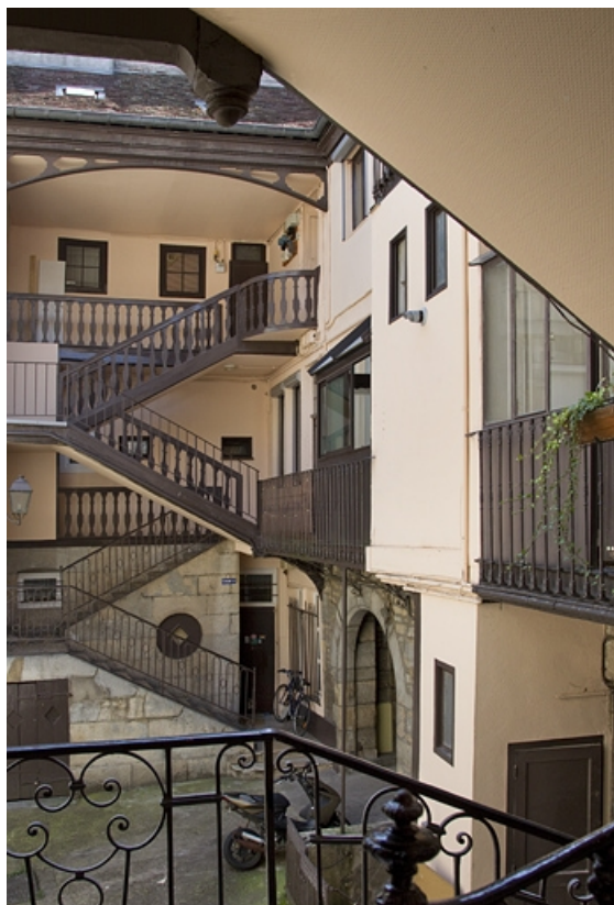
Escalier à cage ouverte droit : vue d'ensemble éloignée, de face.
