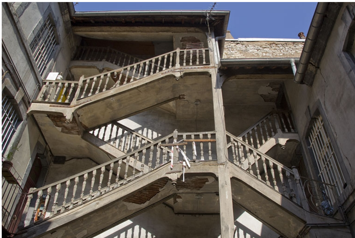
Escalier à cage ouverte sur cour, partie supérieure, de face.
