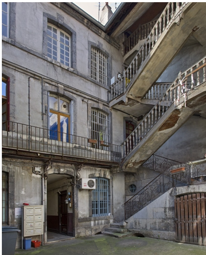
Logis principal : détail de la façade postérieure et de l'escalier à cage ouverte, de trois quarts gauche. 25, Besançon, 13 rue Rivotte, lieudit : îlot des Jacobins
