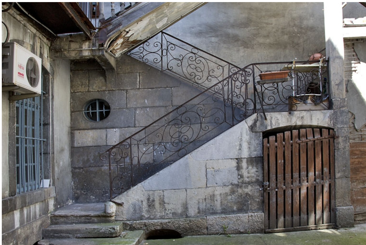
Escalier à cage ouverte : détail de la rampe en ferronnerie des premières volées.
