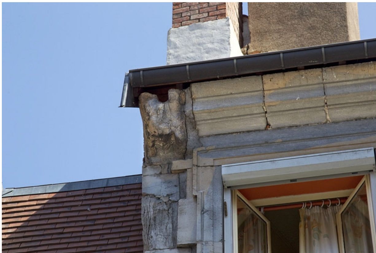
Logis principal, façade antérieure : détail de la gargouille gauche.
