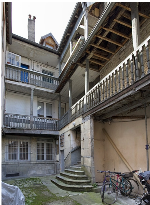
Vue d'ensemble de la façade postérieure du logis principal et de l'escalier extérieur.
