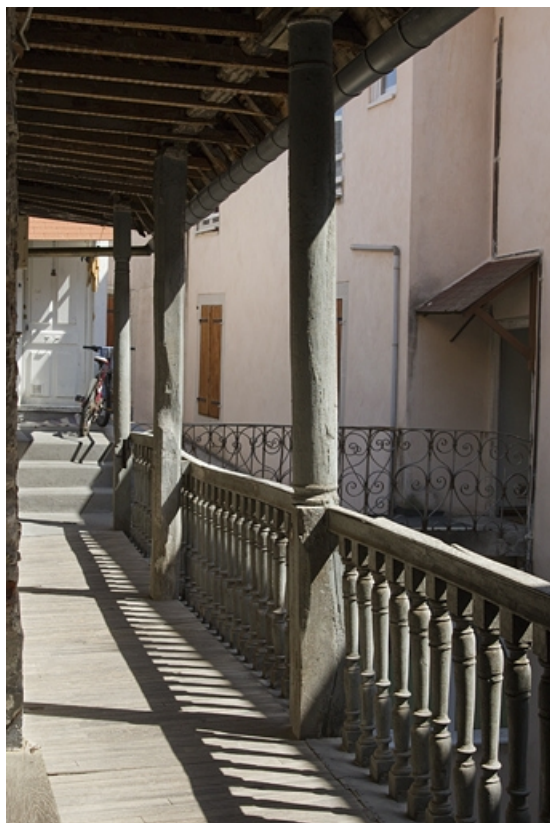
Escalier extérieur : détail de la coursière du premier étage, depuis l'intérieur.
