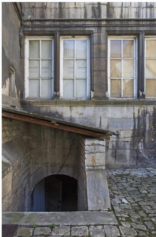
Logis principal, façade postérieure : détail de l'entrée de la cave.
