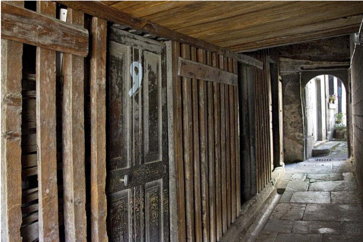
Premier logis secondaire : détail des bûchers donnant sur le couloir.
