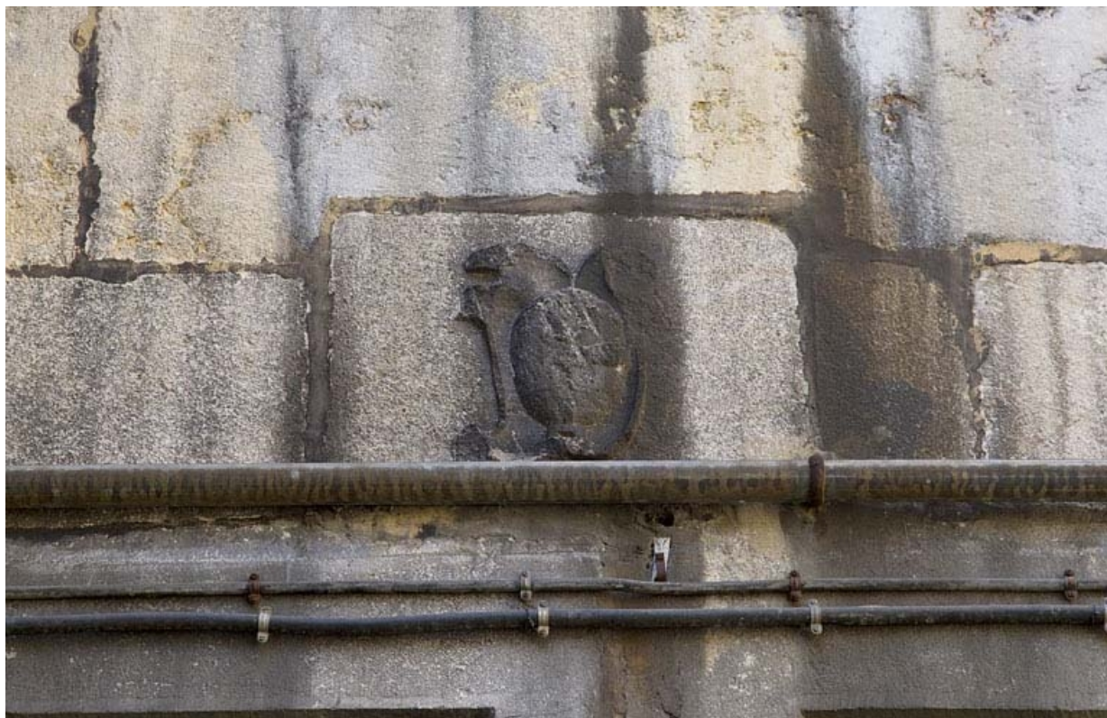
Logis principal, façade postérieure : détail du cartouche situé au-dessus d'une fenêtre. 25, Besançon, 19 rue de Pontarlier, lieudit : îlot des Jacobins
