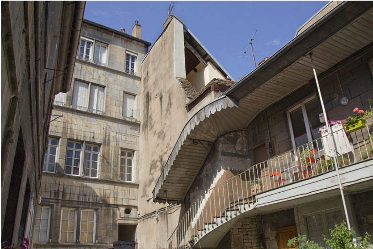
Vue d'ensemble de la façade postérieure du logis principal et du premier logis secondaire, depuis le fond de la cour. 25, Besançon, 19 rue de Pontarlier, lieudit : îlot des Jacobins
