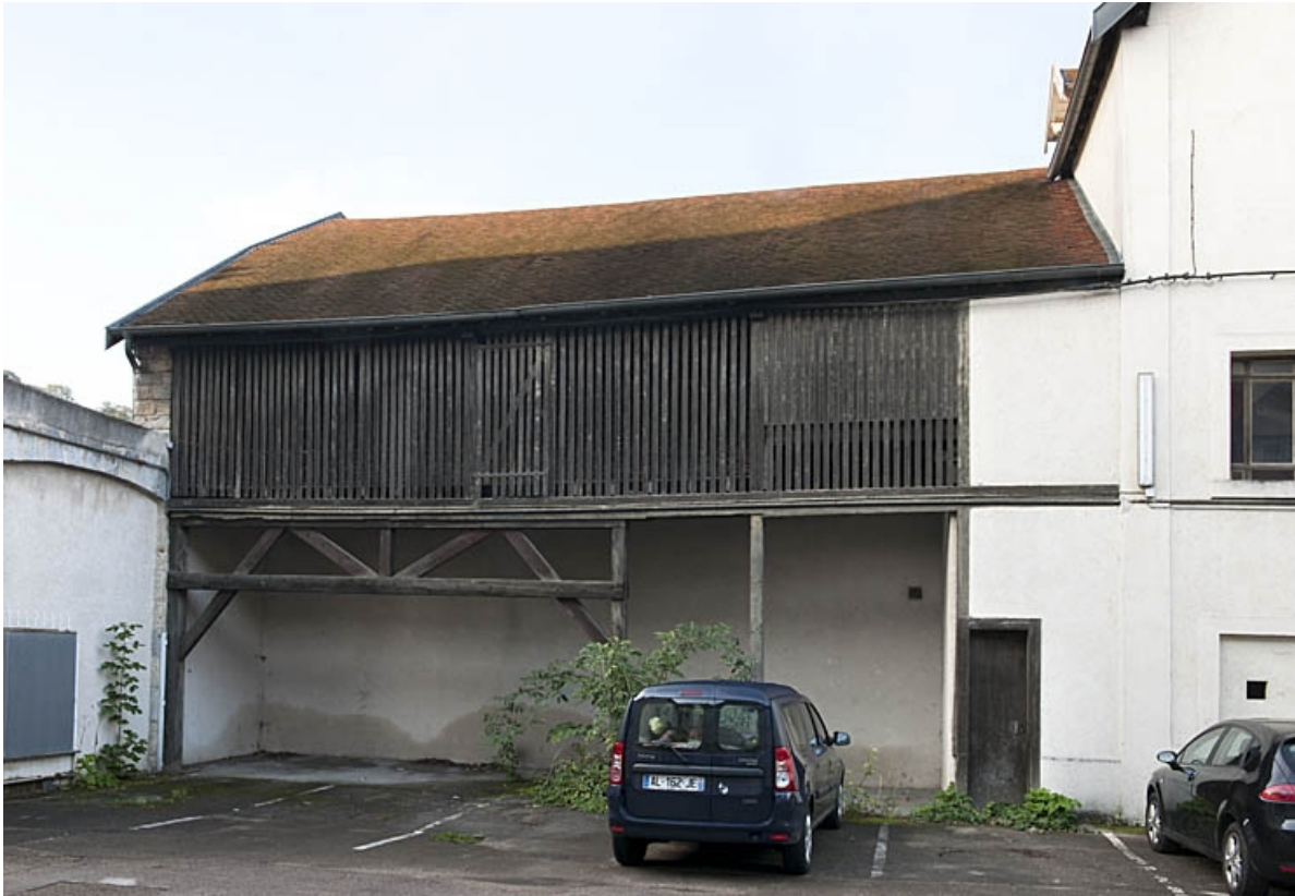
Vue d'ensemble du bûcher situé dans la deuxième cour.
