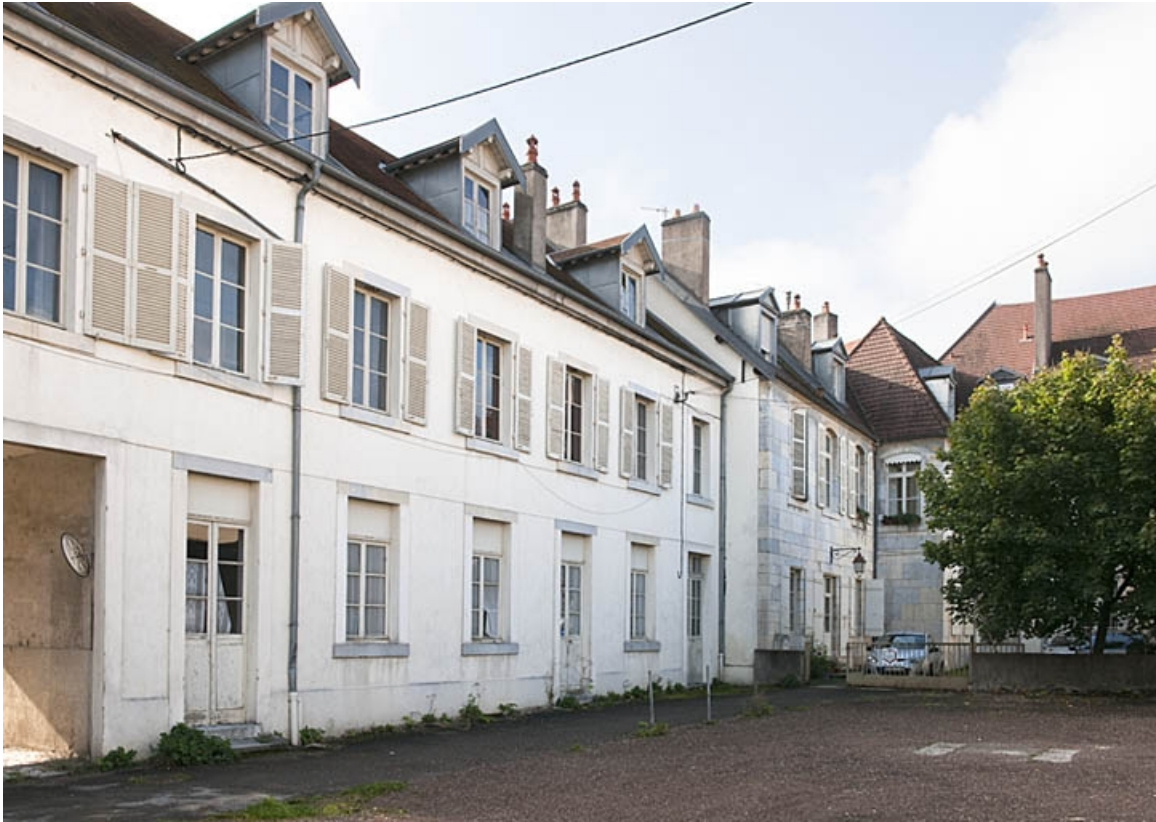
Aile droite : vue d'ensemble de trois quarts gauche.
