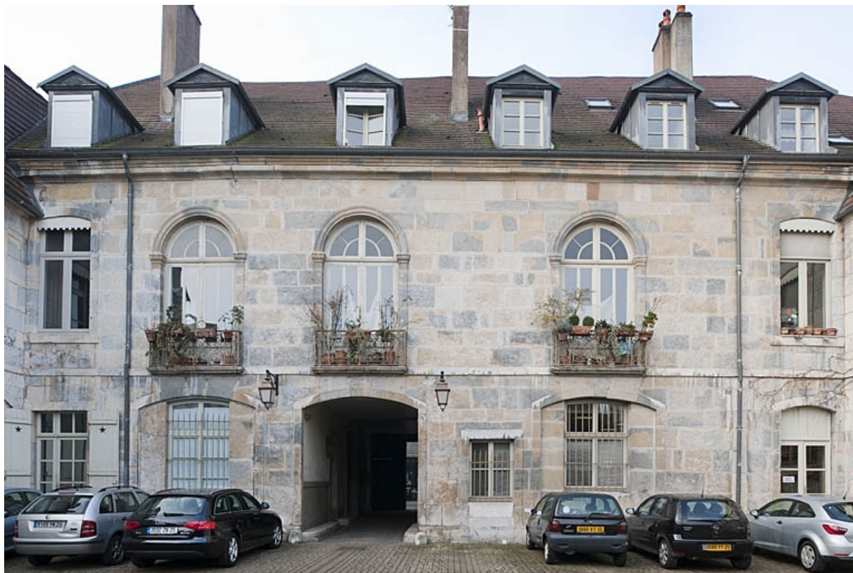
façade postérieure de l'hôtel : de face.
