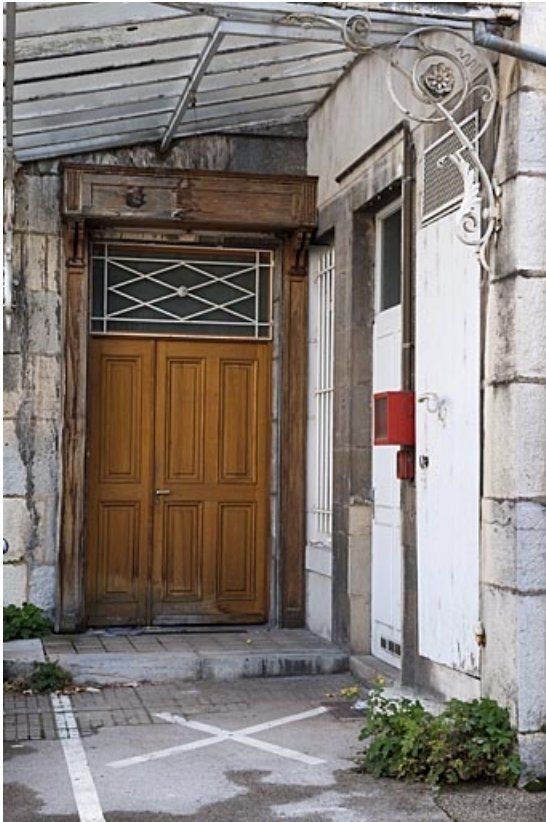
Logis au fond de la deuxième cour : détail de la porte d'entrée.
