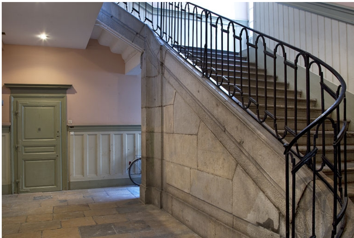
Logis principal, intérieur : détail de l'escalier, première volée.
