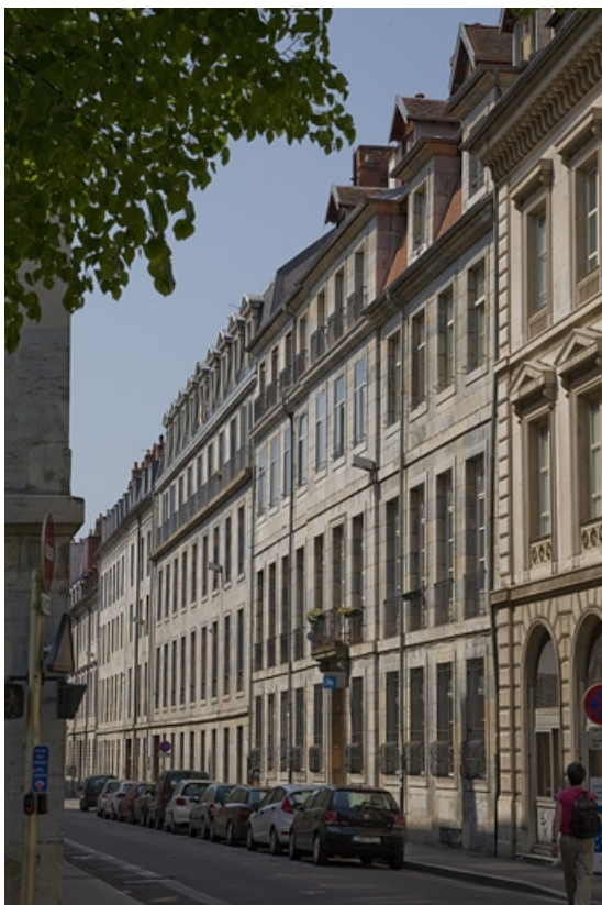
Logis principal, façade sur rue : de trois quarts droit. 25, Besançon, 16 rue de la Préfecture, lieudit : îlot Mairie
