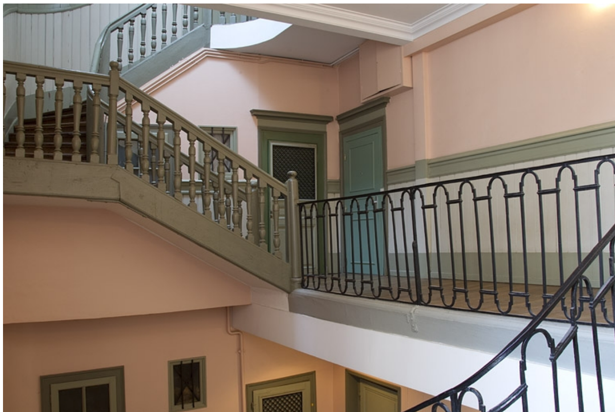
Logis principal, intérieur : détail de la cage d'escalier, partie supérieure. 25, Besançon, 16 rue de la Préfecture, lieudit : îlot Mairie
