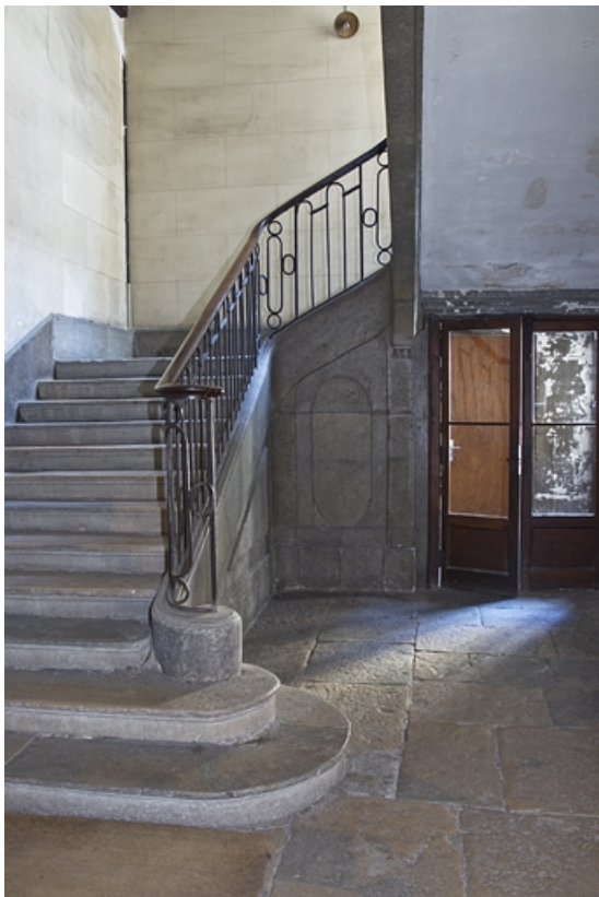
Logis principal, intérieur : détail du départ de l'escalier principal.
