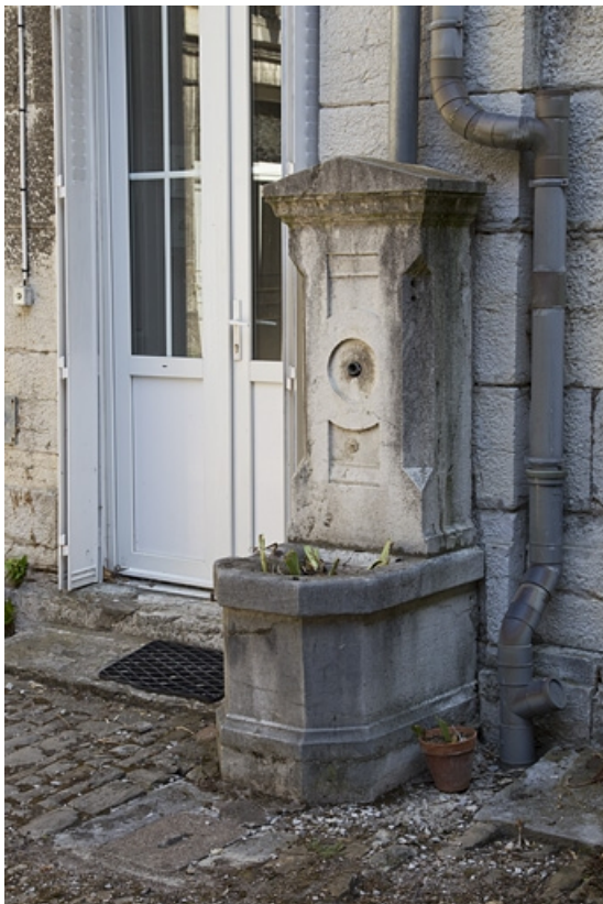
Détail de la fontaine située dans la cour.
