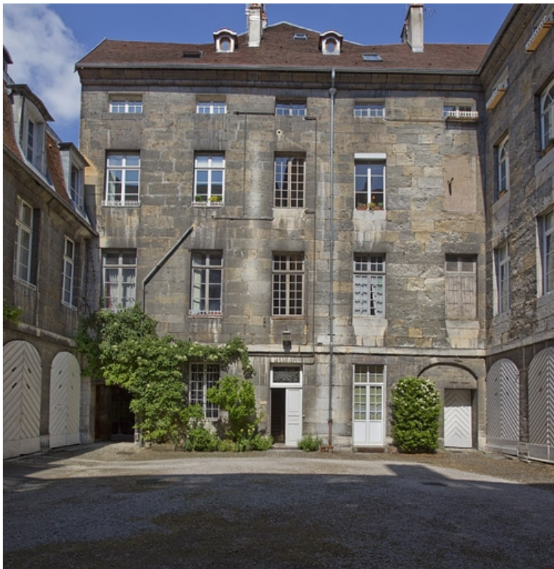
Logis principal, façade au fond de la cour : de face.
