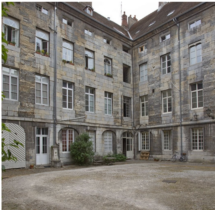
Vue du logis principal depuis le fond de la cour : de trois quarts droit.
