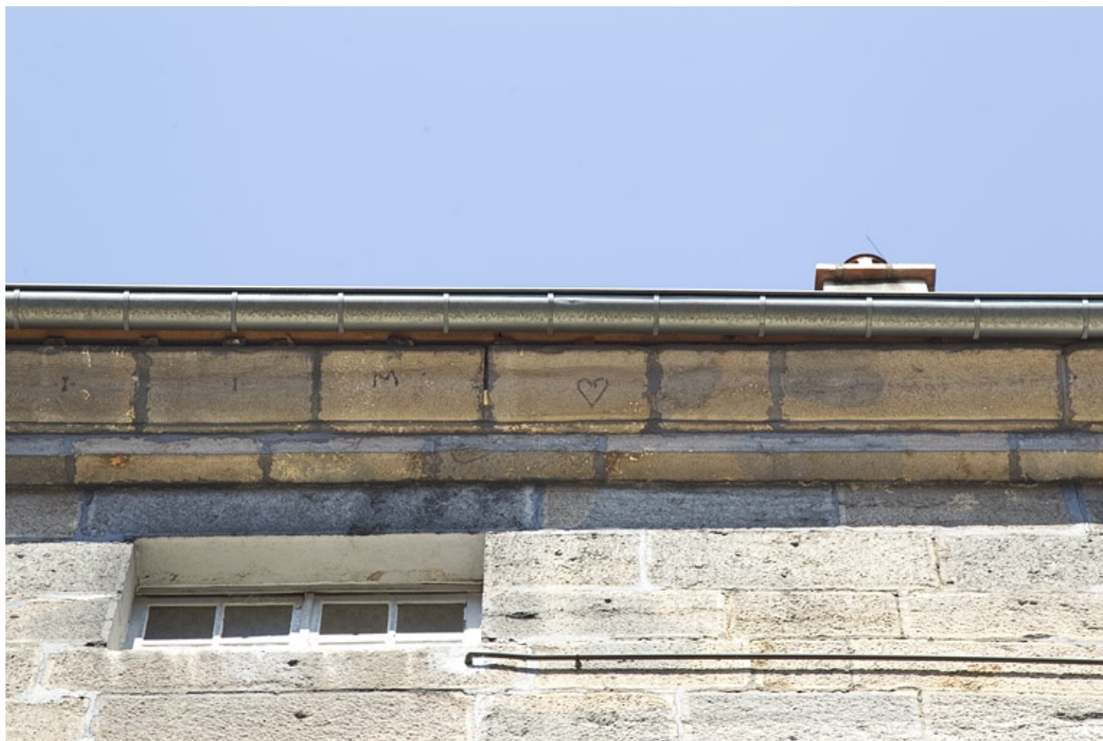
Logis principal, aile en fond de cour : détail des marques de tâcheron sur la corniche du toit.
