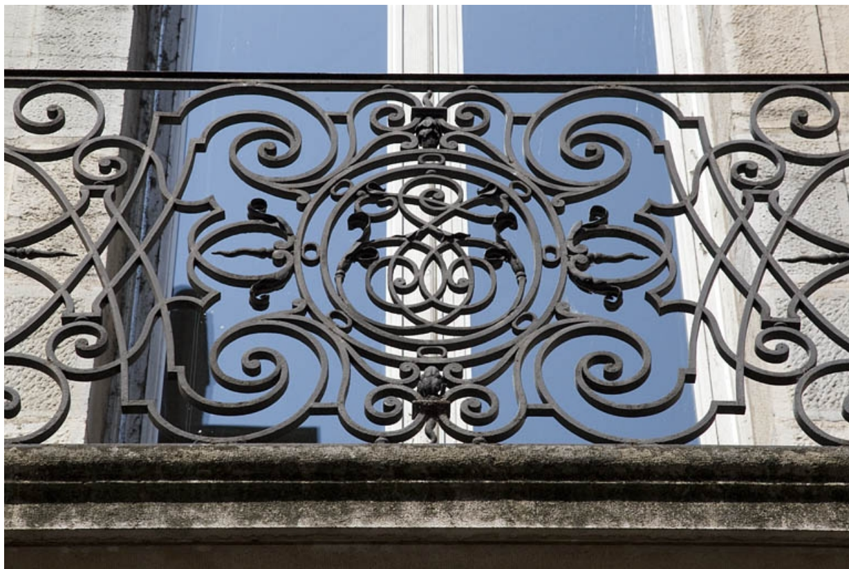
Logis principal, façade sur rue : détail de la ferronnerie du balcon.
