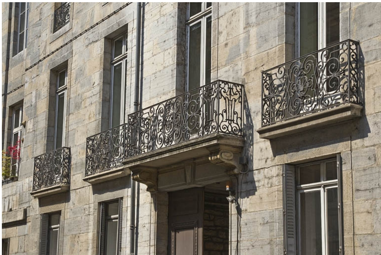
Logis principal, façade sur rue : détail du balcon et des garde-corps en ferronnerie du premier étage. 25, Besançon, 26 rue de la Préfecture, lieudit : îlot Mairie
