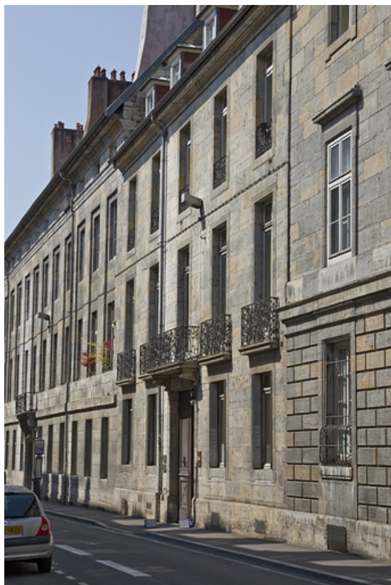
Logis principal, façade sur rue : de trois quarts droit. 25, Besançon, 26 rue de la Préfecture, lieudit : îlot Mairie
