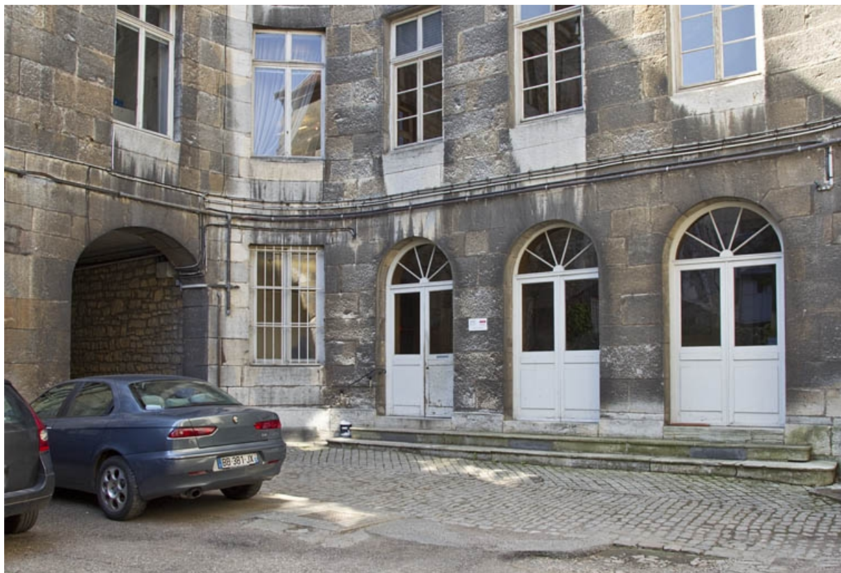
Logis principal : rez-de-chaussée de l'aile de l'escalier située dans la cour. 25, Besançon, 26 rue de la Préfecture, lieudit : îlot Mairie
