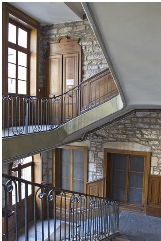
Logis principal, intérieur : partie inférieure de la cage d'escalier.
