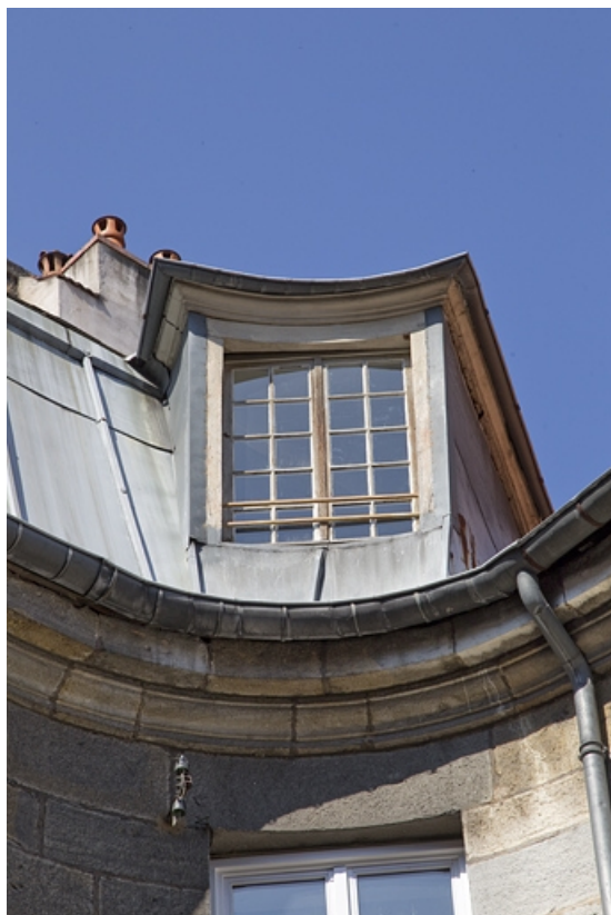
Logis principal : détail d'une lucarne donnant sur la cour.
