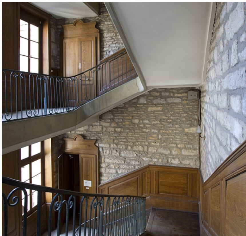
Logis principal, intérieur : partie supérieure de la cage d'escalier.
