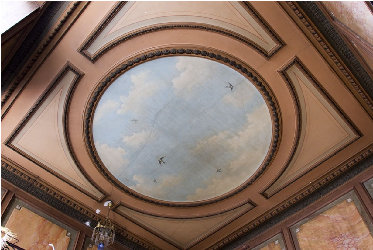
Logis principal, intérieur : plafond de la cage d'escalier, vue d'ensemble. 25, Besançon, 24 rue de la Préfecture, lieudit : îlot Mairie
