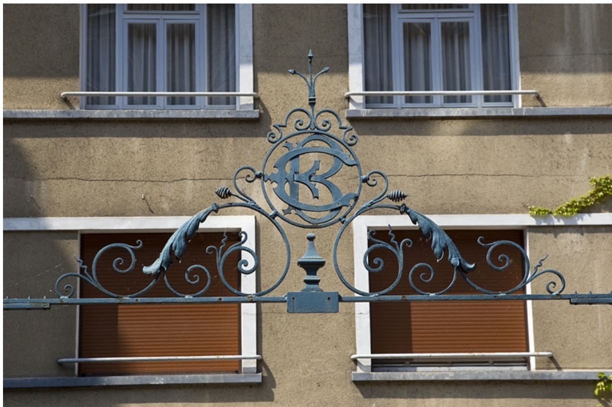
Détail du couronnement du portail de la grille en fer forgé séparant les deux cours.
