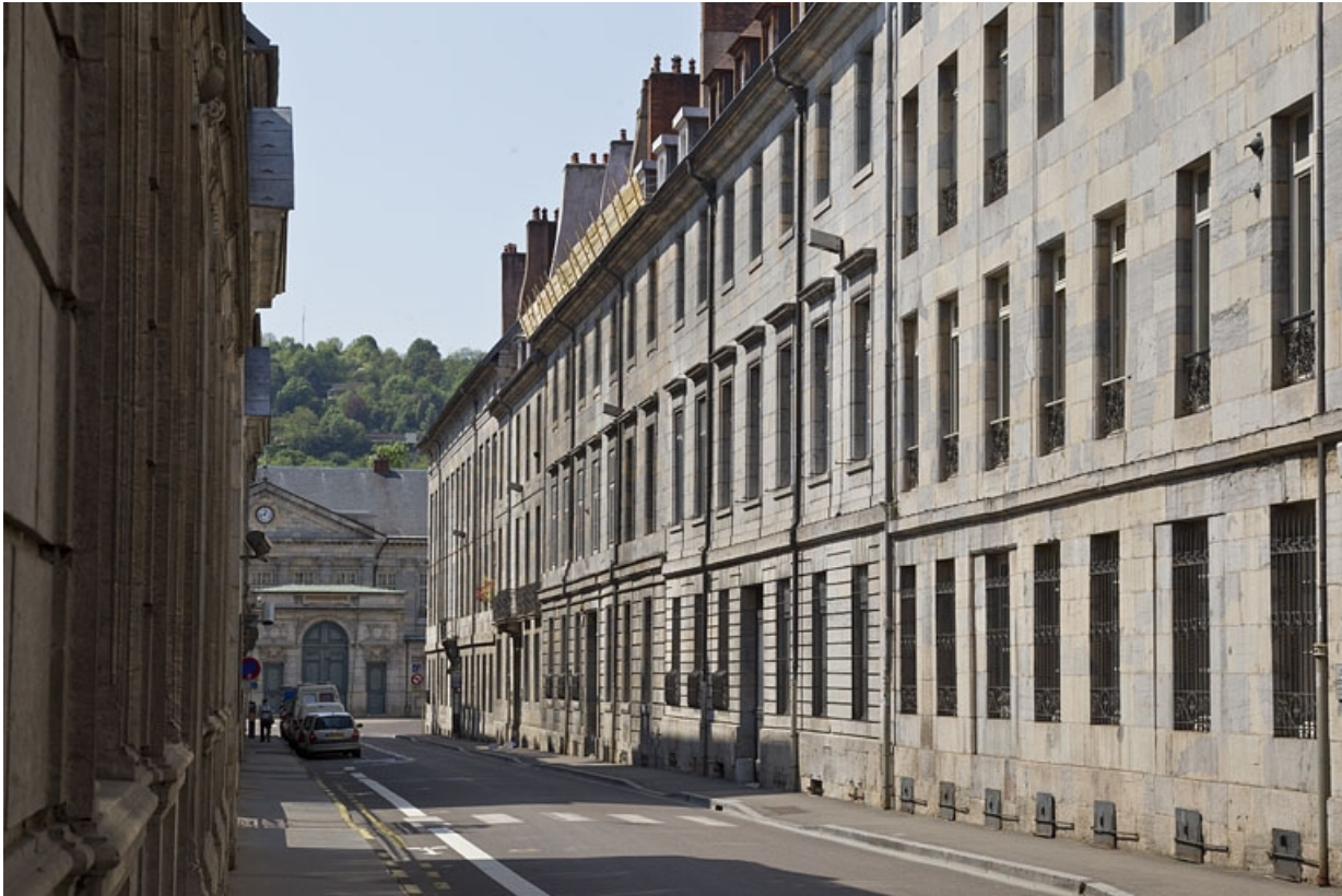
Logis principal, façade sur rue : de trois quarts droit. 25, Besançon, 24 rue de la Préfecture, lieudit : îlot Mairie
