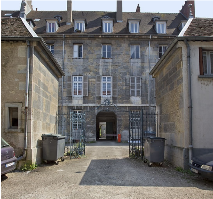
Logis principal, façade postérieure depuis la deuxième cour.
