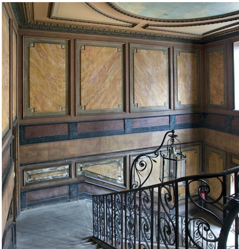
Logis principal, intérieur : détail du décor de la cage d'escalier.
