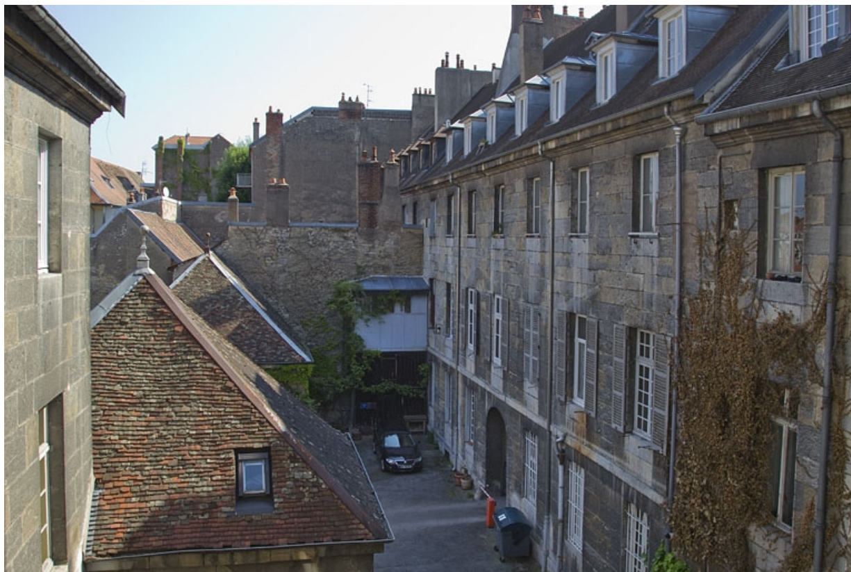
Logis principal : vue de la façade postérieure, de trois quarts droit. 25, Besançon, 24 rue de la Préfecture, lieudit : îlot Mairie
