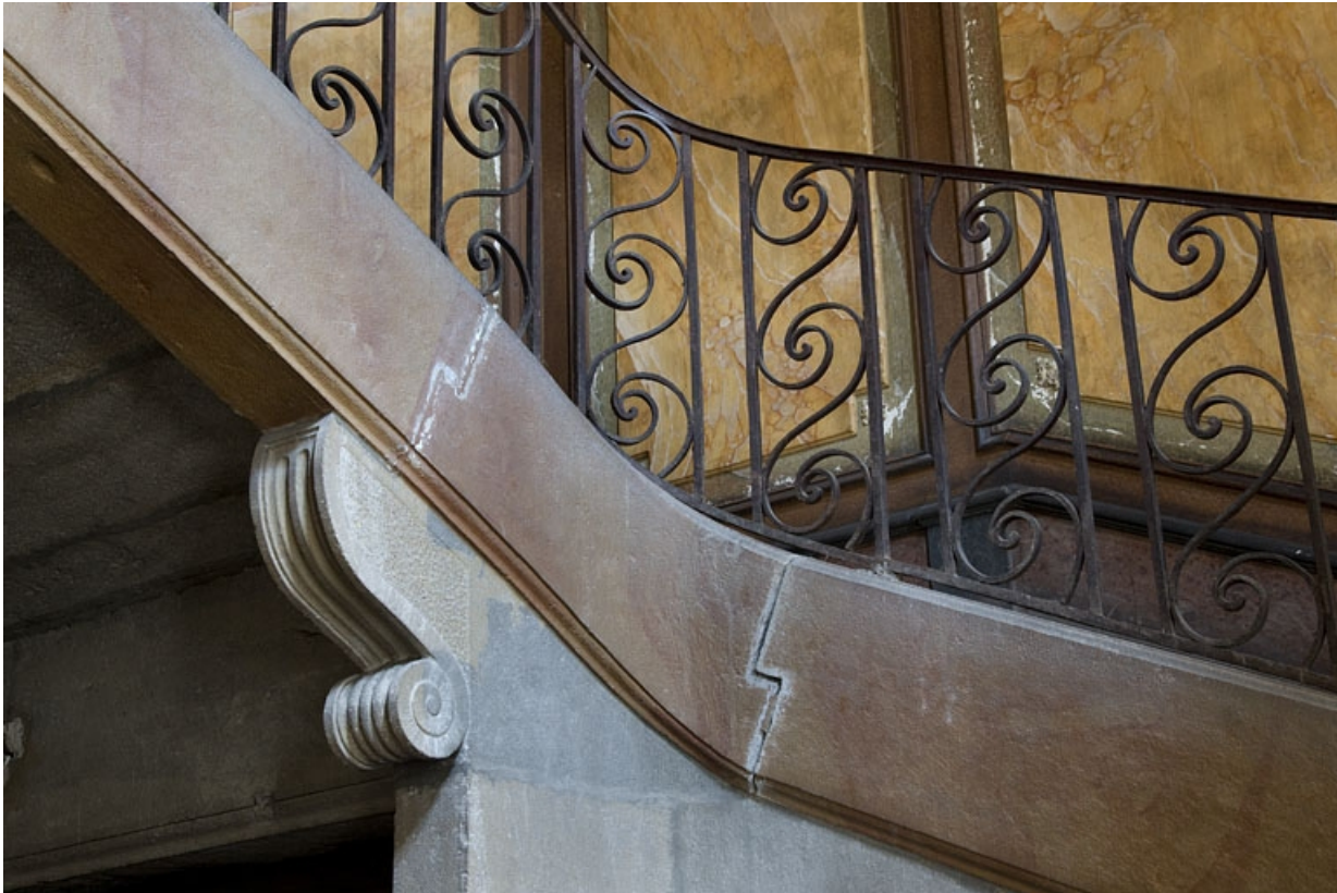
Logis principal, intérieur : détail de rampe en ferronnerie de l'escalier.
