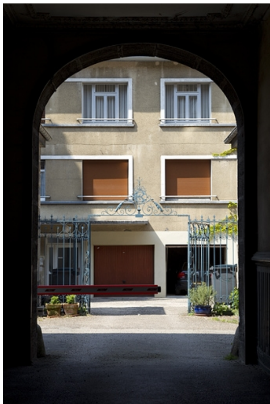
Vue de la façade de l'ancienne clinique depuis le passage cocher.
