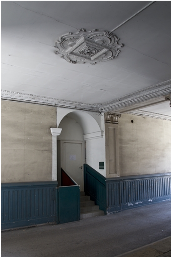
Vue du passage cocher depuis l'entrée de l'escalier. 25, Besançon, 24 rue de la Préfecture, lieudit : îlot Mairie
