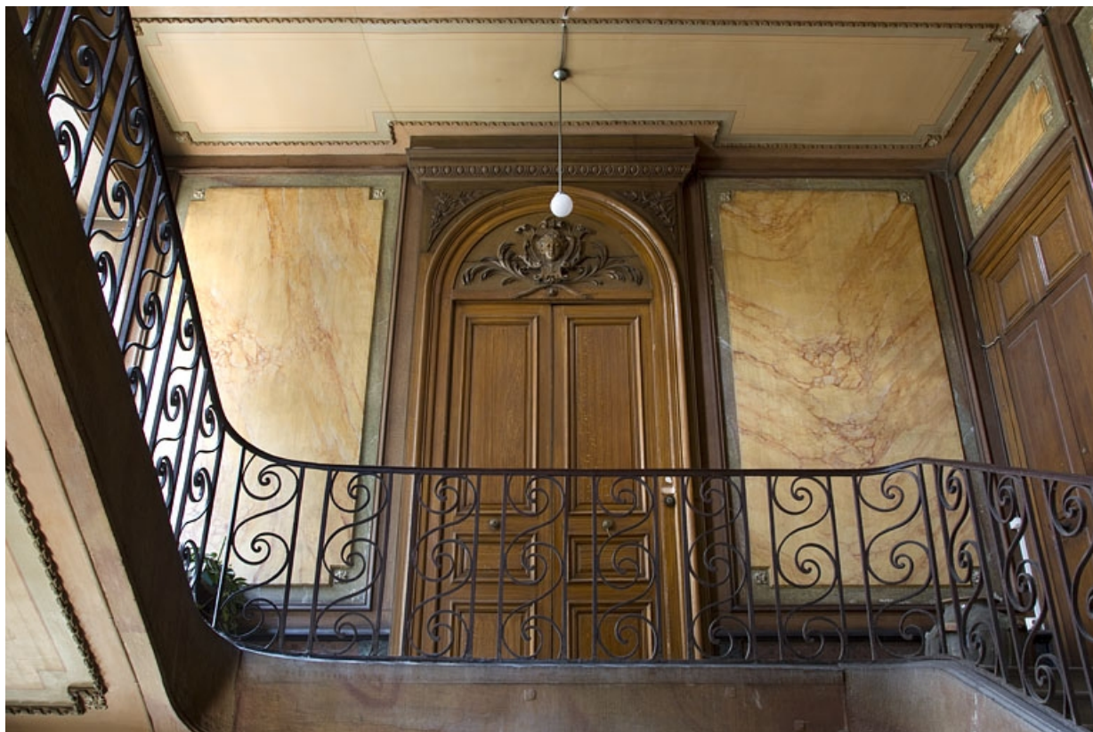
Logis principal, intérieur : détail de la rampe en ferronnerie de l'escalier.
