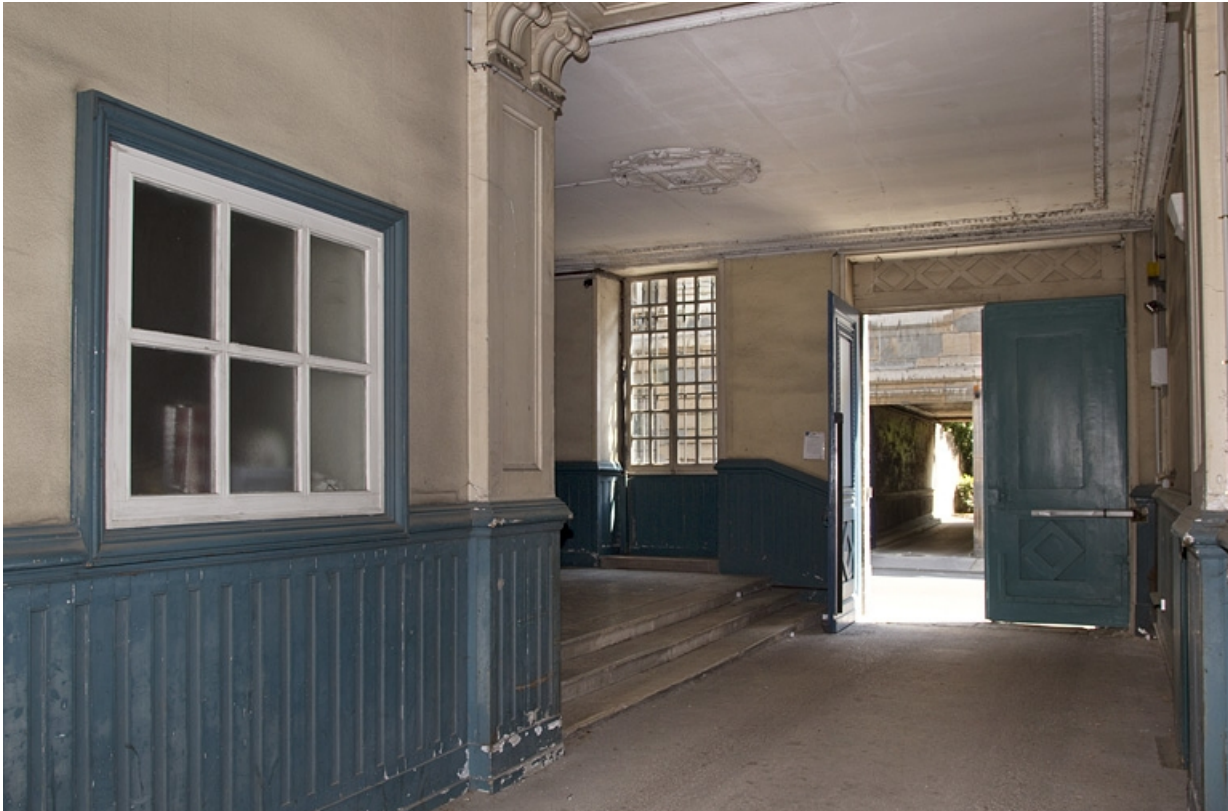
Vue du passage cocher et de l'entrée de l'escalier.
