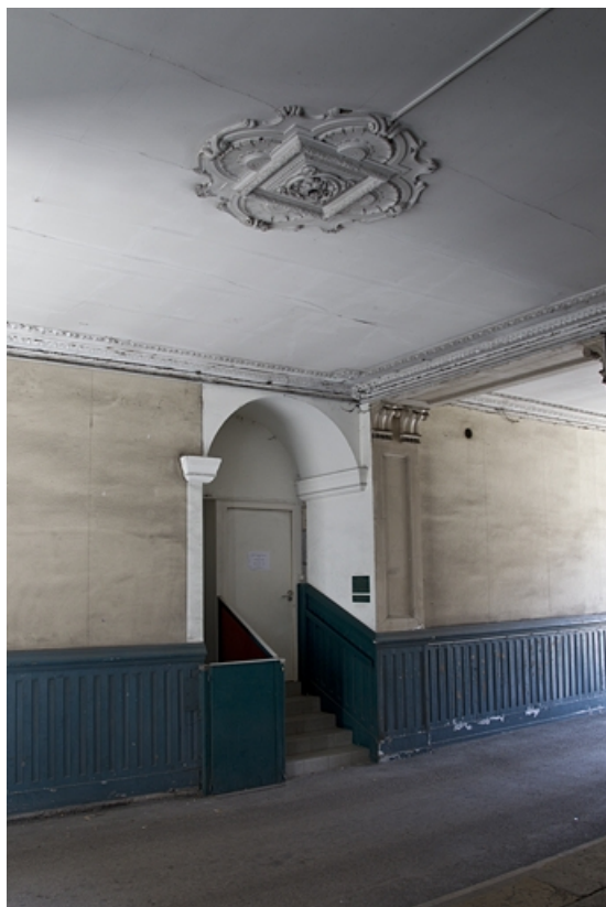
Vue du passage cocher depuis l'entrée de l'escalier. 25, Besançon, 24 rue de la Préfecture, lieudit : îlot Mairie
