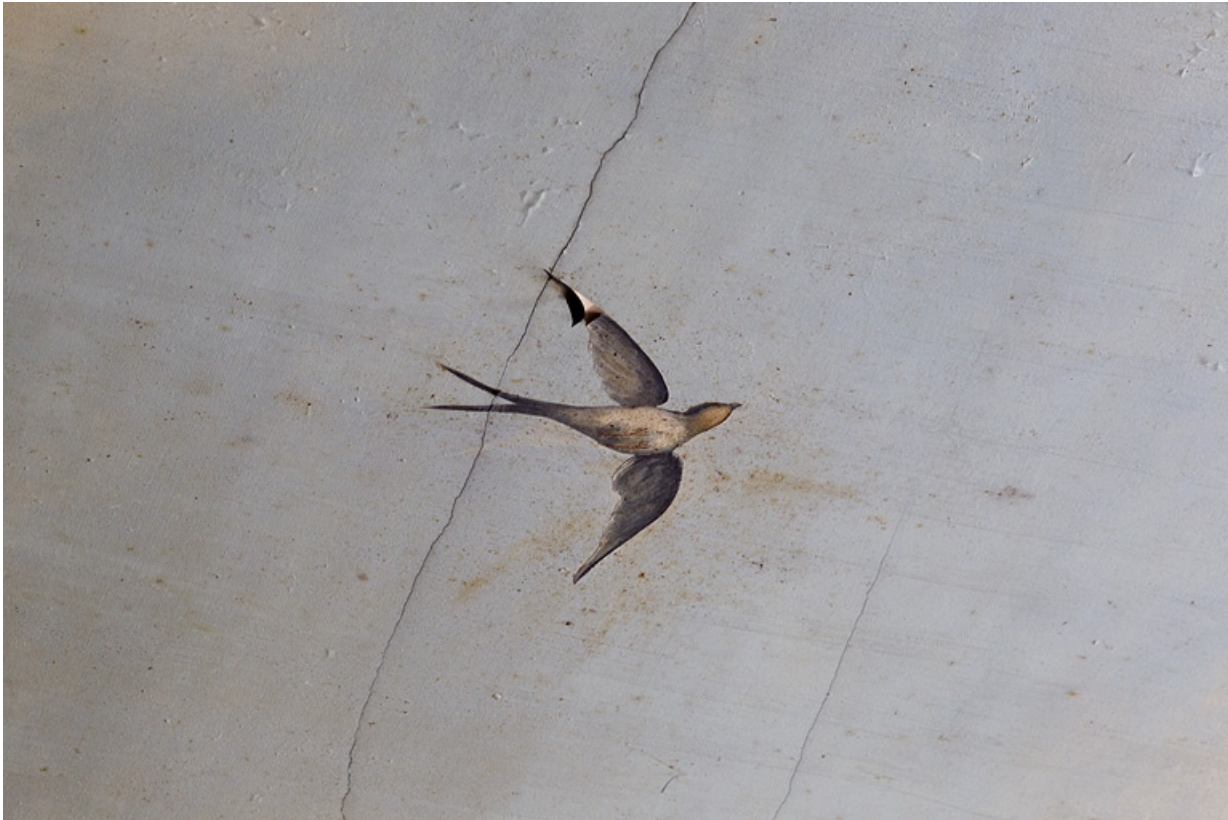
Logis principal, intérieur : plafond de la cage d'escalier, détail d'une hirondelle. 25, Besançon, 24 rue de la Préfecture, lieudit : îlot Mairie
