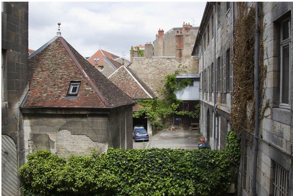
Détail de la première cour depuis l'immeuble voisin. 25, Besançon, 24 rue de la Préfecture, lieudit : îlot Mairie
