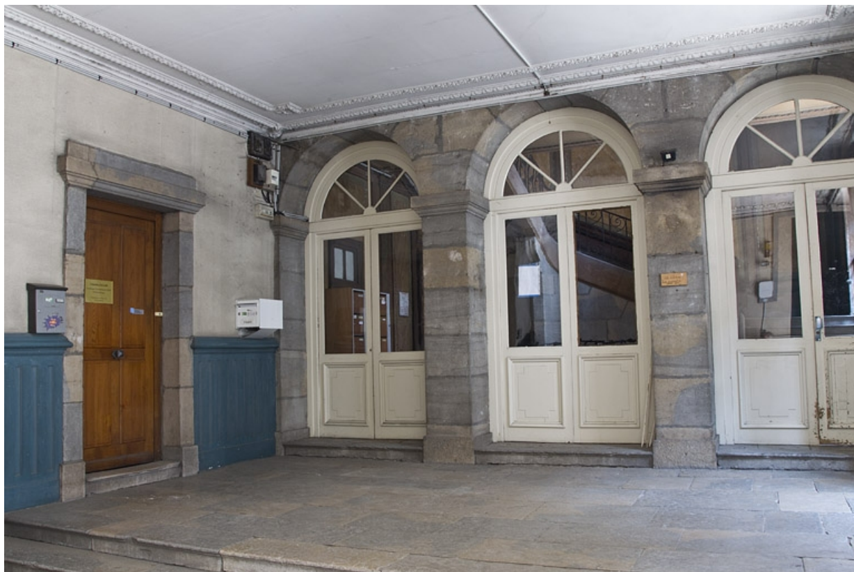
Vue de l'entrée de l'escalier, de trois quarts droit.
