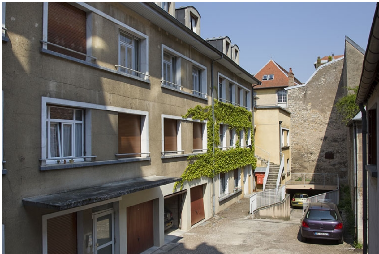
Façade antérieure de l'ancienne clinique, de trois quarts gauche.
