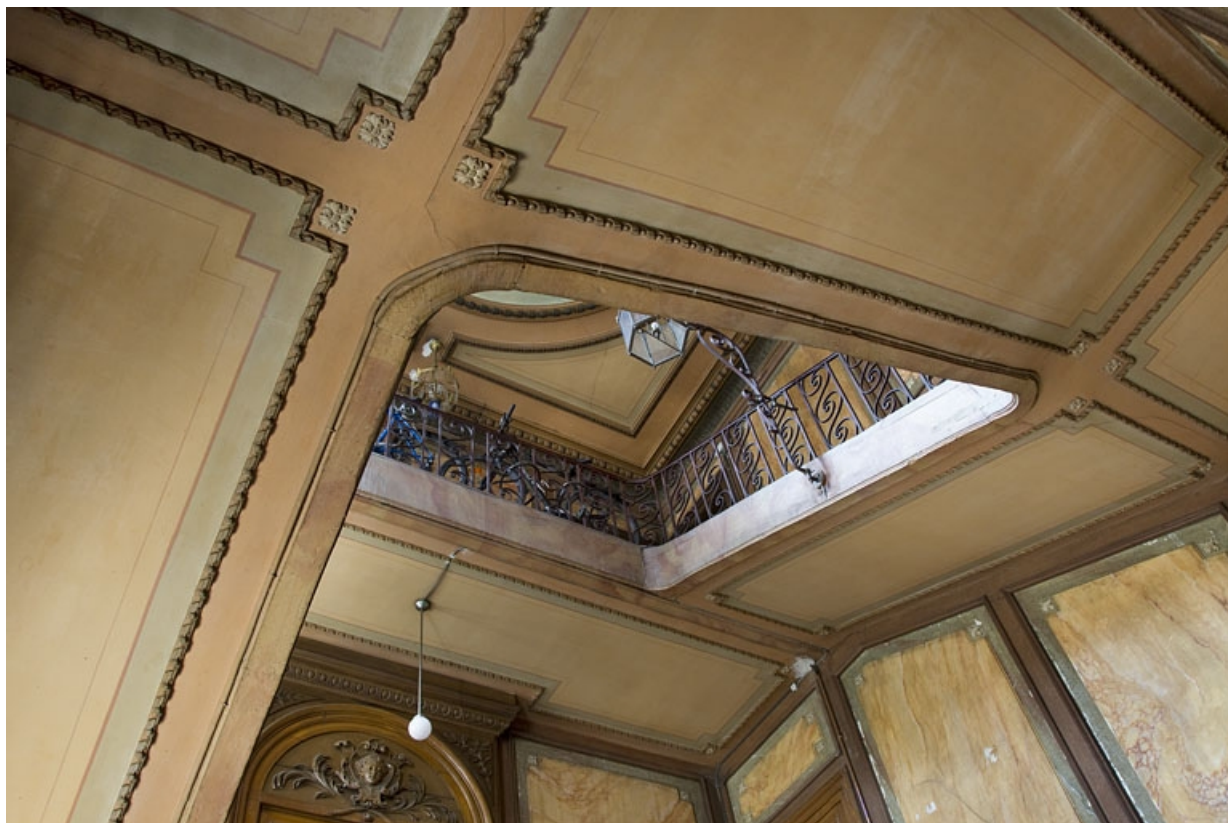
Logis principal, intérieur : vue d'ensemble de la cage d'escalier.
