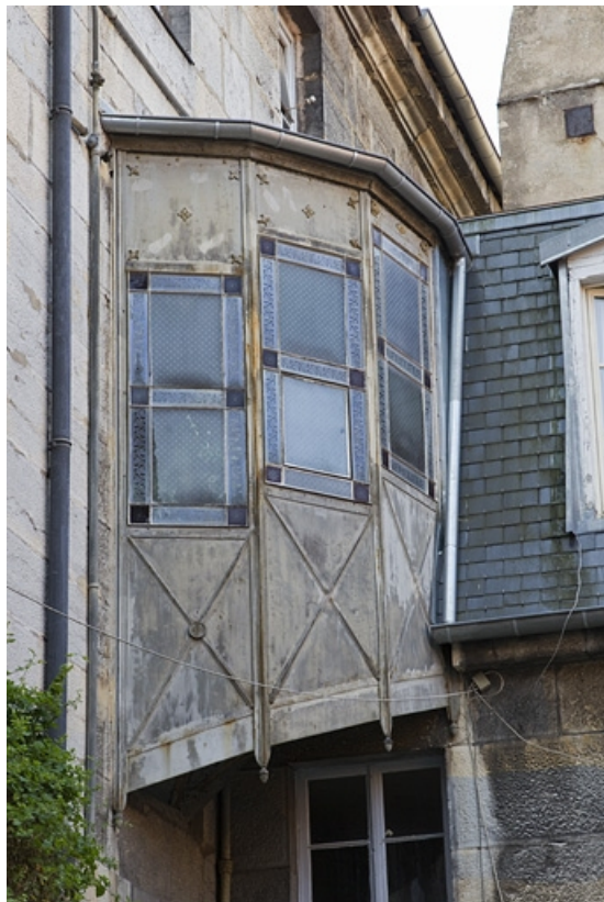
Vue du passage suspendu entre le logis principal et l'aile gauche des communs. 25, Besançon, 22 rue de la Préfecture, lieudit : îlot Mairie
