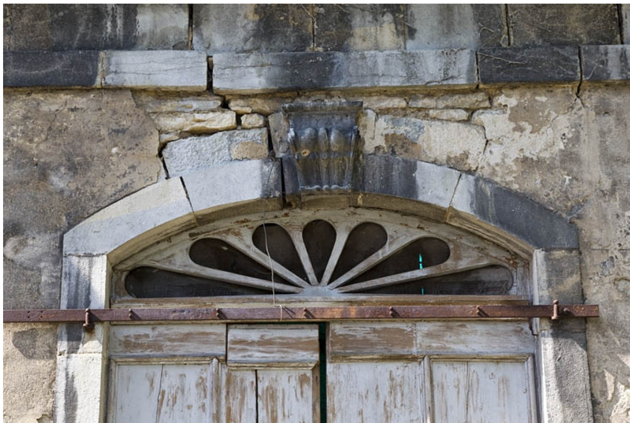
Pavillon de jardin : détail de l'arc de la porte.
