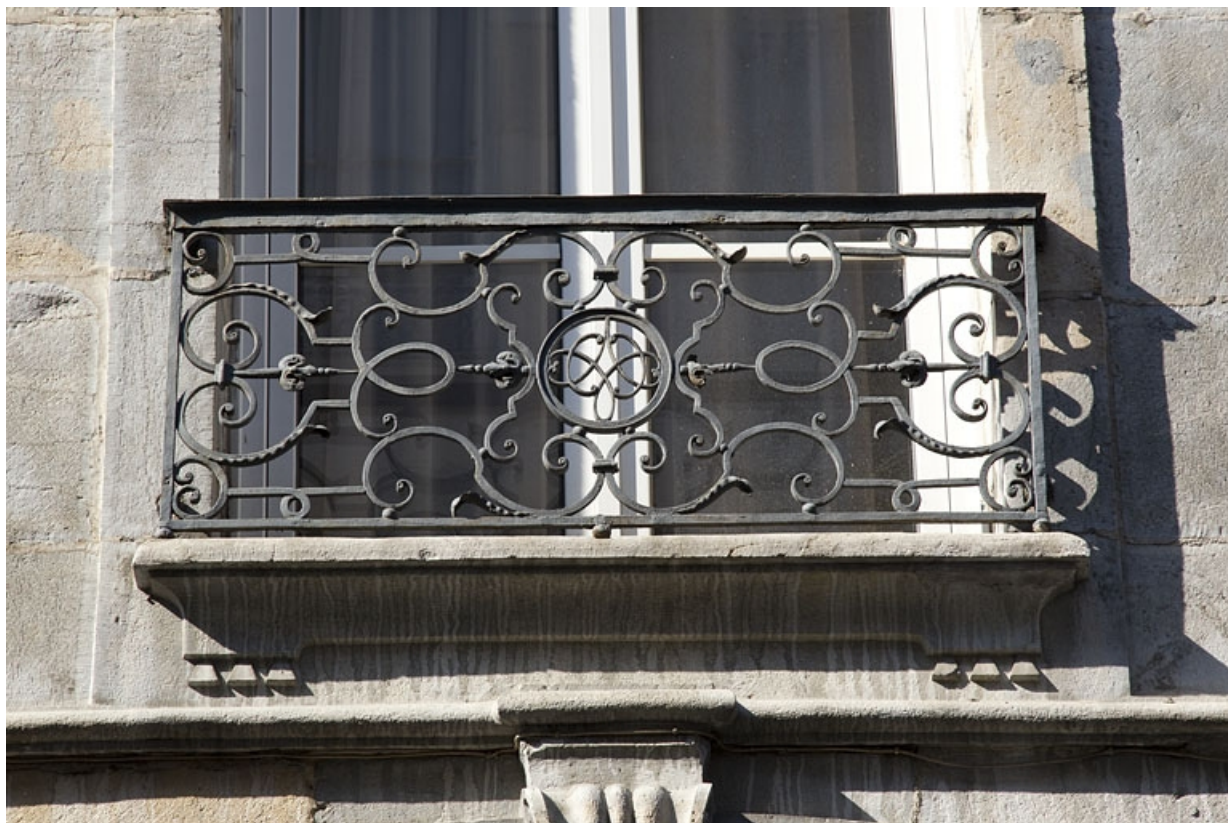
Logis principal, façade sur rue : détail d'un garde-corps en ferronnerie.
