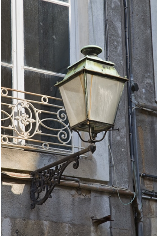
Détail d'un bec de gaz situé dans la cour.
