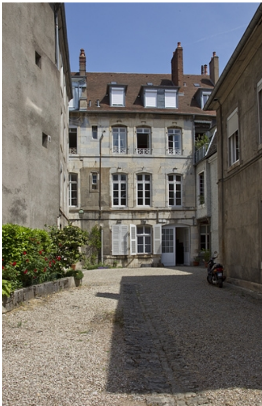
Logis principal, façade postérieure : vue éloignée. 25, Besançon, 14 rue Mégevand, lieudit : îlot Mairie
