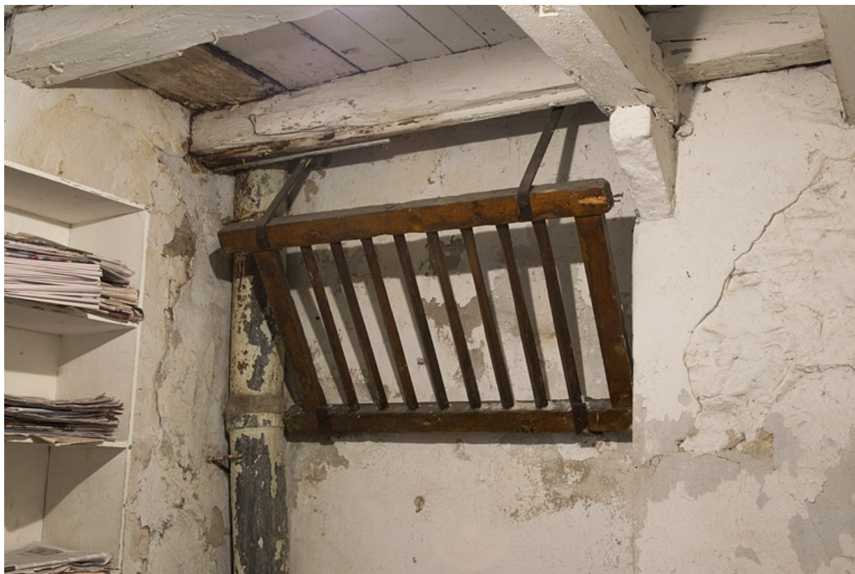
Ecurie : vue d'un râtelier.
