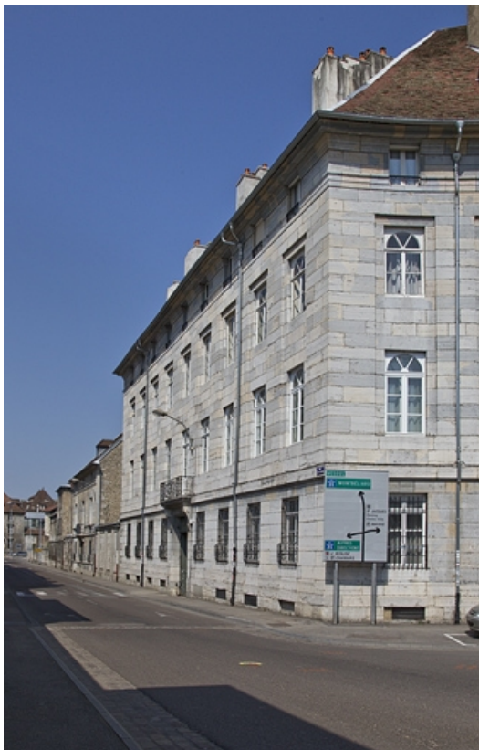
Logis principal, façade rue Charles Nodier : vue d'ensemble, de trois quarts droit. 25, Besançon, 5 rue Charles Nodier, lieudit : îlot Mairie
