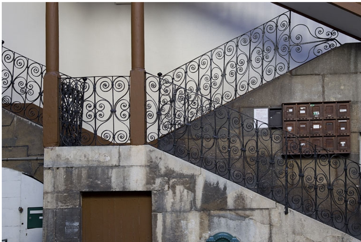
Escalier à cage ouverte à droite de la première cour : détail de la rampe en ferronnerie.
