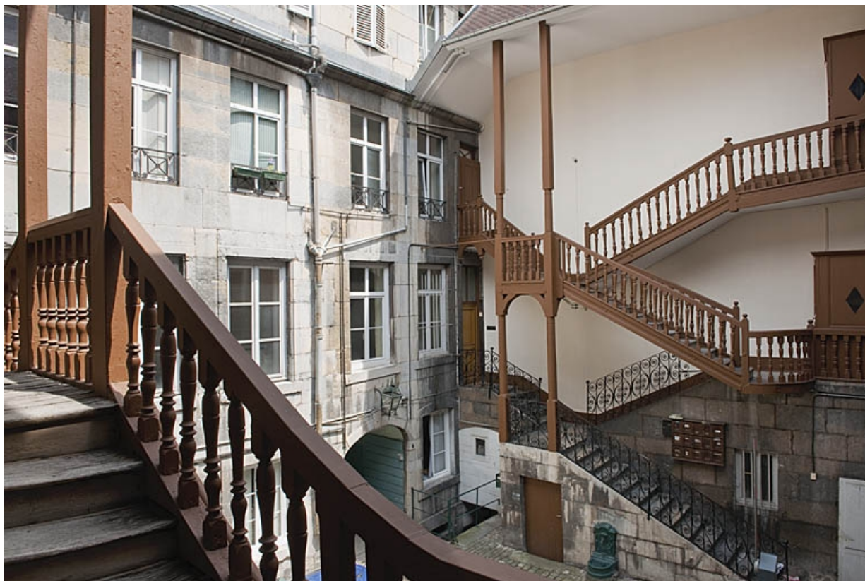
Vue d'ensemble de l'escalier à cage ouverte à droite de la première cour, de trois quarts droit. 25, Besançon, 103 rue des Granges, lieudit : îlot Jean Cornet
