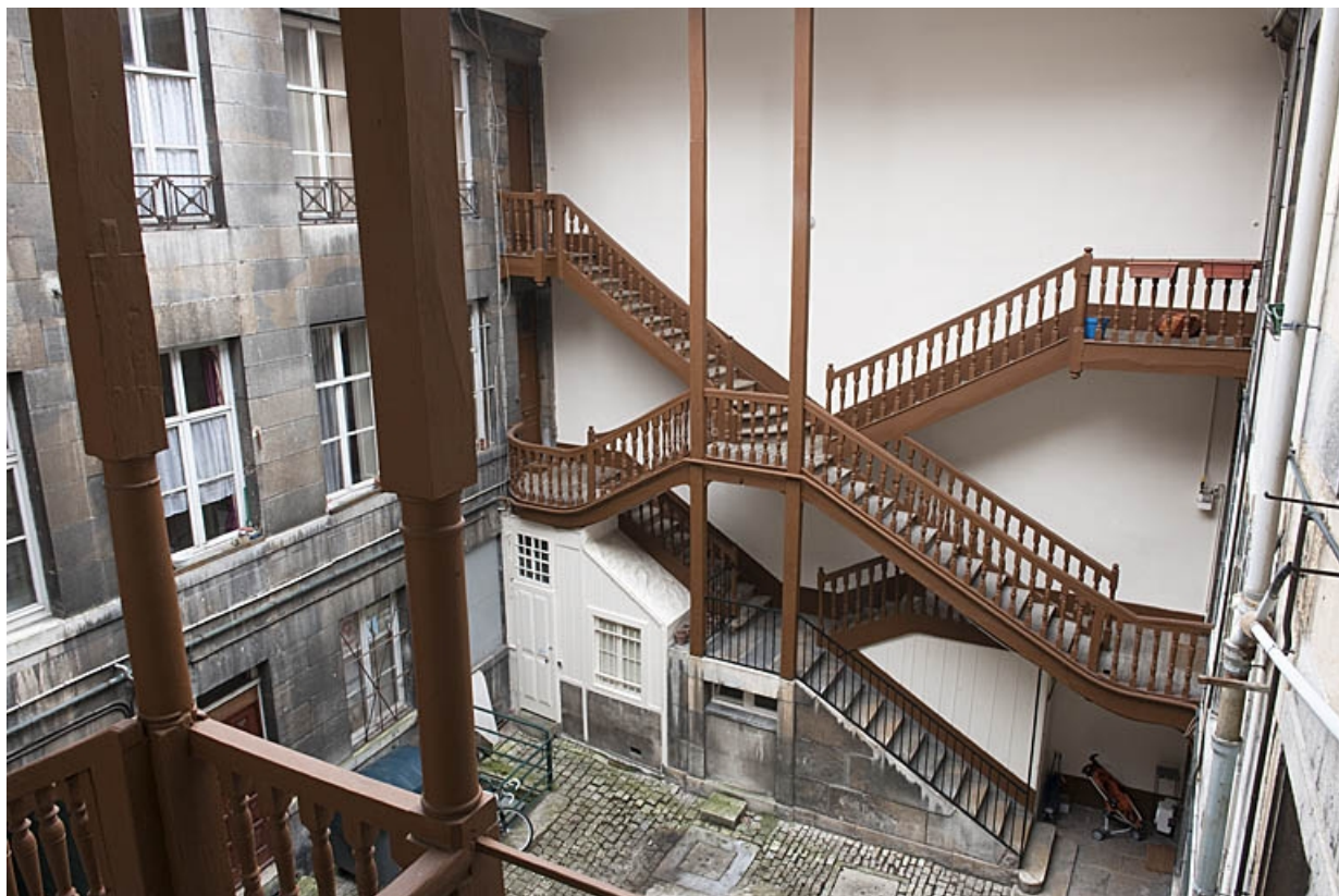
Vue d'ensemble de l'escalier à cage ouverte à gauche de la première cour, depuis l'escalier droit.
