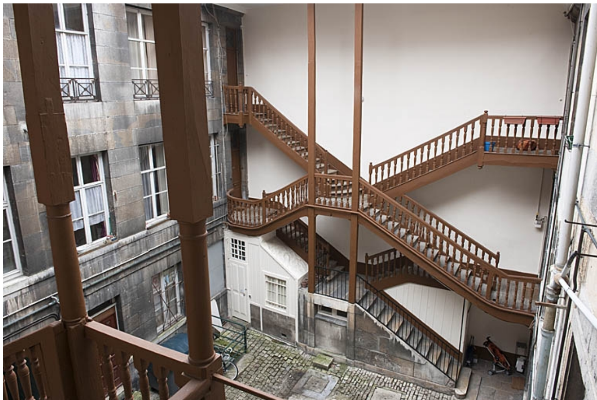
Vue d'ensemble de l'escalier à cage ouverte à gauche de la première cour, depuis l'escalier droit.
