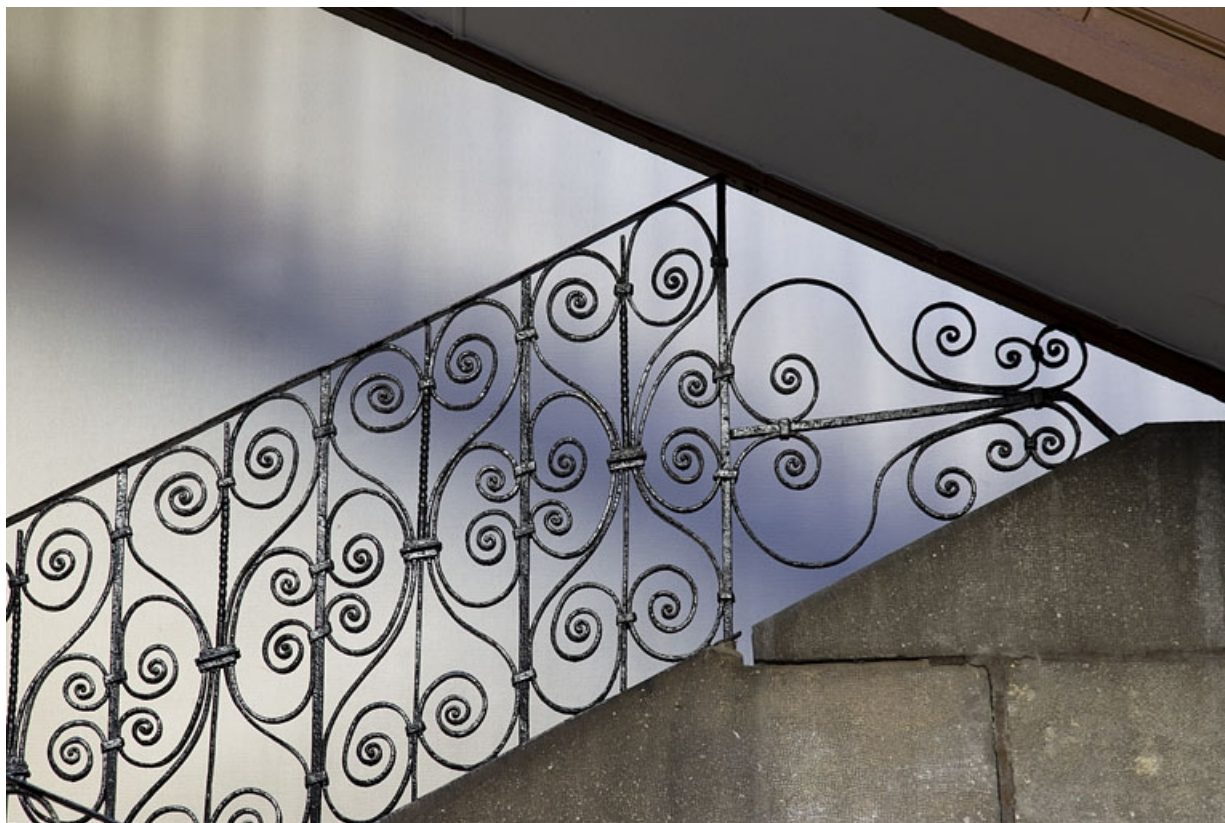
Escalier à cage ouverte à droite de la première cour : détail du décor de la rampe en ferronnerie.
