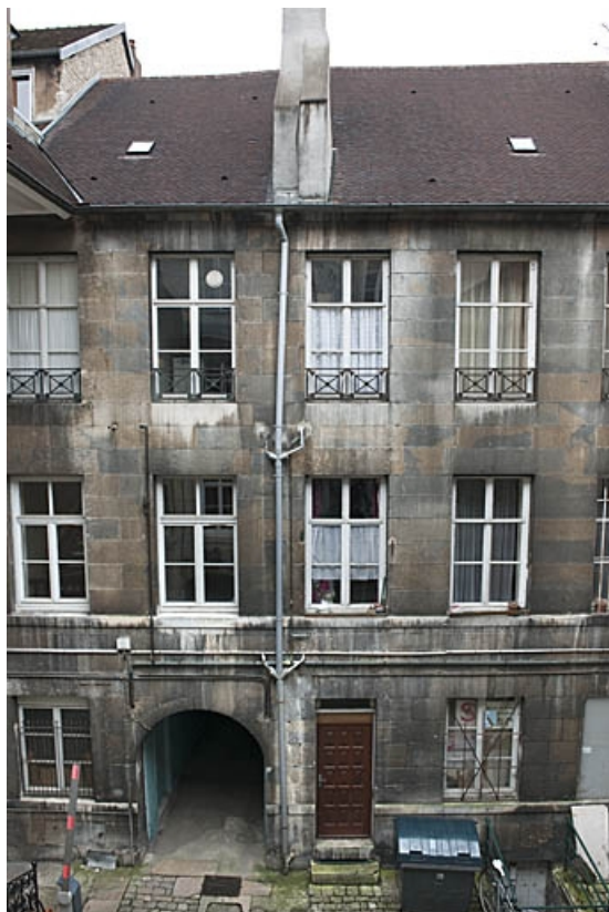
Logis principal : vue d'ensemble de la façade postérieure. 25, Besançon, 103 rue des Granges, lieudit : îlot Jean Cornet
