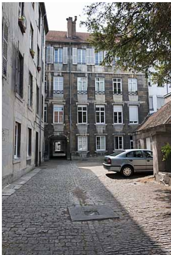
Vue d'ensemble de la façade postérieure du premier logis secondaire donnant sur la deuxième cour. 25, Besançon, 103 rue des Granges, lieudit : îlot Jean Cornet
