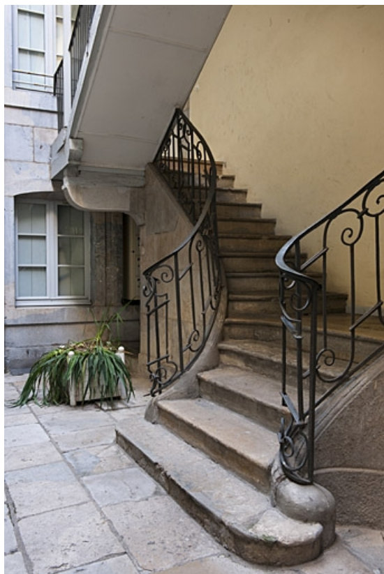
Départ de l'escalier à cage ouverte situé dans la première cour : vue d'ensemble.
