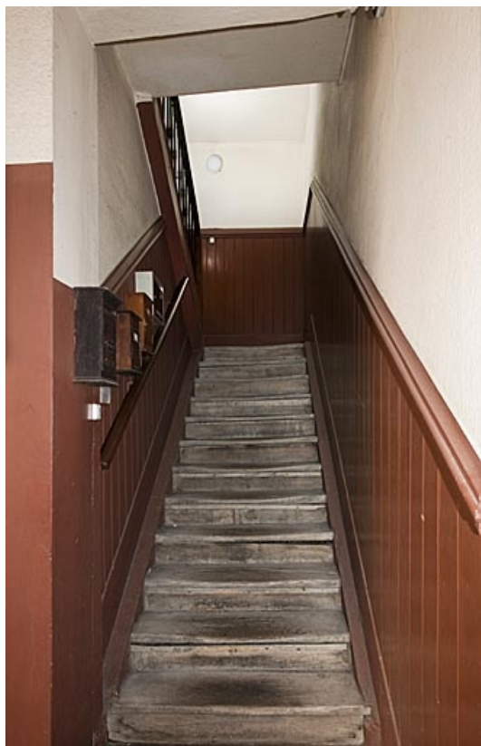
Logis principal : détail de l'escalier à droite du passage cocher.
