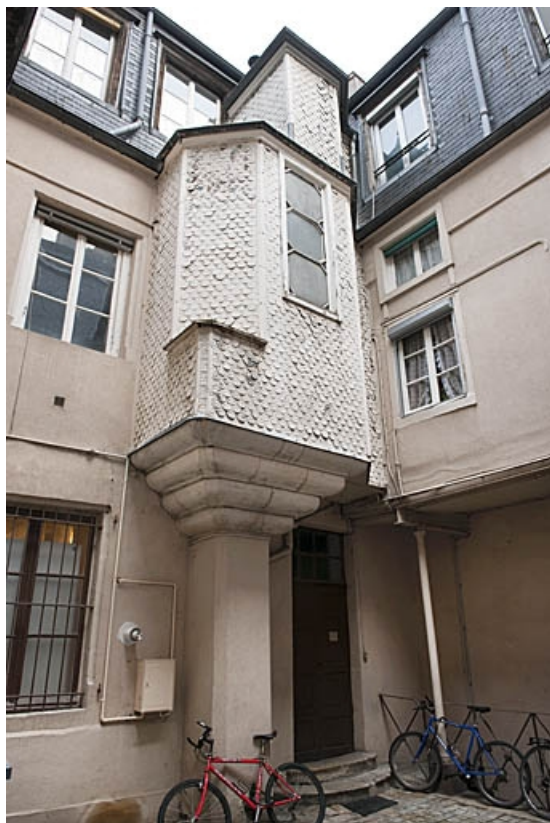
Logis principal : détail de l'avant-corps sur pilier à gauche de la première cour. 25, Besançon, 83 rue des Granges, lieudit : îlot Jean Cornet
