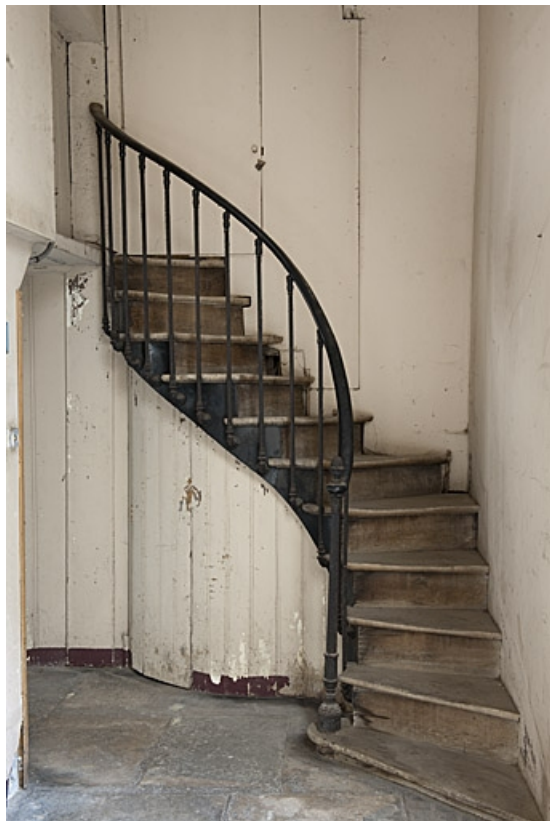
Logis principal : détail du départ d'un escalier secondaire au fond de la première cour. 25, Besançon, 83 rue des Granges, lieudit : îlot Jean Cornet
