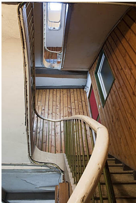
Logis principal : détail de l'escalier situé dans l'aile gauche.
