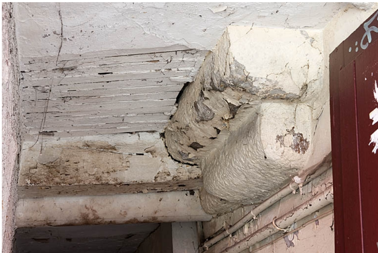
Logis principal : détail d'un encorbellement de cheminée dans le couloir d'entrée.
