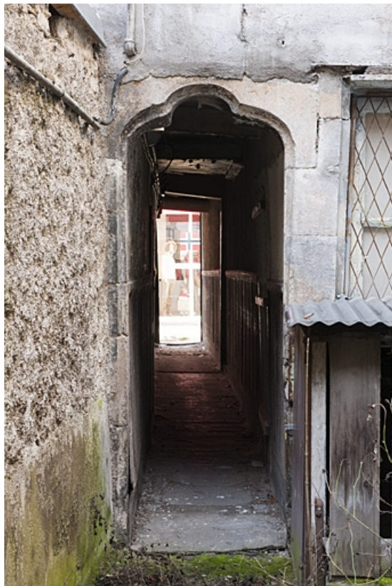
Façade postérieure du logis principal : détail de l'entrée du couloir. 25, Besançon, 8 rue Bersot, lieudit : îlot Jean Cornet
