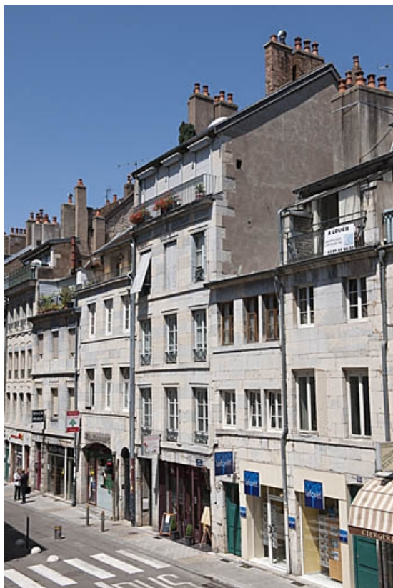
Vue d'ensemble éloignée du logis principal depuis la rue. 25, Besançon, 95 rue des Granges, lieudit : îlot Jean Cornet
