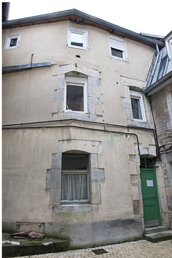
Aile contenant un escalier secondaire à gauche de la deuxième cour. 25, Besançon, 95 rue des Granges, lieudit : îlot Jean Cornet
