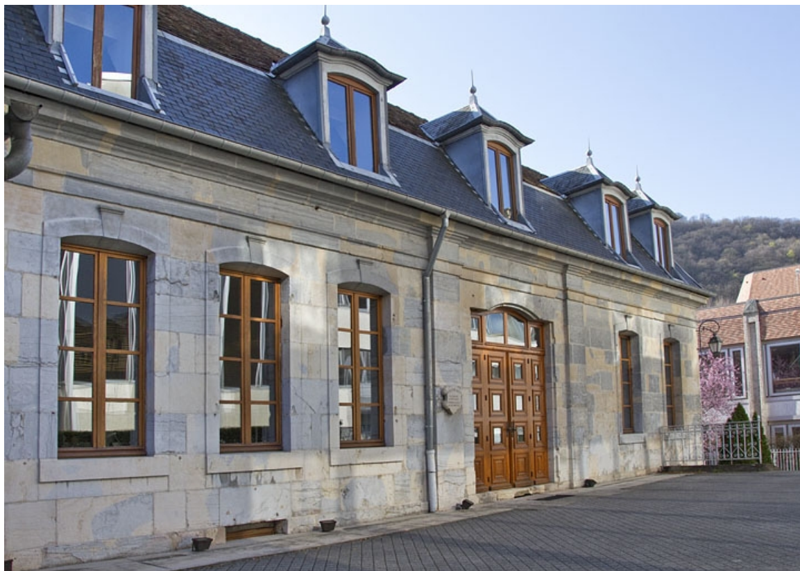
Vue d'ensemble de la façade antérieure, de trois quarts gauche.
