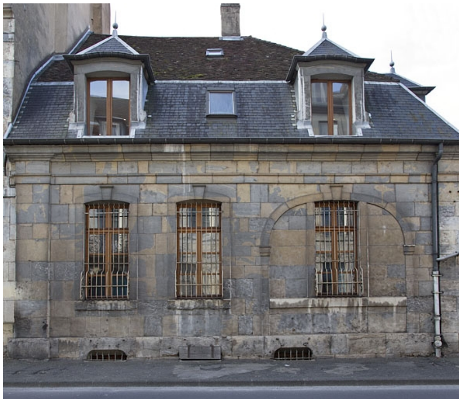
Logis principal, façade latérale gauche : vue d'ensemble, de face.
