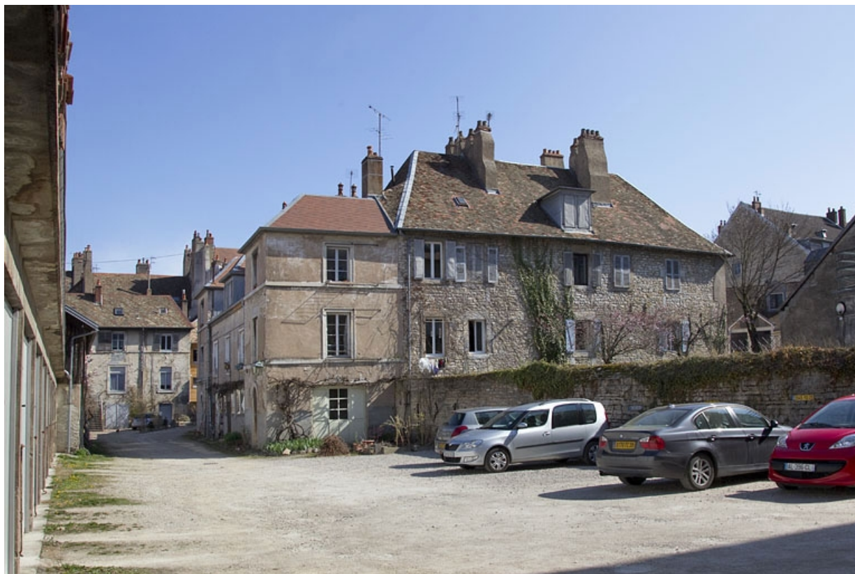
Vue d'ensemble des bâtiments depuis le fond de la deuxième cour.
