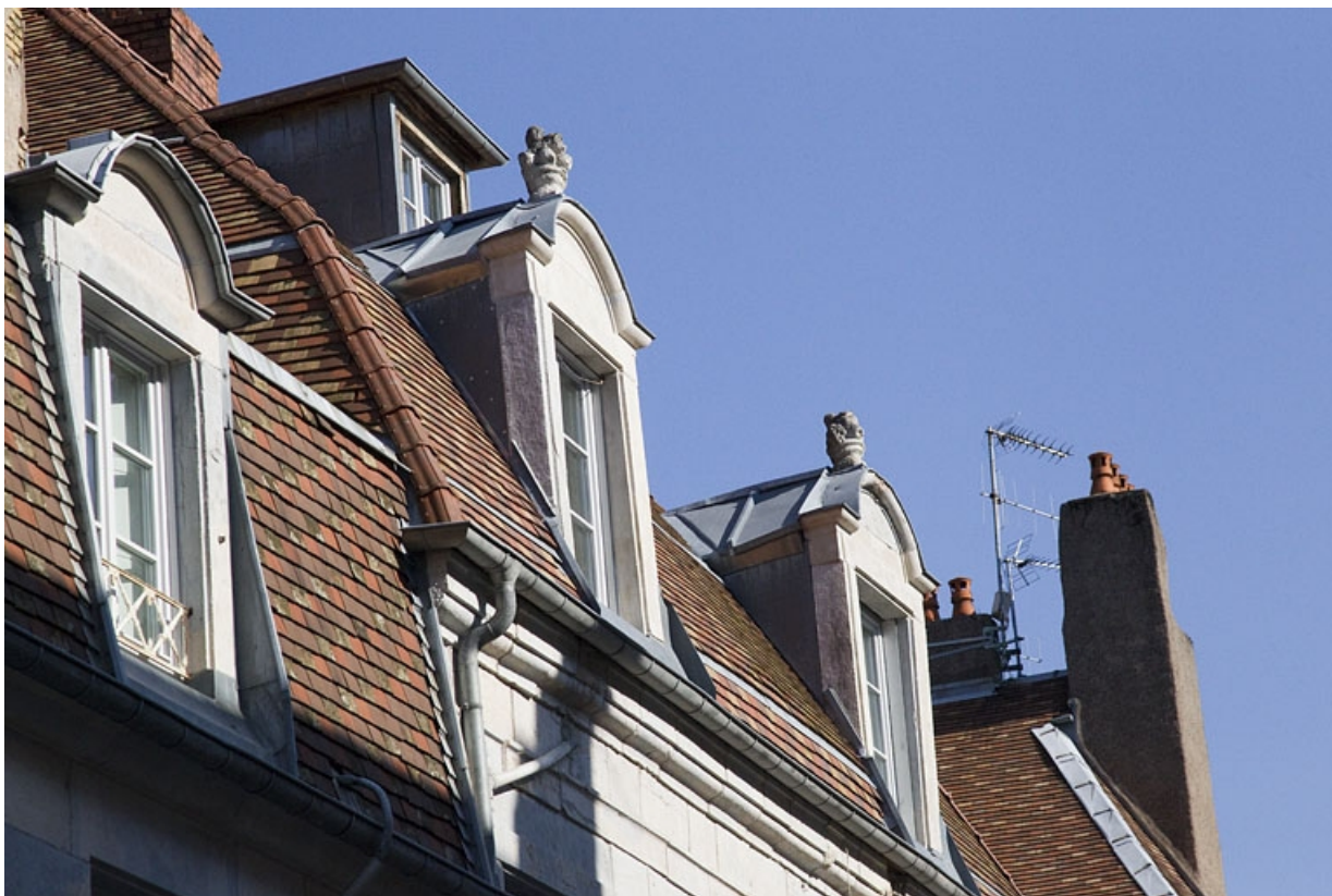
Détail des lucarnes sur le versant de toit donnant rue du Porteau.
