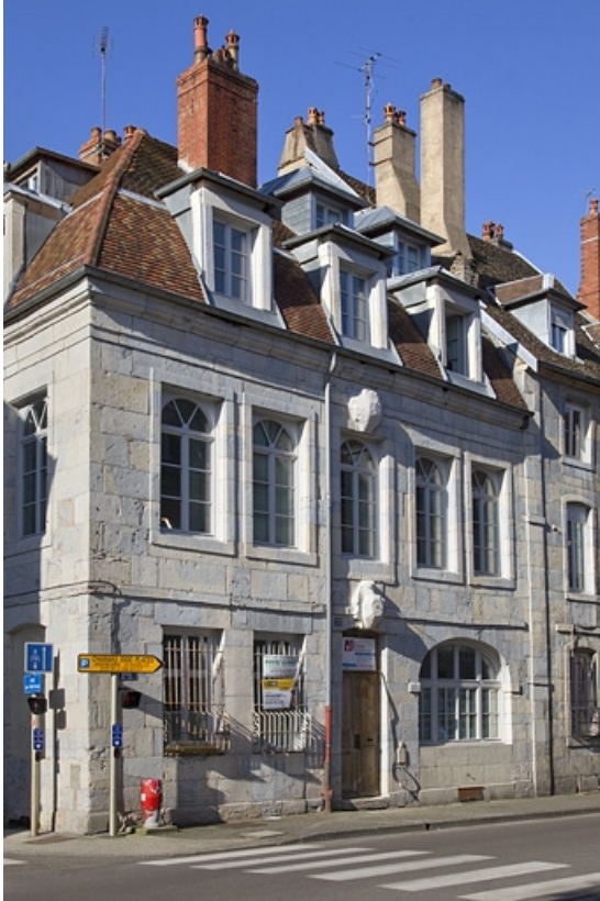
Façade antérieure : vue d'ensemble de trois quarts gauche.
