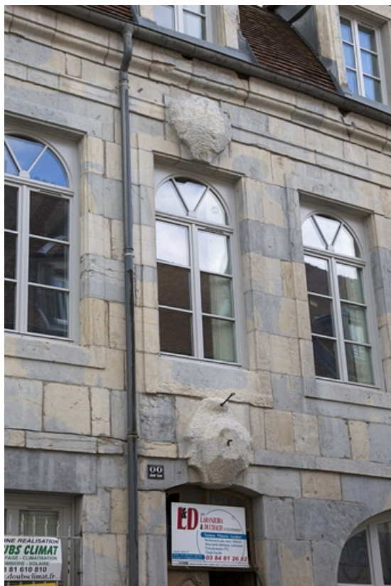
Façade antérieure : détail des pierres d'attente épannelées sur la porte du couloir et d'une fenêtre de l'étage. 25, Besançon, 22 rue Charles Nodier, lieudit : îlot Préfecture
