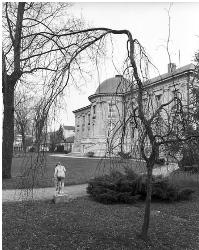
Façade postérieure, de trois quarts droit, avec une statue du parc : vue éloignée. 25, Besançon, 8bis, 10 rue Charles Nodier, lieudit : îlot Préfecture
