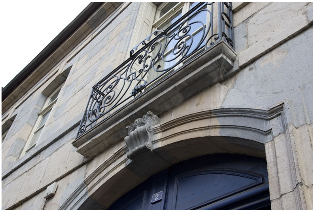
Façade antérieure : détail du balcon en ferronnerie, de trois quarts droit.
